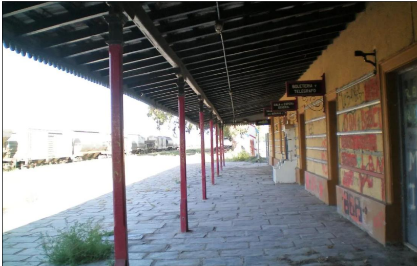
Vista andén Estación Padre Stefenelli.
