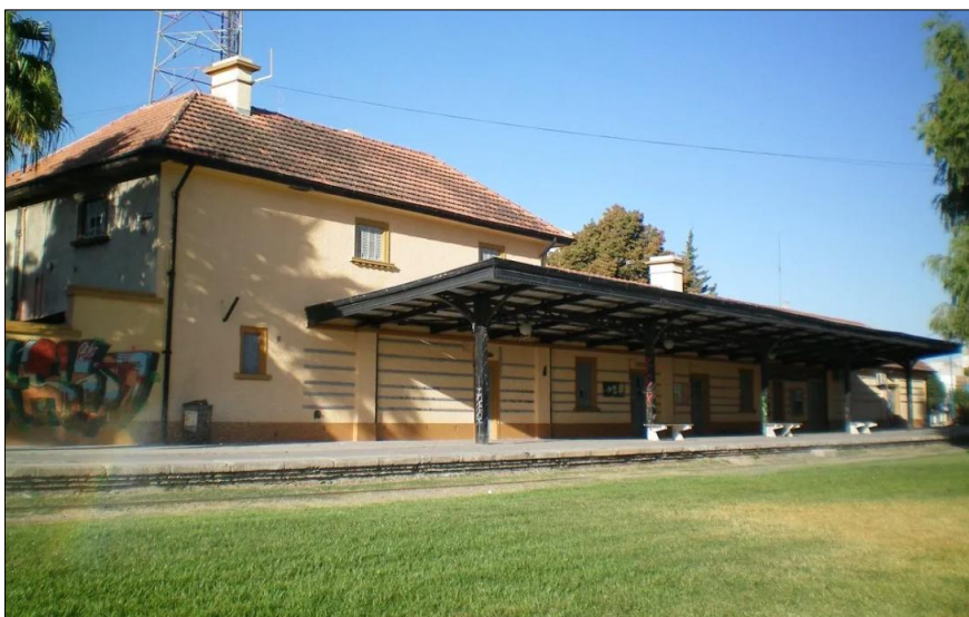
Edificio Estación Fuerte Gral. Roca.
