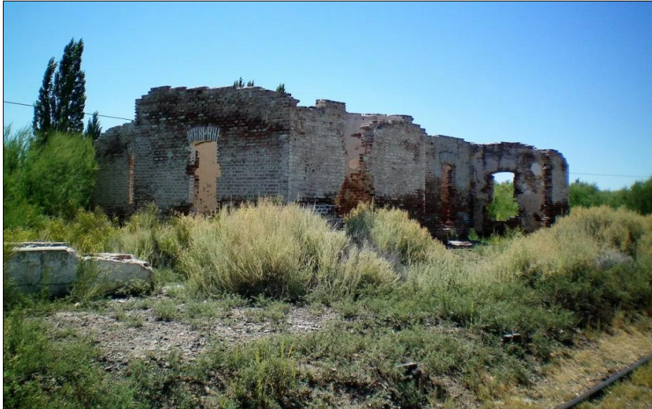
Estado actual del edificio Estación C. Guerrico.
