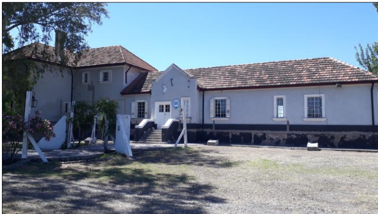
Vista frente de la Estación General Fernández Oro.
