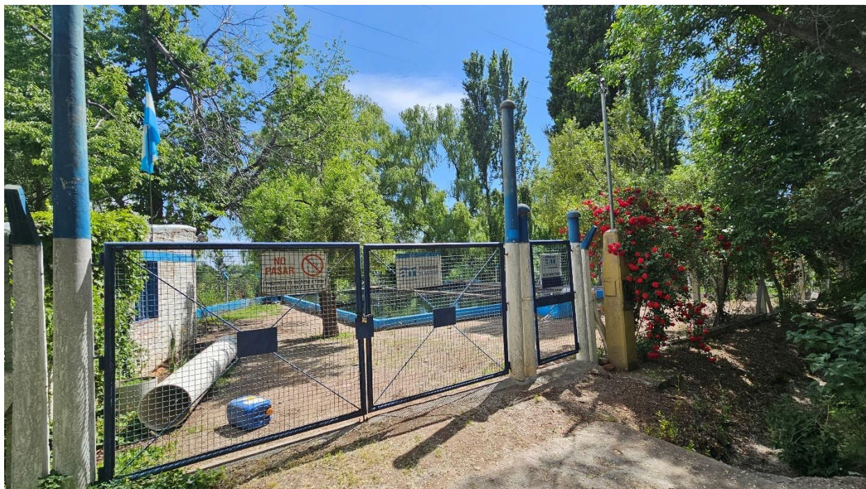
Figura 7. Planta de agua potable de AySAM en CDLA. Tunuyán, Mendoza
