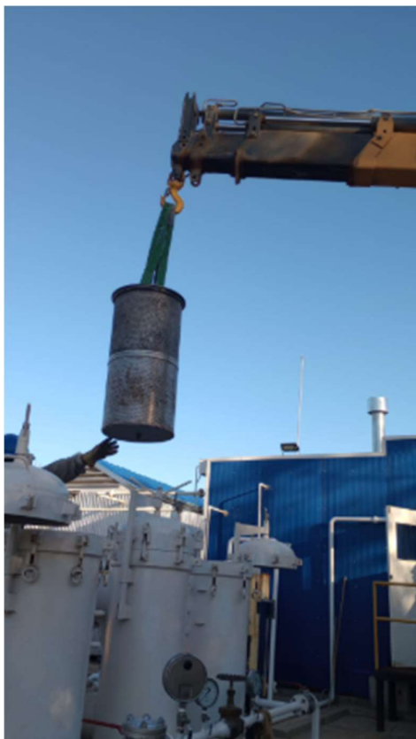
Imagen 13. Desarme del filtro con Hidrogrúa para su reacondicionamiento
