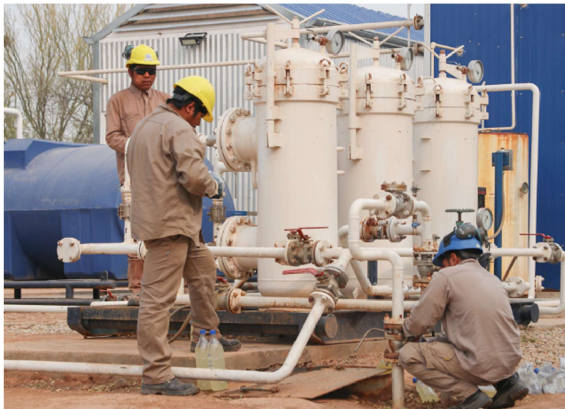
Imagen 11. Ajustes en el sistema de filtros
