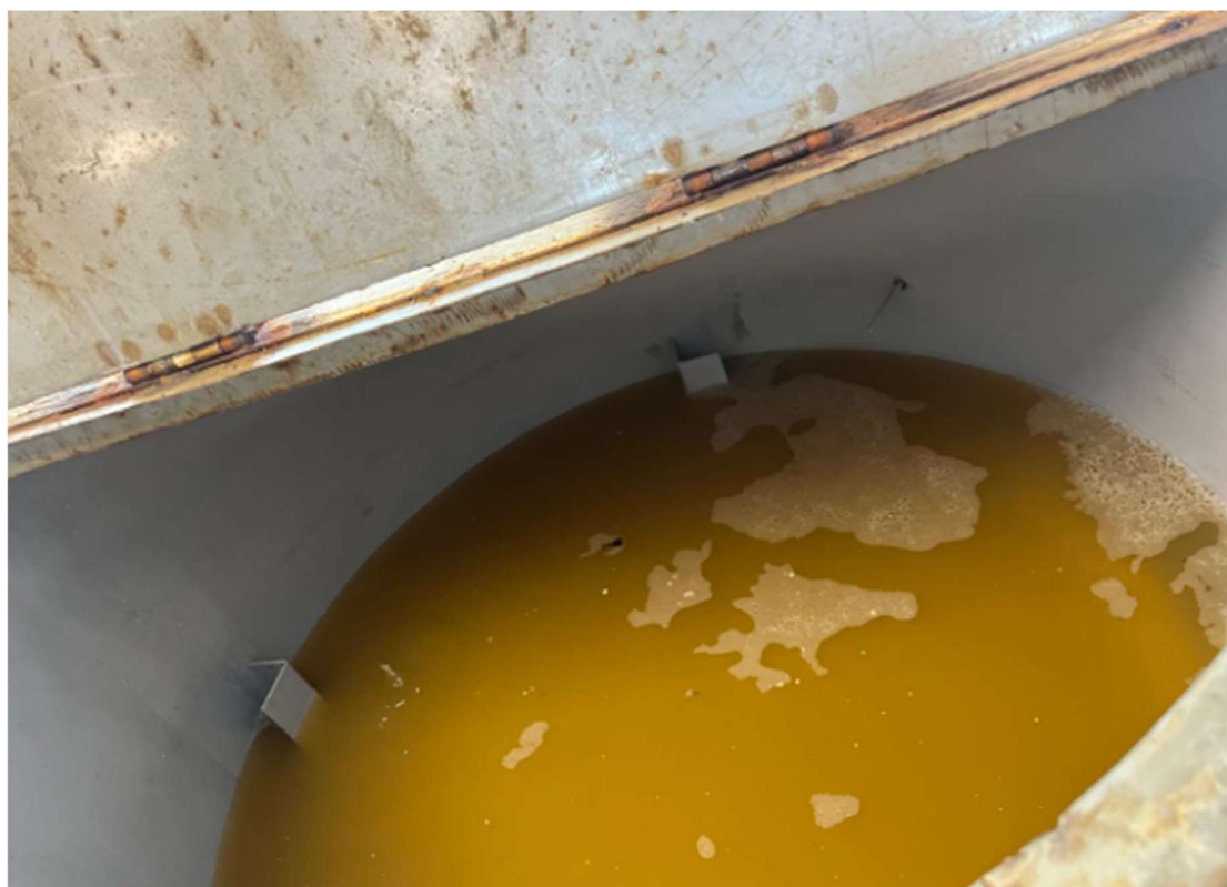
Imagen 18. Limpieza de tanques internos en planta piloto
