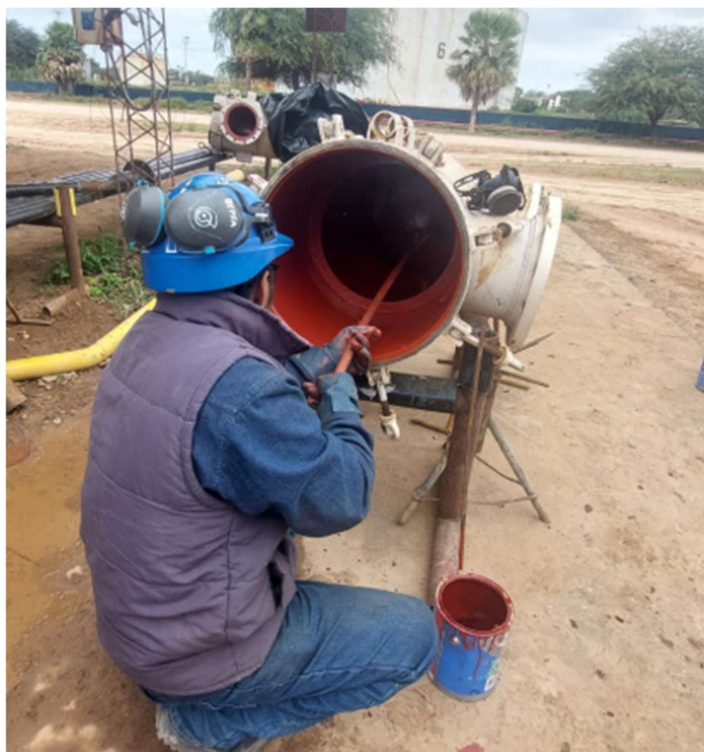
Imagen 16. Reparación de carcasa de filtro - aplicación de antióxido
