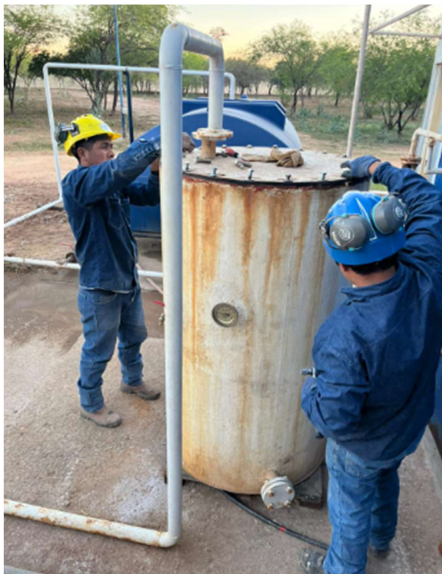
Imagen 3. Operarios desarmando tanque calentador para su limpieza
