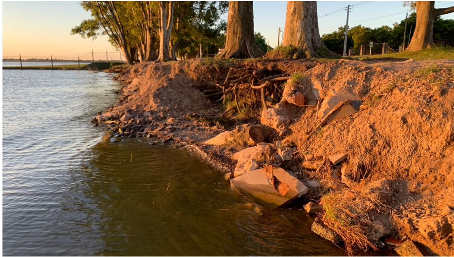
Ilustración – Deterioro costero con raíces expuestas
