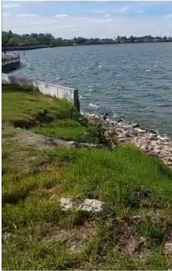
Ilustración – Muros en Sectores Costeros – laguna de Monte
