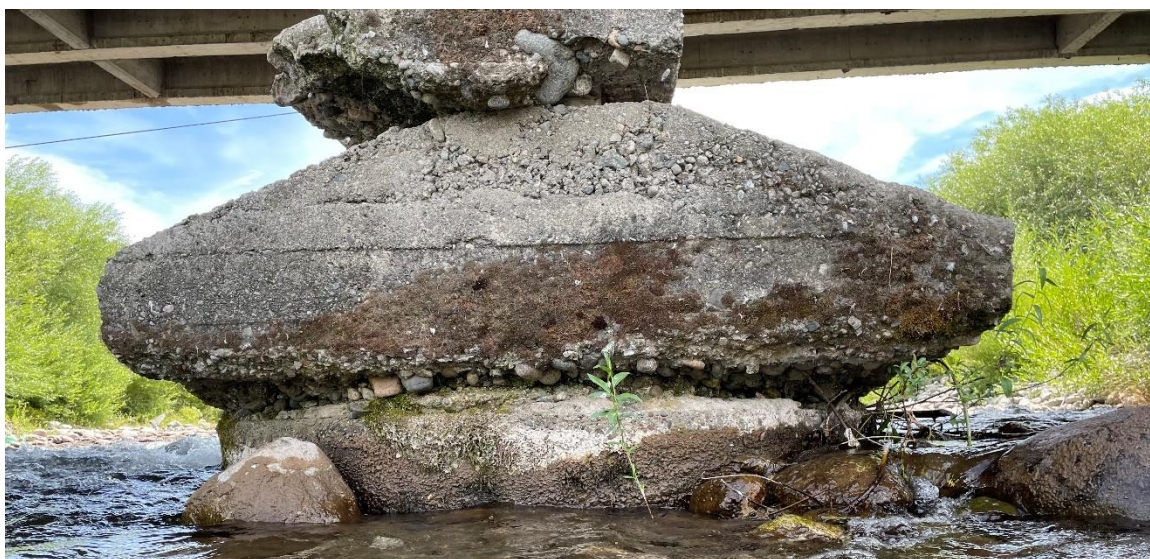
Figura No. 4. Vista del cabezal de fundación y el cilindro de fundación de una de las pilas del puente Francisco de Asís (enero de 2025).
