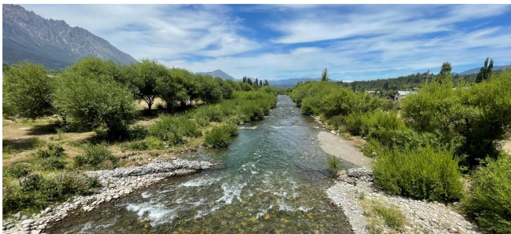
Figura No. 8. Vista hacia aguas abajo del cauce del Río Quemquemtreu desde el puente Francisco de Asís. Se observan los espigones enfrentados.
