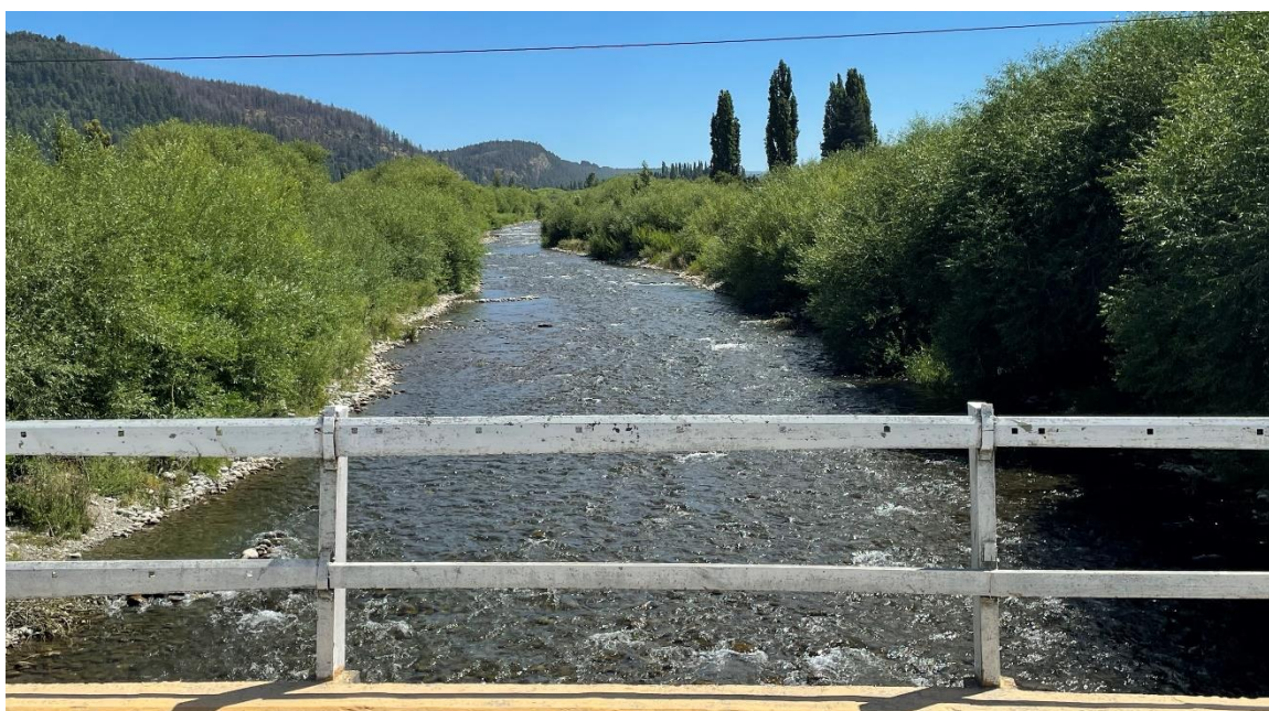
Figura No. 10. Vista actual (enero 2025) del tramo mostrado en la figura 8. Obsérvese el crecimiento de la vegetación en menos de 10 años.
