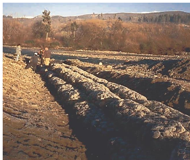
Figura No. 7. Construcción de espigón en la margen del Río Quemquemtrey con la finalidad de concentrar el flujo por el sector central (Fuente: Reverter et al., 2005)
