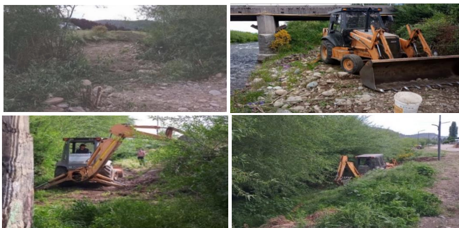
Figura No. 7 Tareas de limpieza y desmalezado. Arriba, margen derecha. Abajo, margen izquierdo.
