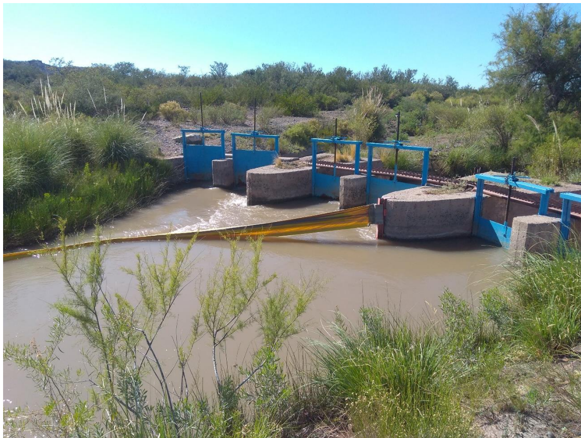
Figura 22. .Antetoma. De izquierda a derecha el Principal Ampliación El Sauzal, el Principal El Sauzal y el descargador al río.
