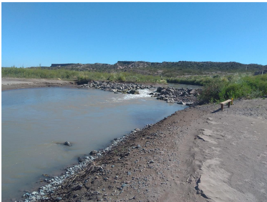
Figura 21. Azud de enrocado sobre brazo del río Colorado
