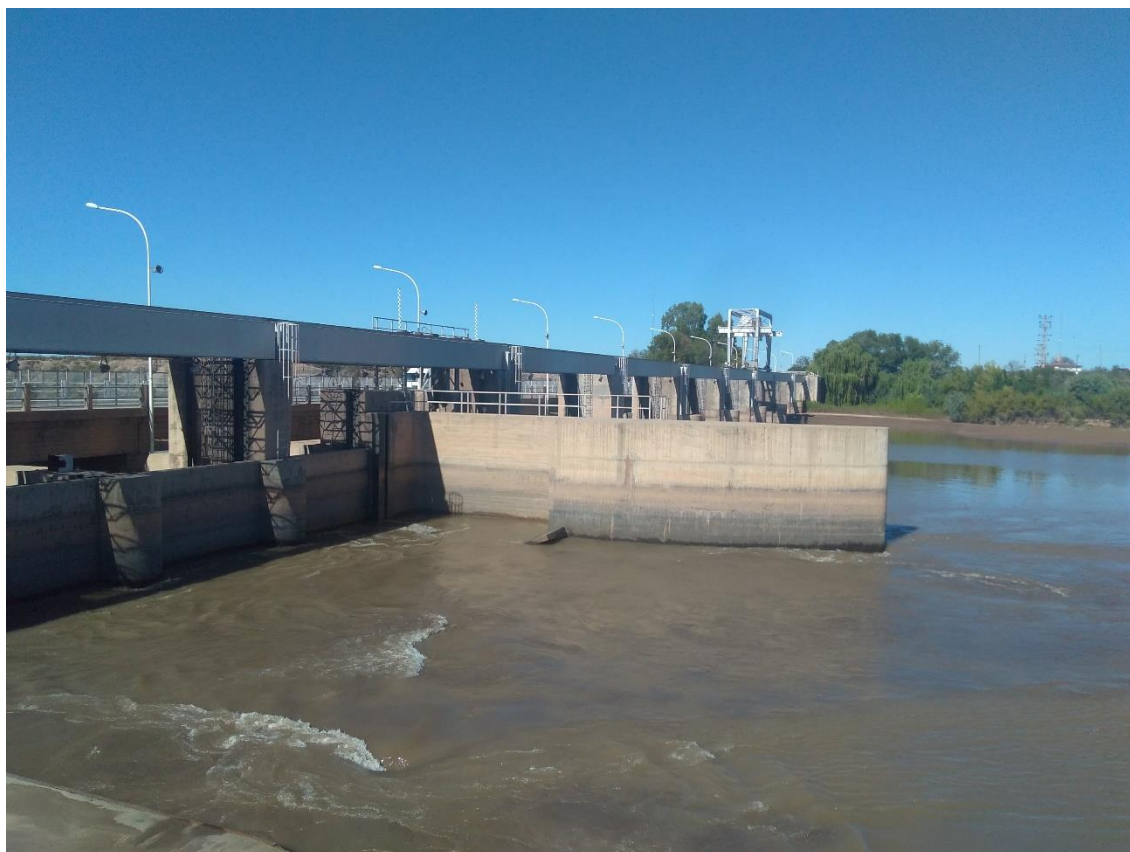
Figura 19. Toma del canal Principal del SAM en Puente-dique Punto Unido.
