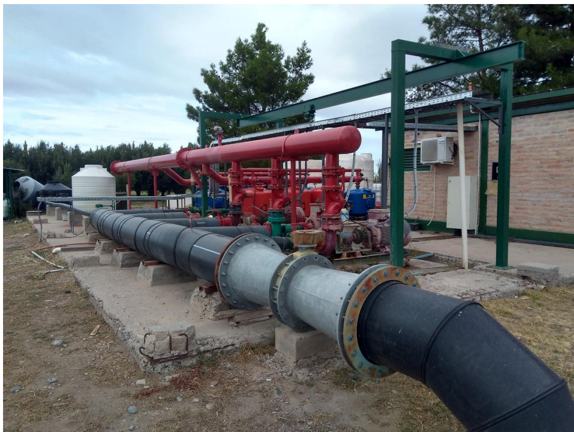
Figura 12. Cabezal de riego por goteo (Bodega del Desierto)
