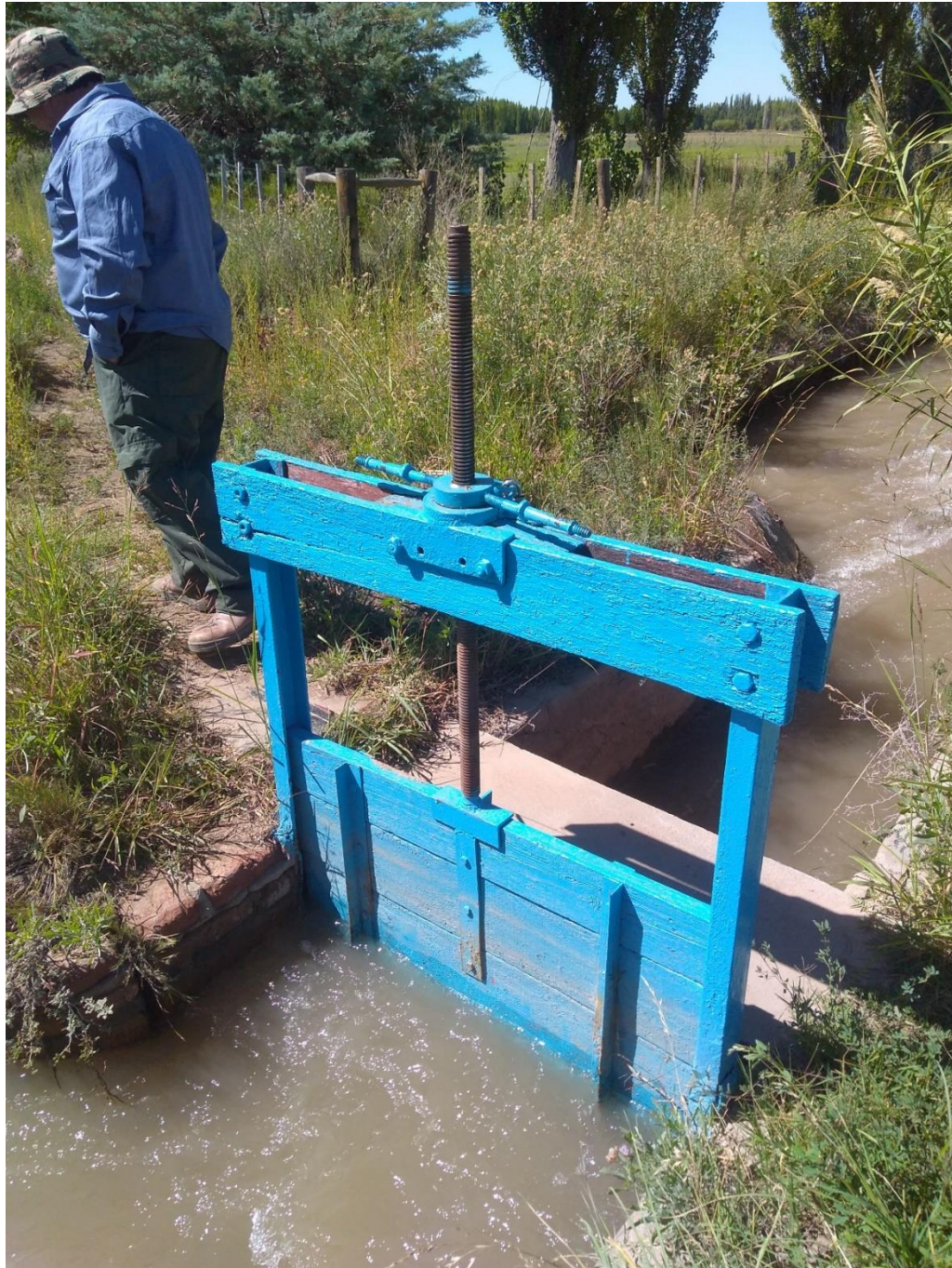
Figura 27. Compuerta de toma en El Sauzal
