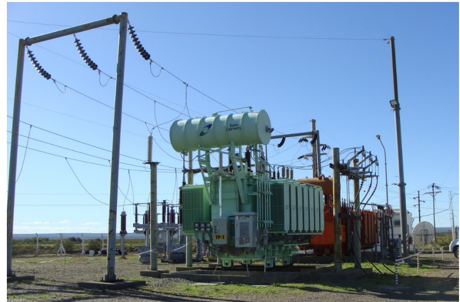
Foto 72-TP1, TP2 Vista desde lado Sur.
