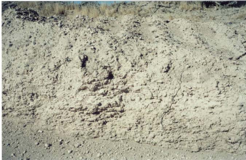
MATERIAL SUELTO QUE SUPRAYACE A LAS ARENISCAS, FOTOGRAFÍA TOMADA EN UN CORTE DE LA RUTA 23
