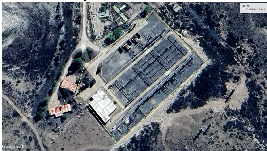
Figura 4– Estación Sierra Grande
