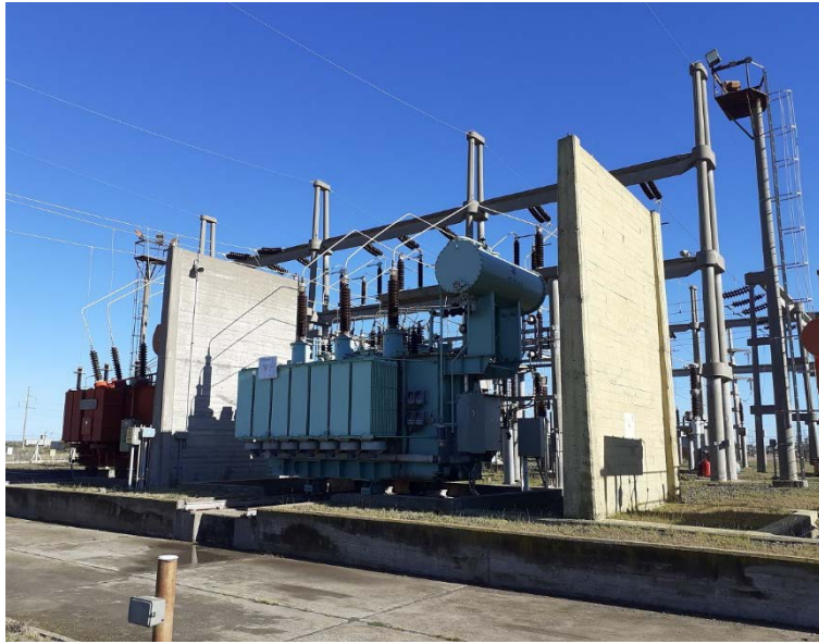
Foto 10-Vista desde el lado Este TP1 y TP2
