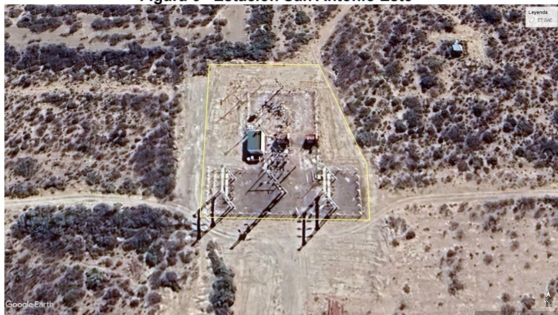
Figura 6– Estación San Antonio Este
