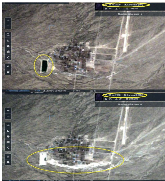
Imagen N° 35: Ex Represa de Anillaco. Rotura y desborde.
