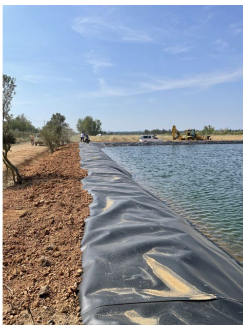
Imagen N°155 Ejemplos de Reservorios realizados con membrana geotextil
