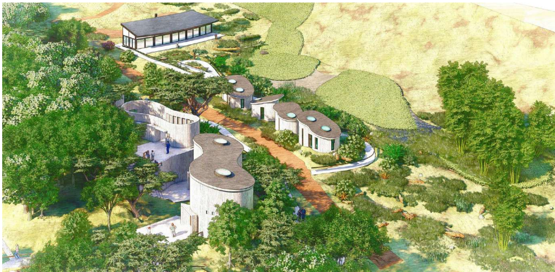
Figura 2. Vistas del conjunto más relevante de intervenciones (sanitarios, confitería y centro de interpretación).
