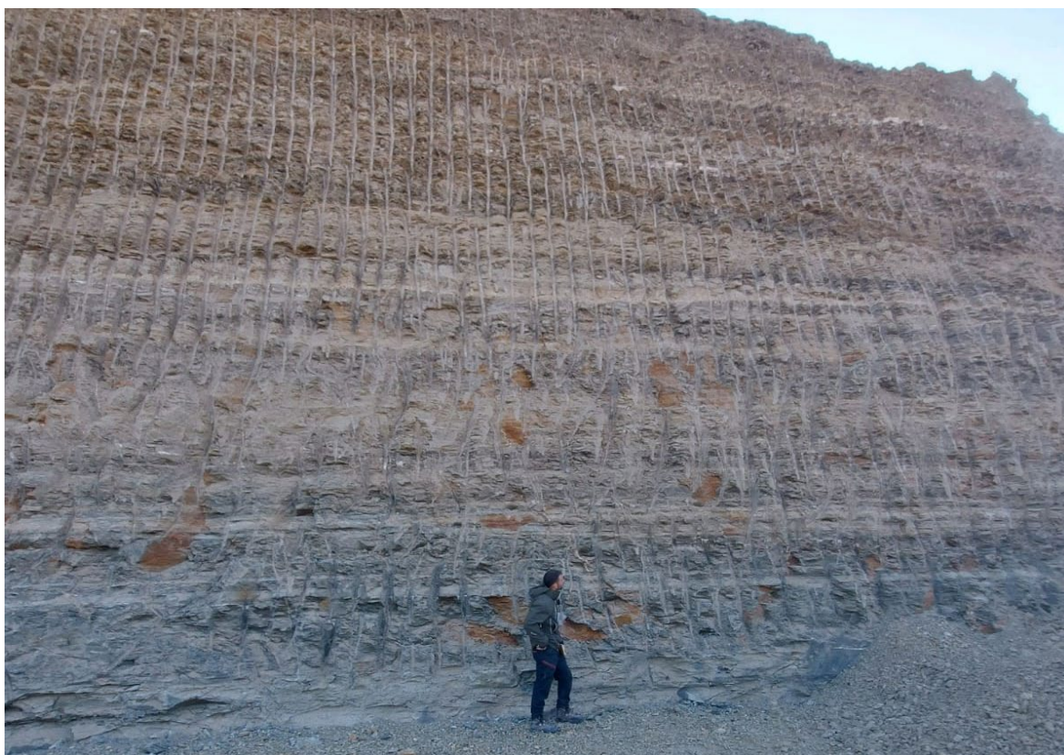
Figura 18: perfil de extracción del sector de muestra CFI-B-004. El nivel productivo se encuentra sobre nivel de piso.
