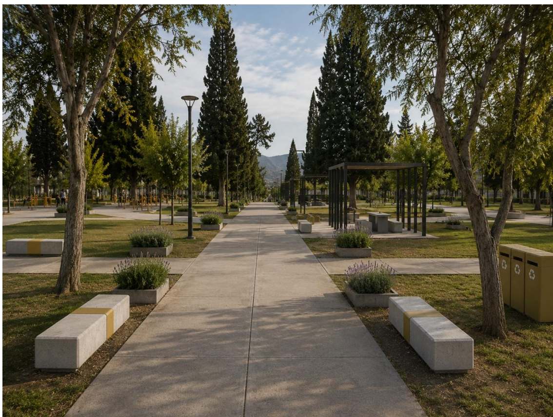
Figura 32: Incorporación de mobiliario Plaza Las Heras. Fuente: Elaboración propia
