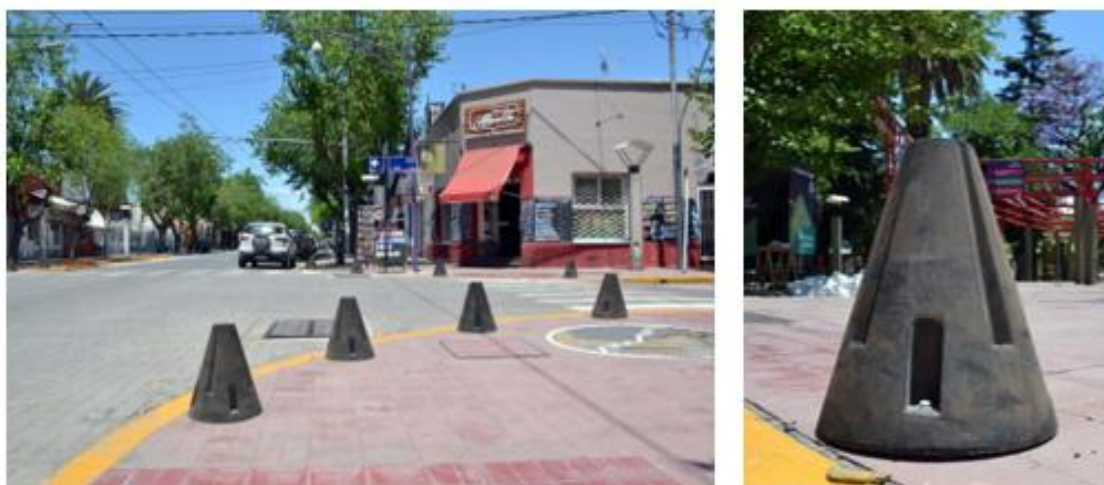
Figura 9. Bolardos de caucho reciclado utilizados para la delimitación y protección de áreas peatonales. Fuente: Elaboración propia.
