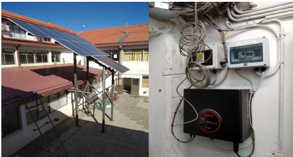
Figura 129: Instalación de paneles solares
