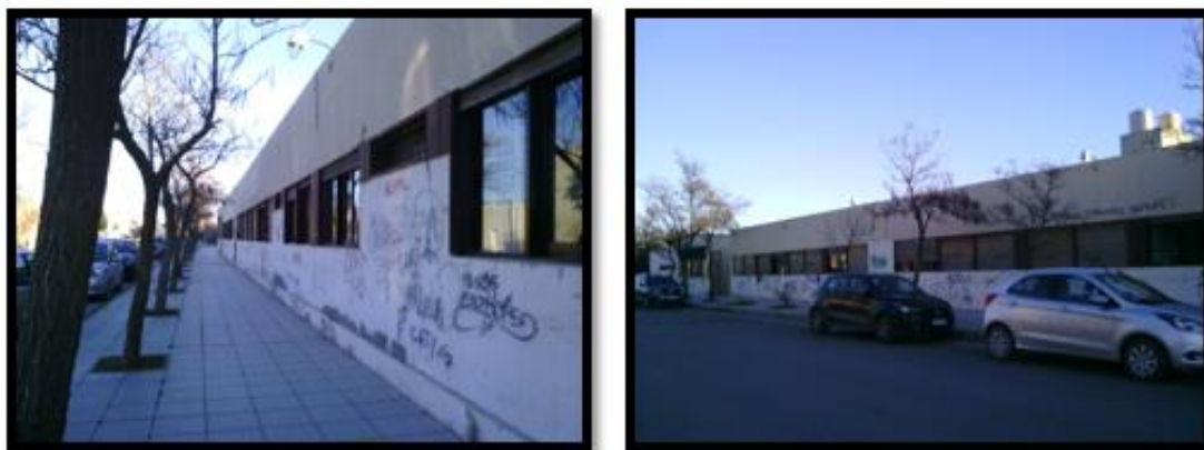
Figura 84: Vista de ventanales del sector Administración
