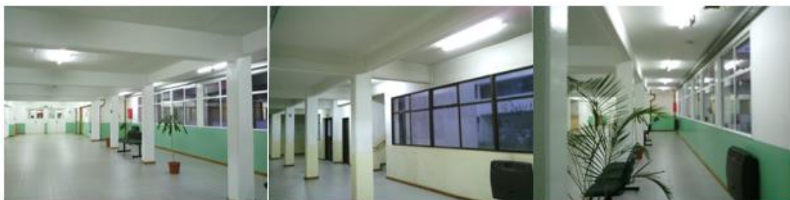
Figura 90: Áreas comunes del edificio
