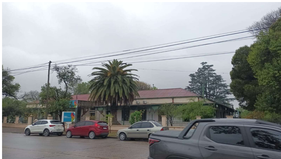
Fig. 15 – Frente del Edificio
