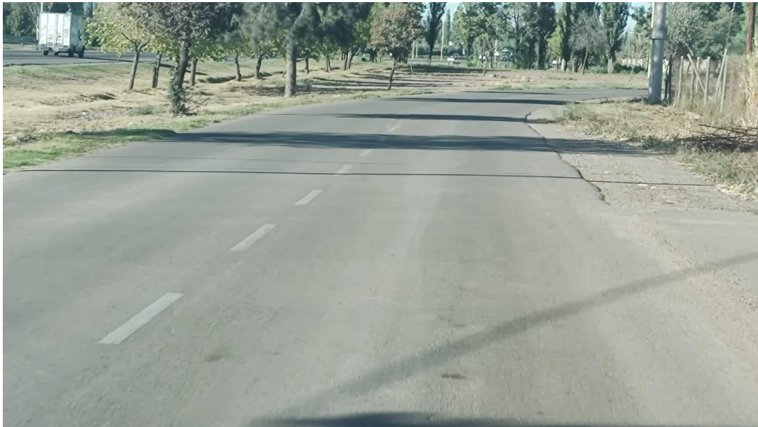
Fotografía 40. RN N 40 – J.J. Paso-Azcuénaga- Colectora Oeste (Descendente)
