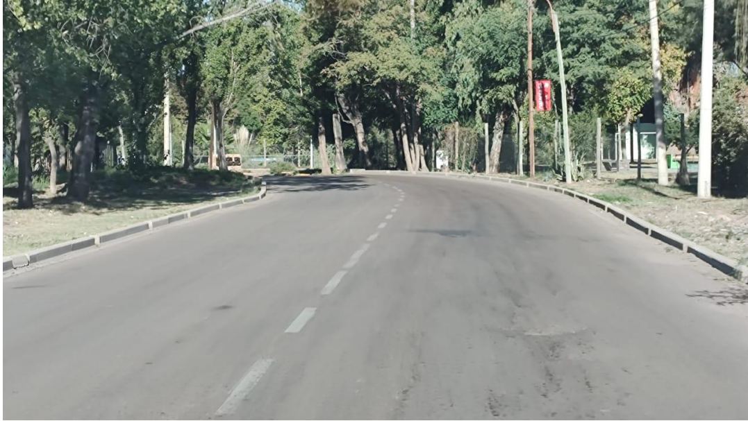
Fotografía 39. RN N 40 – J.J. Paso-Azcuénaga- Colectora Oeste (Descendente).
