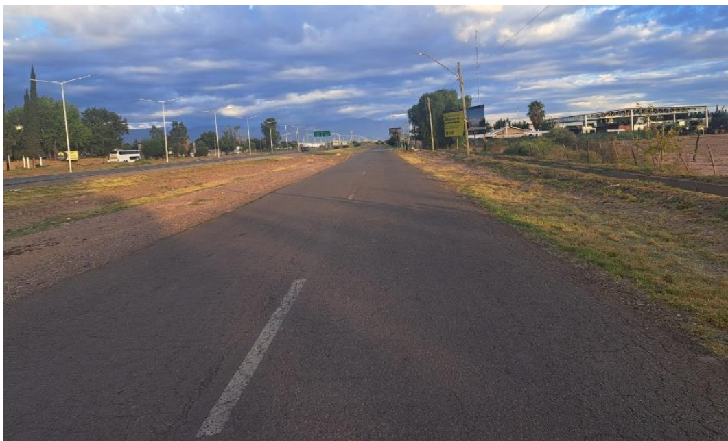
Fotografía 4. Muestra el estado de la calzada y las banquetas entre calle Tirazzo y R. P. 50
