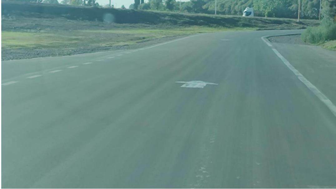
Fotografía 33. RN N 40 – J.J. Paso-Azcuénaga- Colectora Oeste (Descendente). Otra vista de la calzada y banquina después del cruce con calle Araoz.
