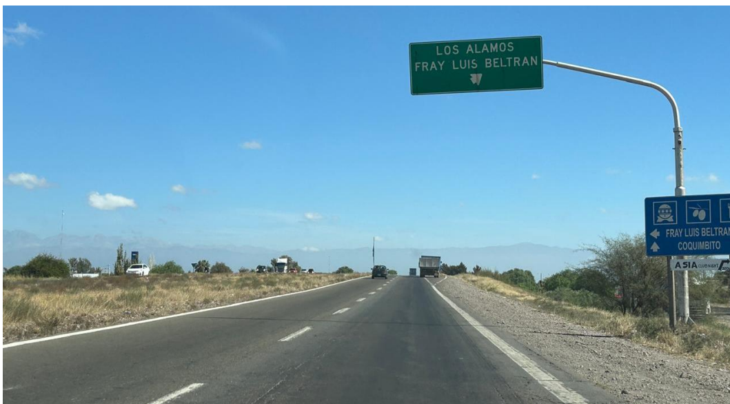
Fotografía 16. Muestra el estado de la calzada y las banquetas entre calle Medina y calle Los Álamos. – Zona de Juan L. Beltrán.
