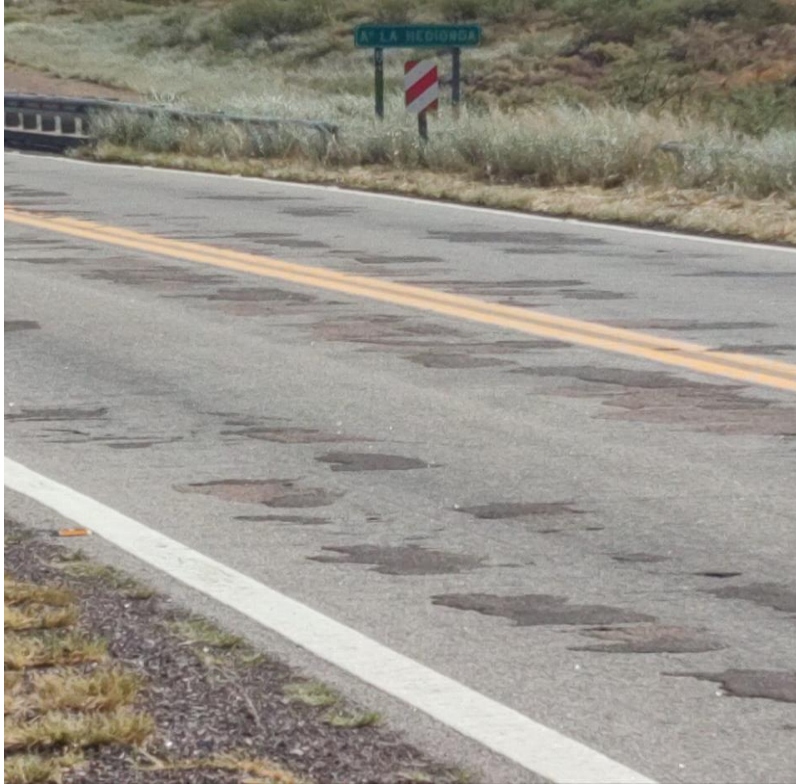
Fotografía 27. Muestra el bacheo de la Calzada en el puente del Arrollo La Hedionda
