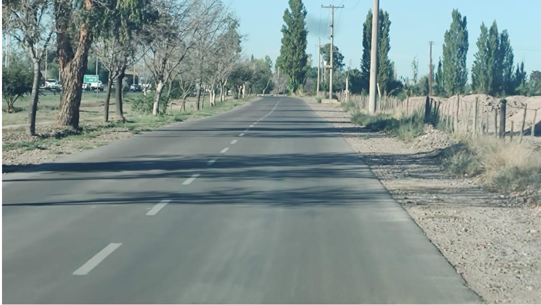
Fotografía 11. RN N 40 – J.J. Paso-Azcuénaga- Colectora Oeste (Descendente). Otra vista de la calzada y banquetas entre calle Malabia y calle Boedo.
