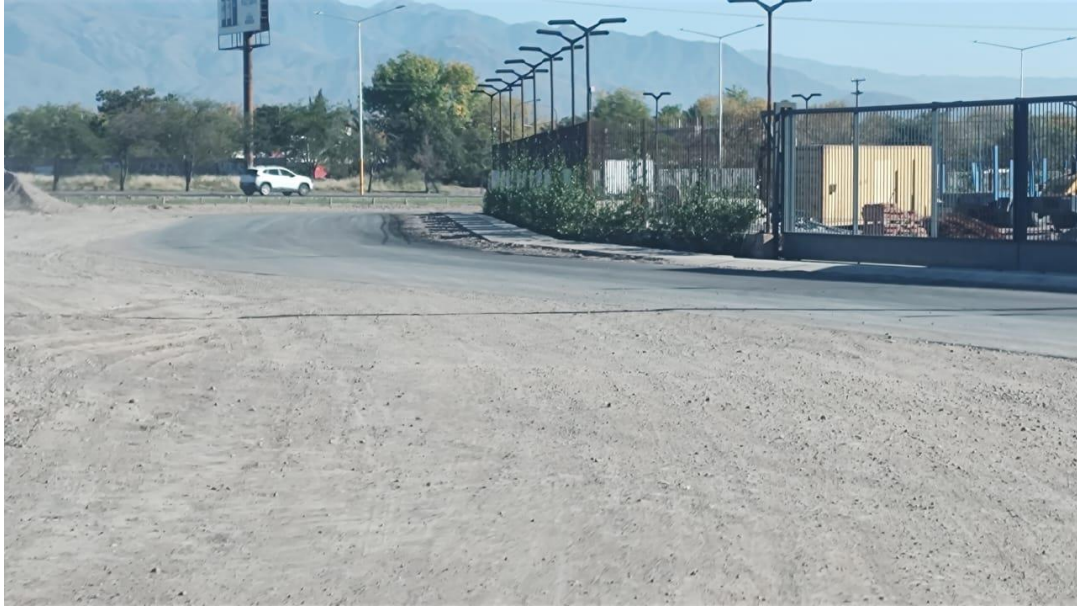
Fotografía 40. Muestra el estado de la calzada entre Calle Araoz y calle J.J. Paso.
