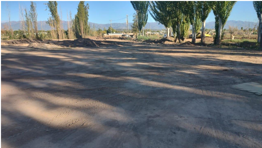
Fotografía 20. RN N 40 – J.J. Paso-Azcuénaga- Colectora Oeste (Descendente). Vista de la calzada de ripio y banquina antes del cruce con calle Castro Barros.
