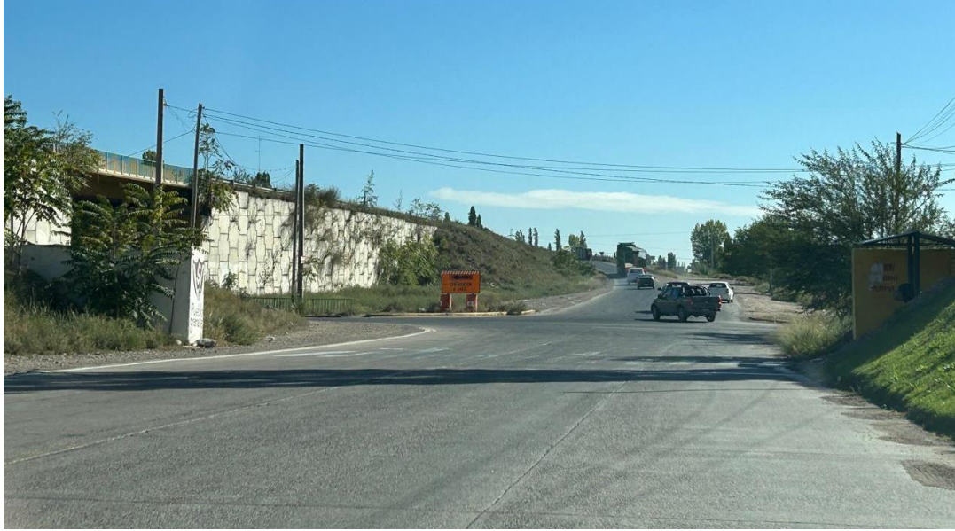
Fotografía 13: Muestra el estado de la calzada intersección Olavarría. Tramo Intersección Azcuénaga, Ruta 7, colectora Este.
