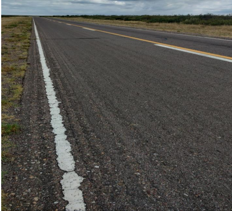
Fotografía 17. Muestra el slurry sobre la calzada antes del Arrollo Silva
