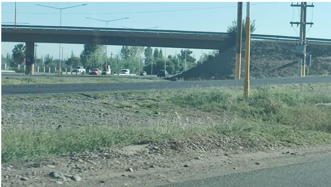
Fotografía 21. Muestra el puente sobre calle Araoz.
