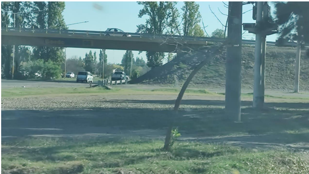
Fotografía 35. Cruce con calle Boedo.
