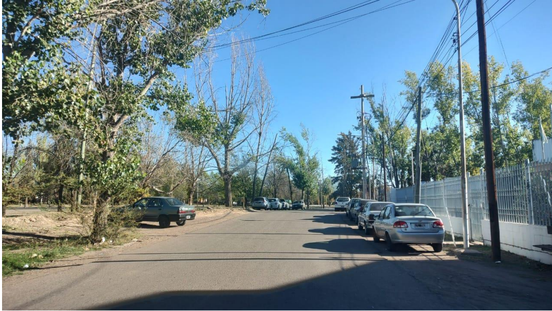
Fotografía 3. Muestra el estado de la calzada entre Calle Azcuénaga y Calle Araoz.
