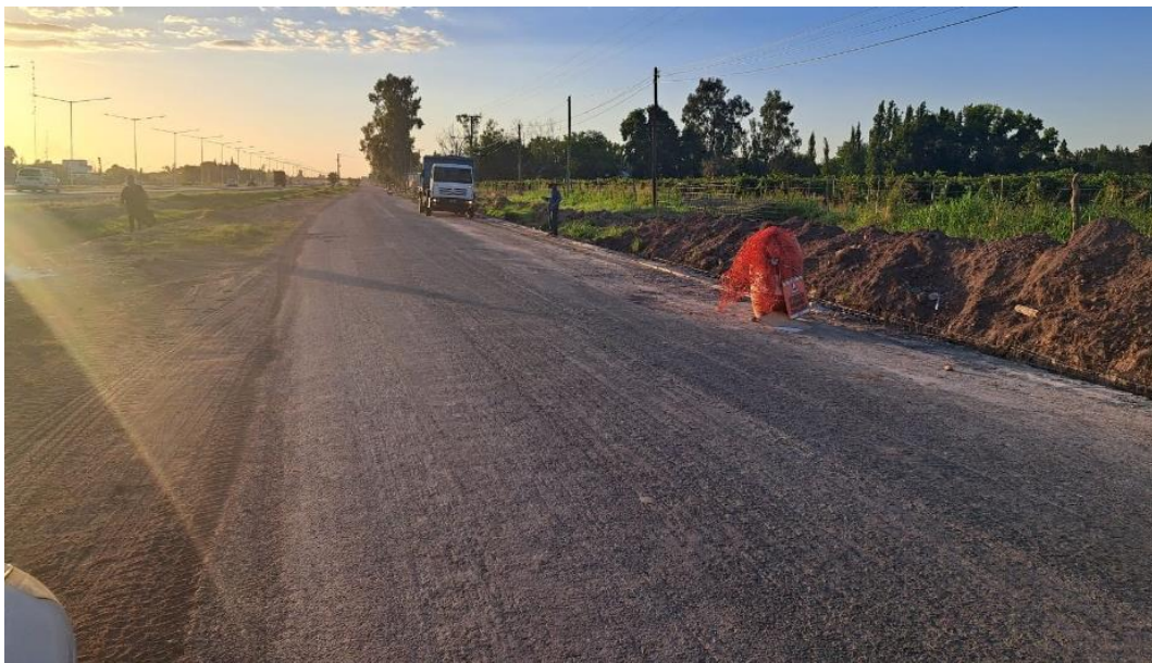
Fotografía 8. Muestra el estado de la calzada y las banquetas entre calle Tirasso y calle Nicola Serpa.
