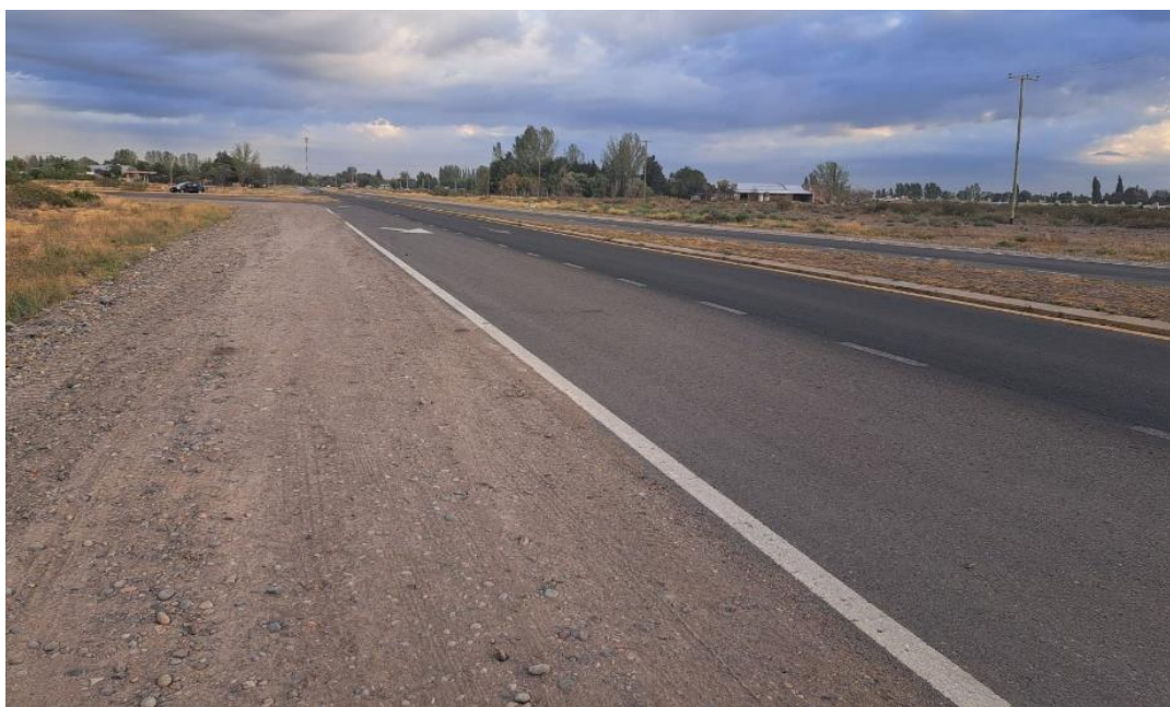
Fotografía 2. Otra vista del estado de la calzada y la banquina al inicio del tramo.
