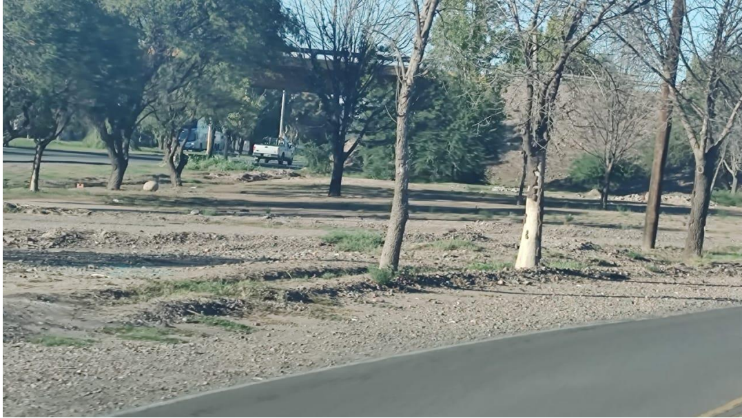
Fotografía 13. RN N 40 – J.J. Paso-Azcuénaga- Colectora Oeste (Descendente). Otra vista de la calzada y banquina antes del cruce con calle Boedo.
