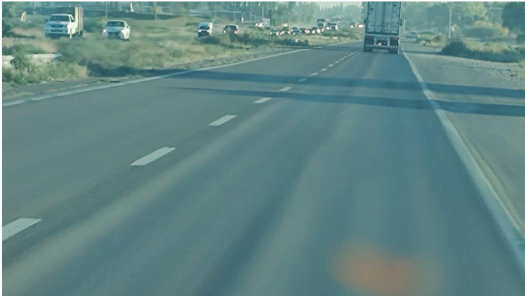
Fotografía 8: Muestra el estado de la calzada y banquetas. Tramo Intersección Ruta 7 y Azcuénaga.
