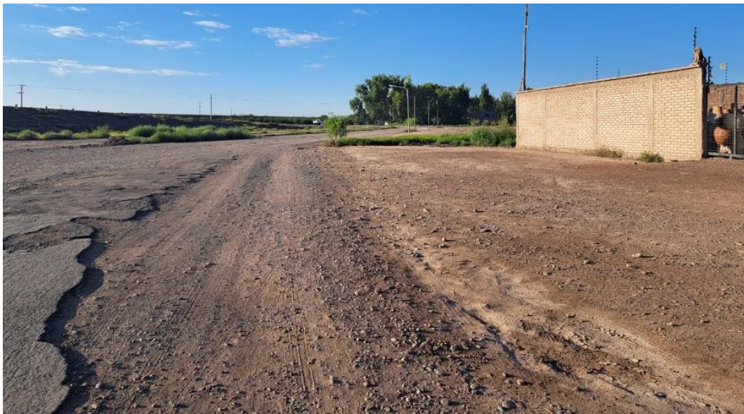
Fotografía 18. Muestra el estado de la calzada y las banquetas entre calle Tirasso y calle Nicola Serpa.
