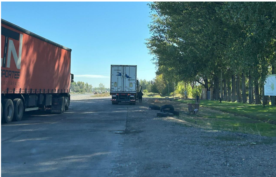
Fotografía 6: Muestra el estado de la calzada, rama de entrada Estacio de Servicio. Tramo Intersección Azcuénaga, Ruta 7, colectora Este.
