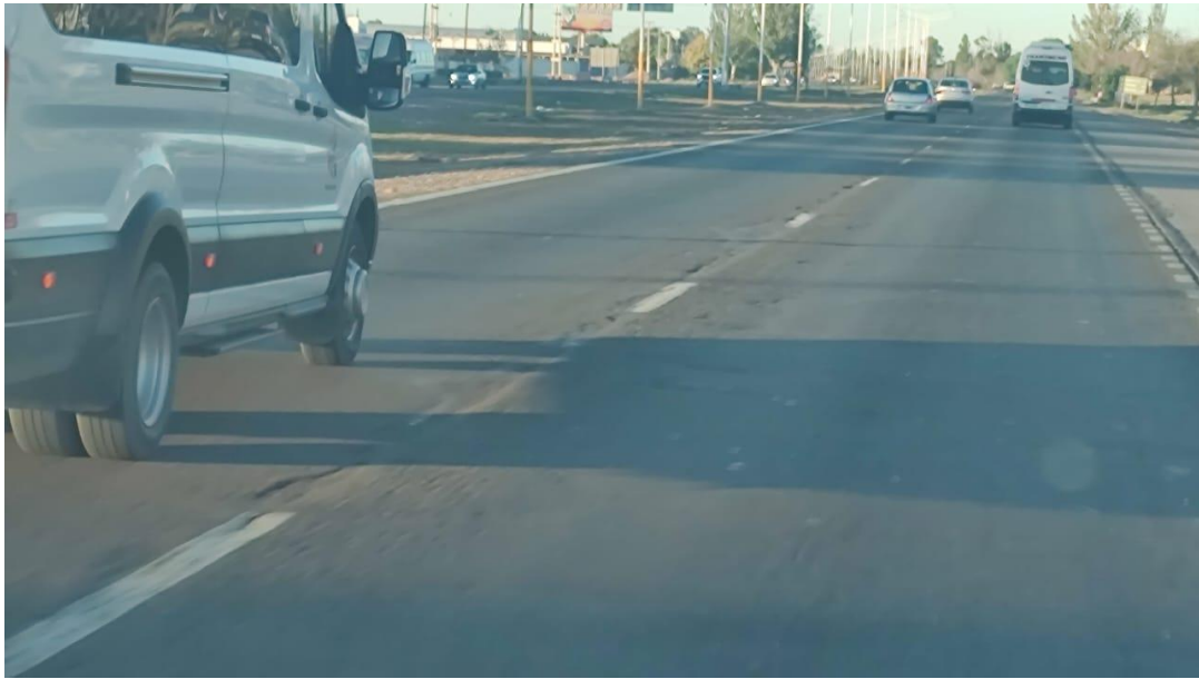
Fotografía 3. Muestra el estado de la calzada entre J.J. Paso y calle Araoz.
