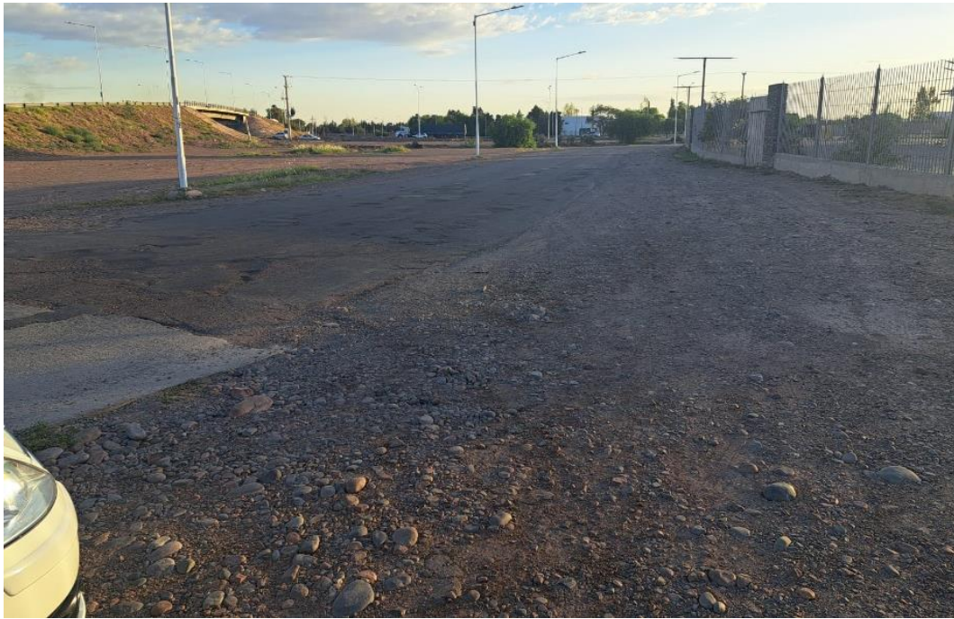
Fotografía 7. Muestra el estado de la calzada y las banquetas entre calle Tirasso y calle Nicola Serpa.
