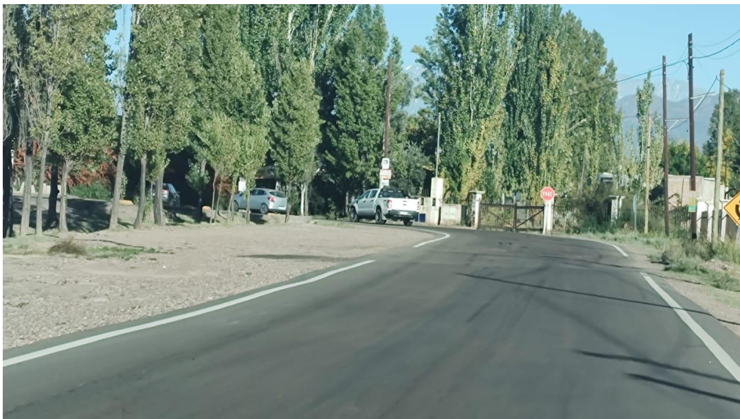
Fotografía 32. RN N 40 – J.J. Paso-Azcuénaga- Colectora Oeste (Descendente). Muestra la calzada y banquina después del cruce con calle Araoz.
