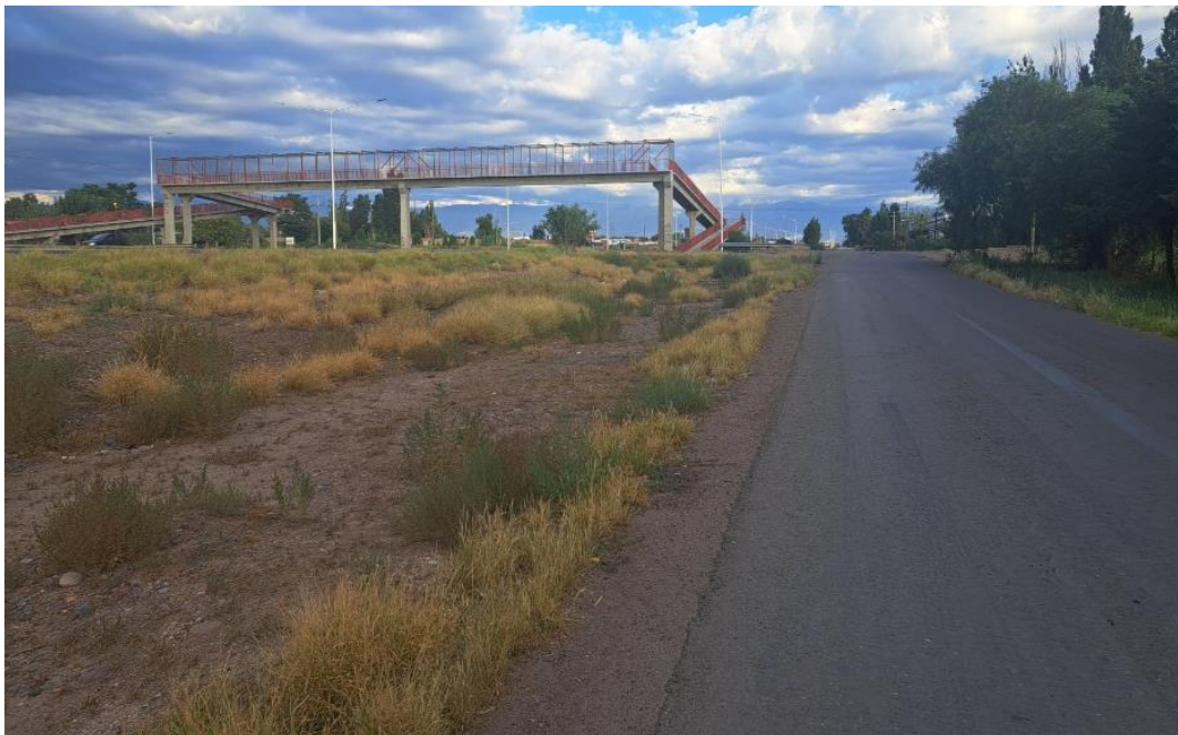
Fotografía 6. Muestra el estado de la calzada y las banquetas entre calle Tirazzo y R. P. 50.
