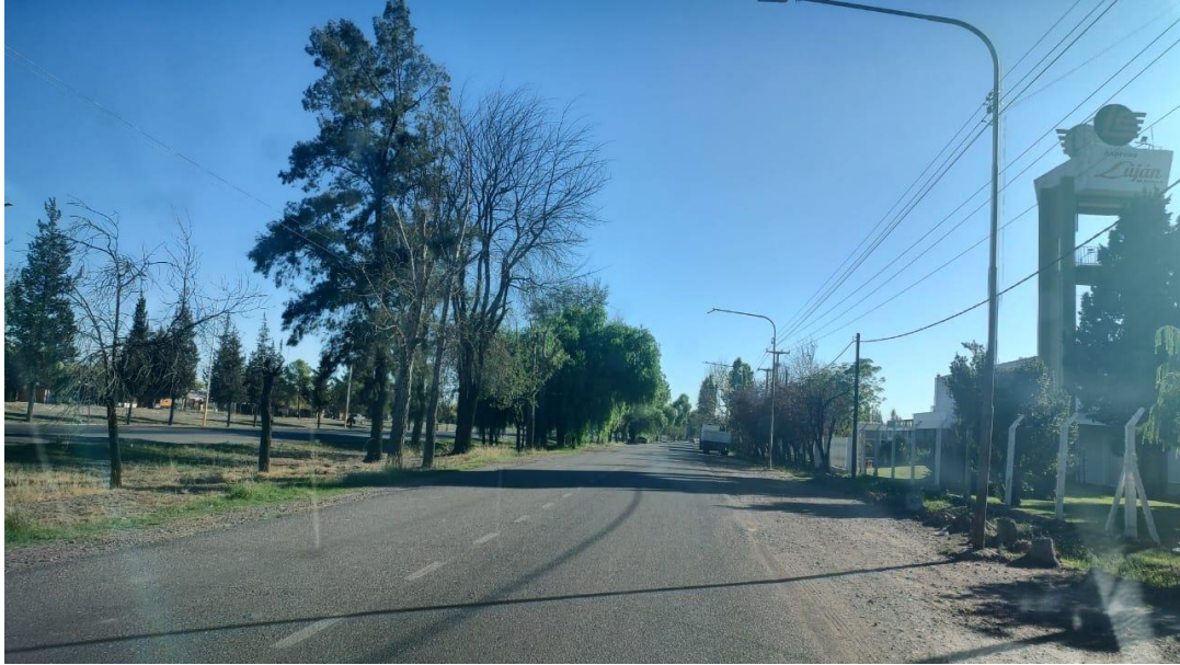
Fotografía 5. Muestra el estado de la calzada entre Calle Azcuénaga y Calle Araoz.
