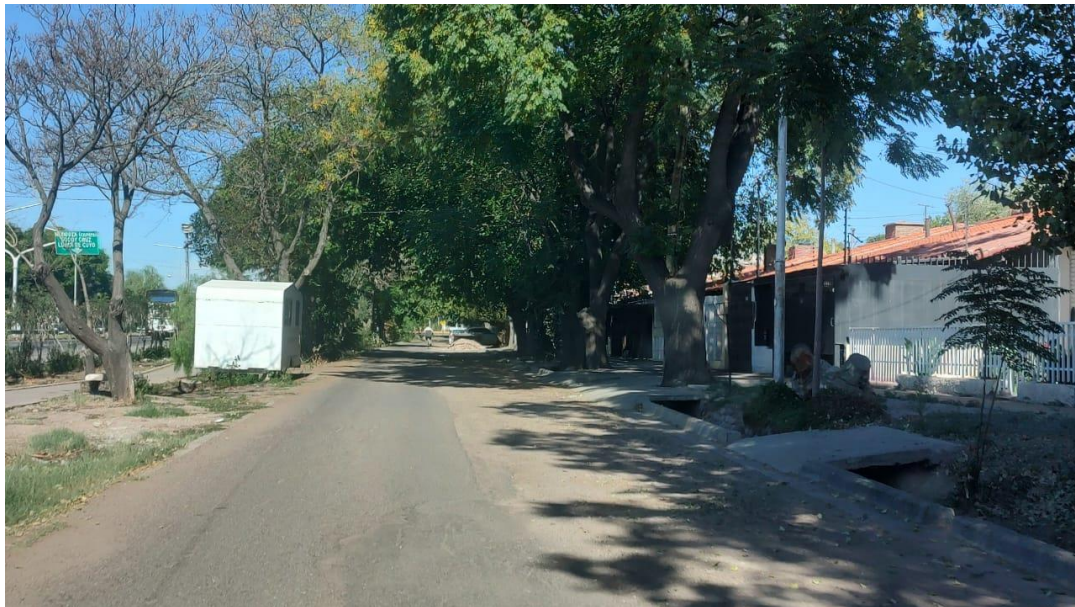
Figura 2. Vista del tipo y estado de la calzada entre Rotonda del Avión y calle Los Pescadores.
