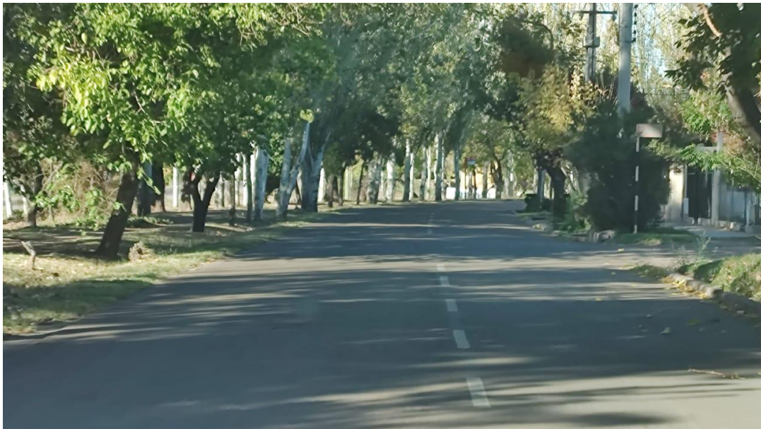
Fotografía 48. RN N 40 – J.J. Paso-Azcuénaga- Colectora Oeste (Descendente)
