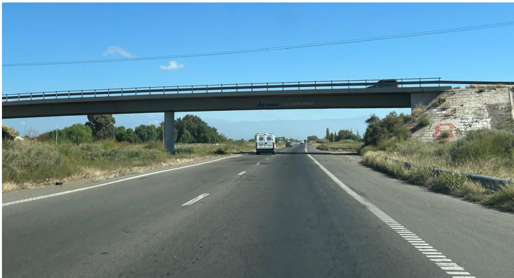
Fotografía 6. Muestra el estado de la calzada y las banquetas entre calle San Pedro y calle Medina. Cruce calle Las Margaritas – RP N° 33.
