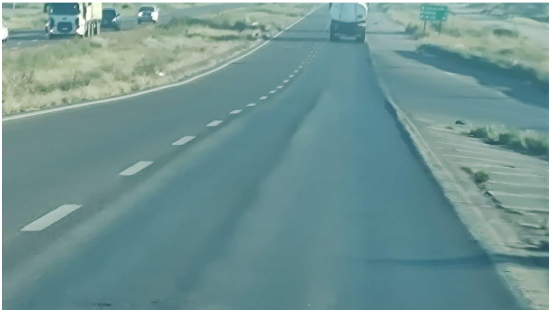
Fotografía 18: Muestra el estado de la calzada y banquetas. Tramo Intersección Ruta 7 y Azcuénaga.
