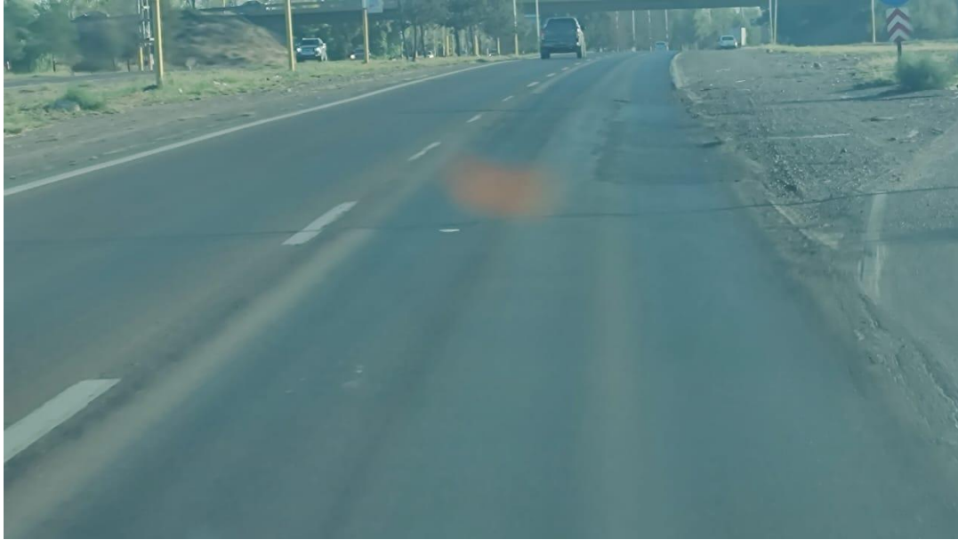
Fotografía 27: Muestra el estado de la calzada y banquetas. Tramo Intersección Ruta 7 y Azcuénaga. FIN DEL TRAMO.
