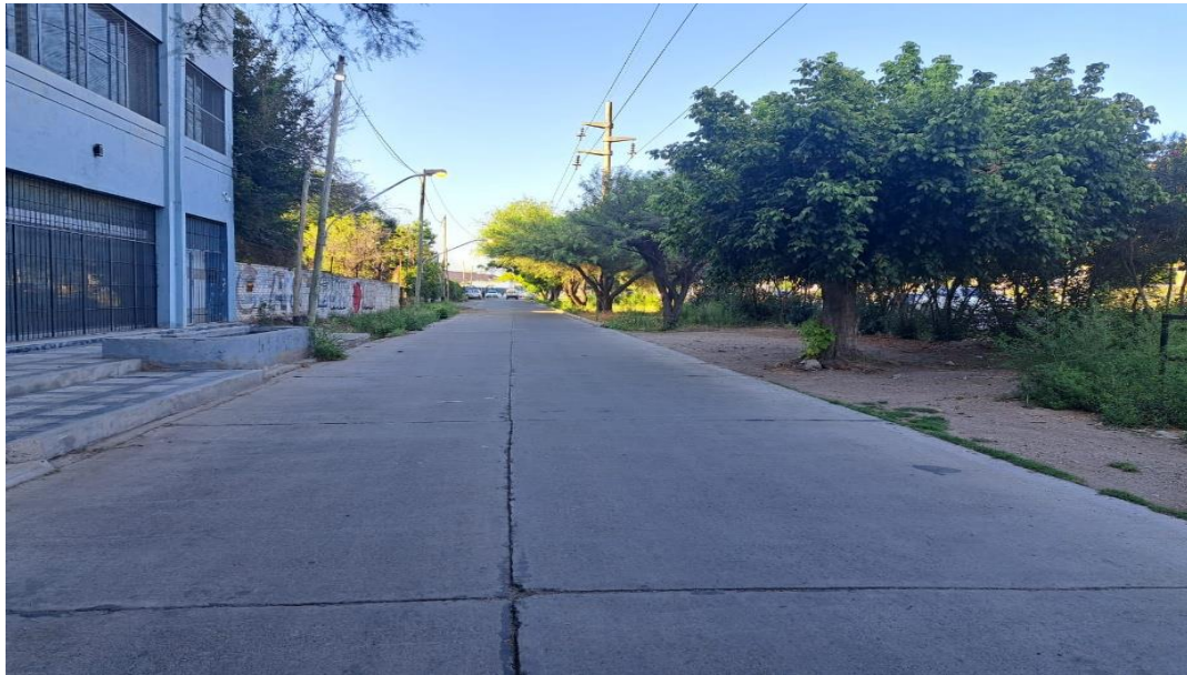
Fotografía 3. Vista del tipo y estado de la calzada entre la rotonda del Avión y calle Los Pescadores
