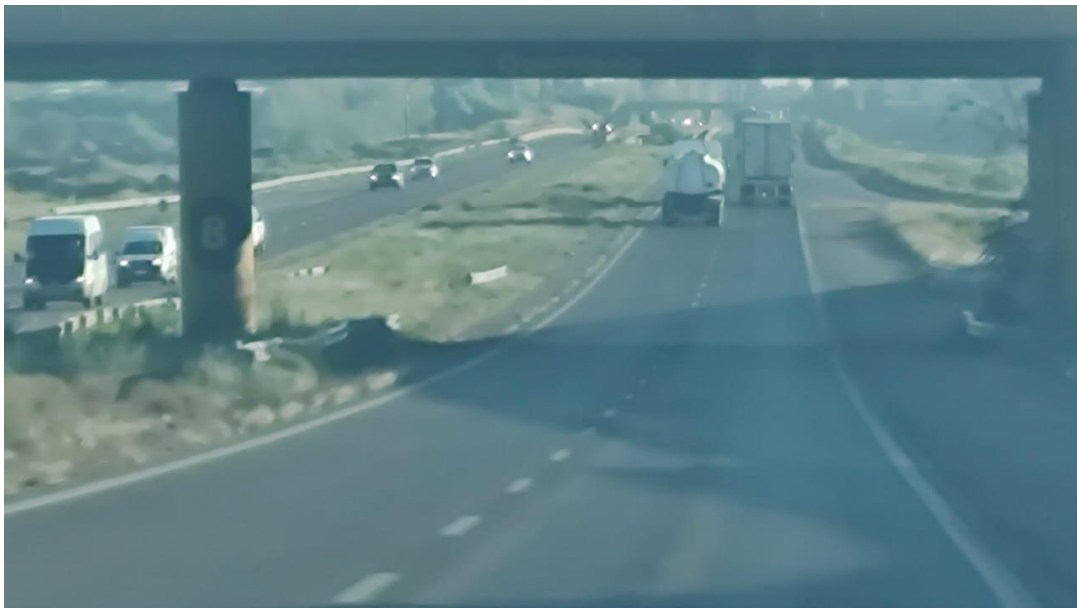
Fotografía 20: Muestra el estado de la calzada y banquetas. Tramo Intersección Ruta 7 y Azcuénaga.
