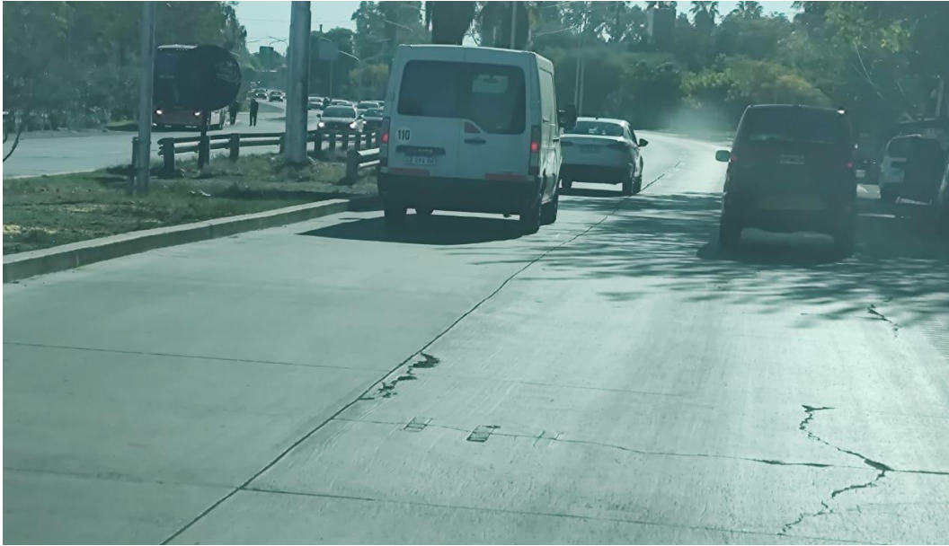
Fotografía 1. Inicio Calzada Principal – Ascendente – Rotonda del Avión
