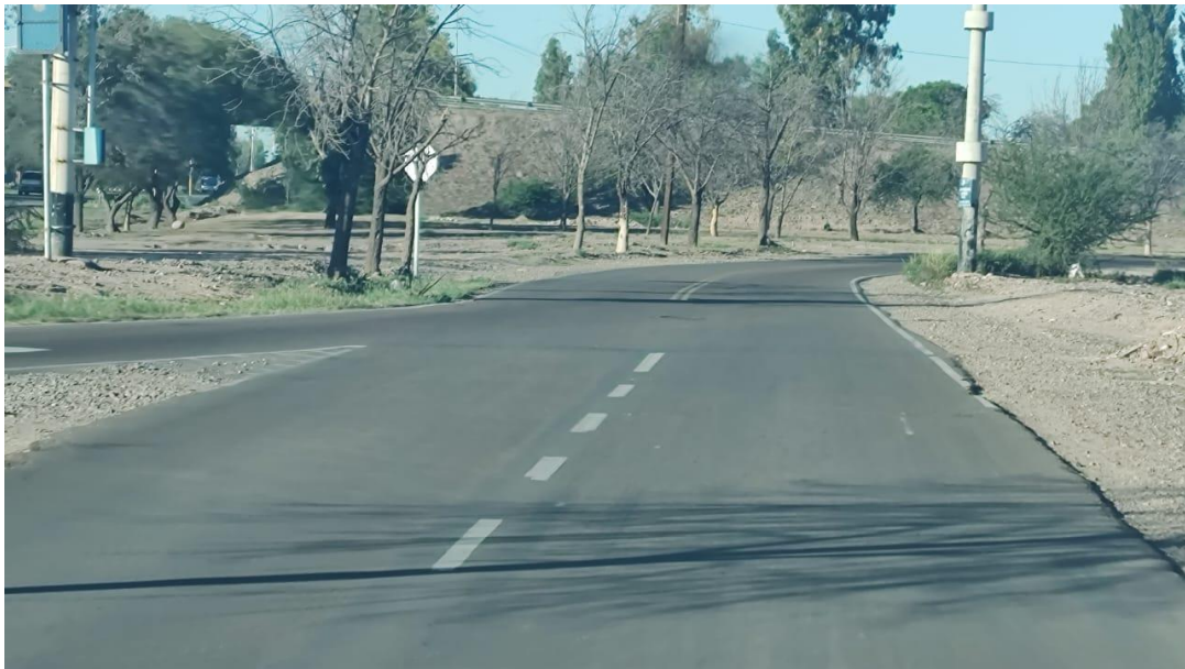
Fotografía 12. RN N 40 – J.J. Paso-Azcuénaga- Colectora Oeste (Descendente). Vista de la calzada y banquina antes del cruce con calle Boedo
