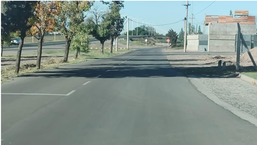
Fotografía 44. RN N 40 – J.J. Paso-Azcuénaga- Colectora Oeste (Descendente)
