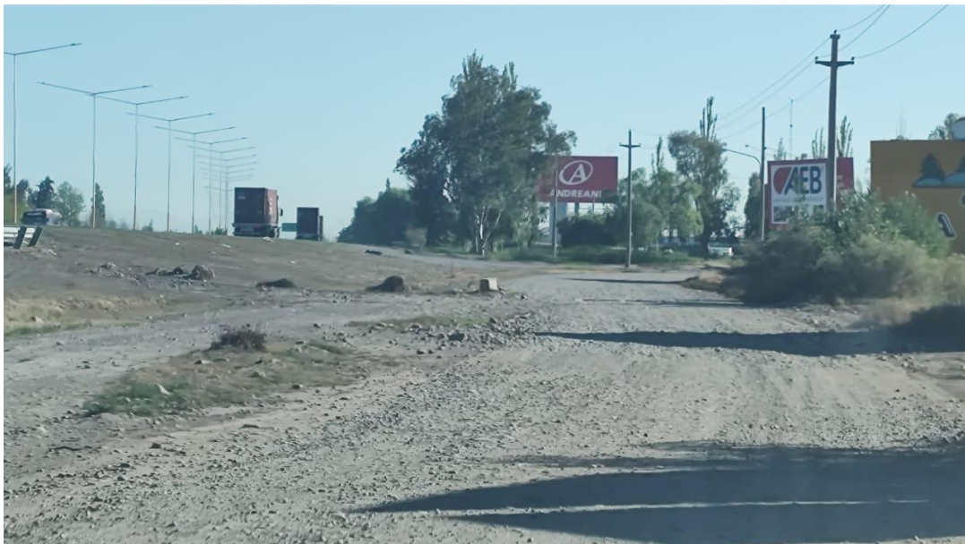
Fotografía 18. Muestra el estado de la calzada entre Calle Azcuénaga y Calle Araoz.
