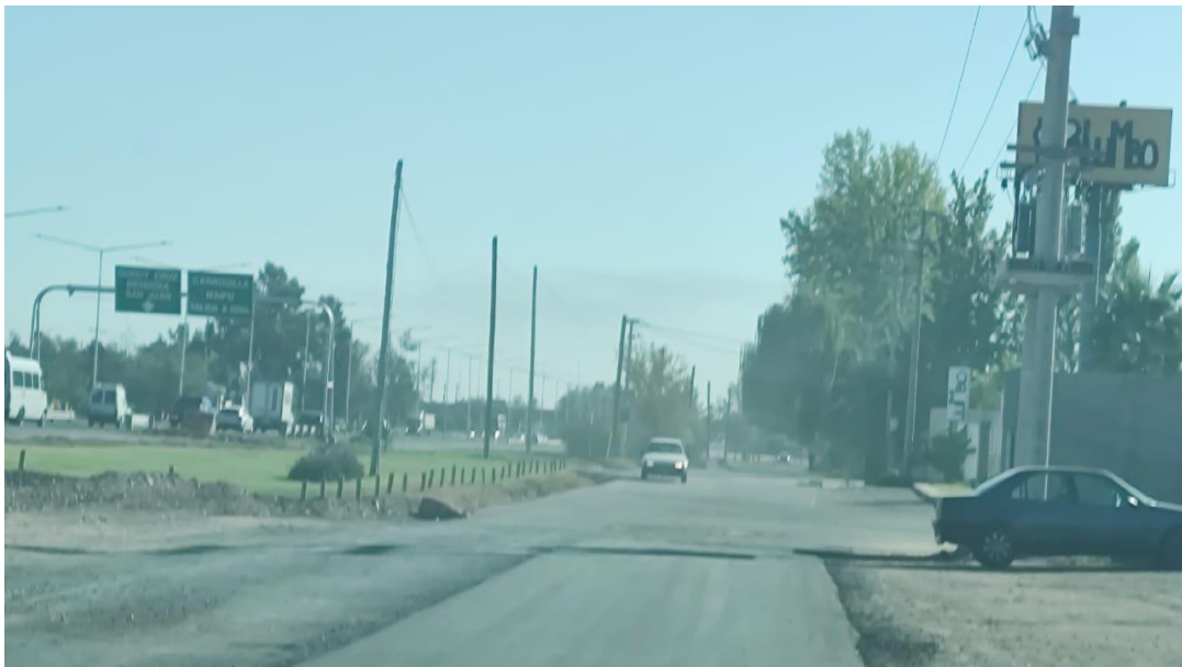
Fotografía 41. Muestra el estado de la calzada entre Calle Araoz y calle J.J. Paso.
