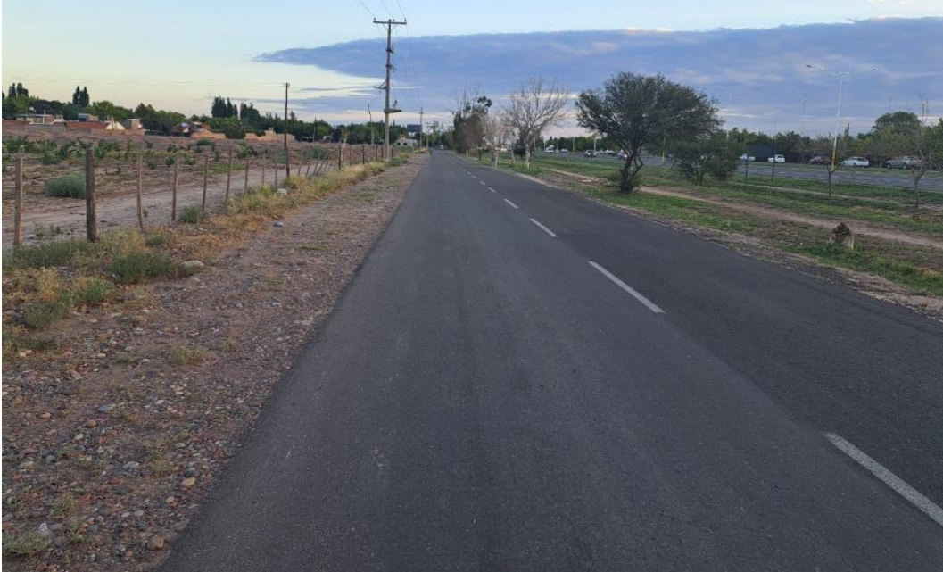
Fotografía 3. Muestra el estado de la calzada y las banquetas entre calle Tirasso y calle Nicola Serpa.
