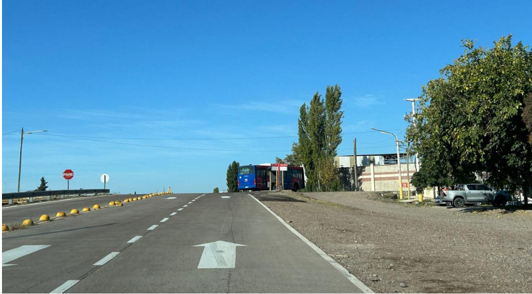
Fotografía 7: Muestra el estado de la calzada. Rama acceso intersección Calle Quintana Tramo Intersección Azcuénaga, Ruta 7, colectora Oeste.
