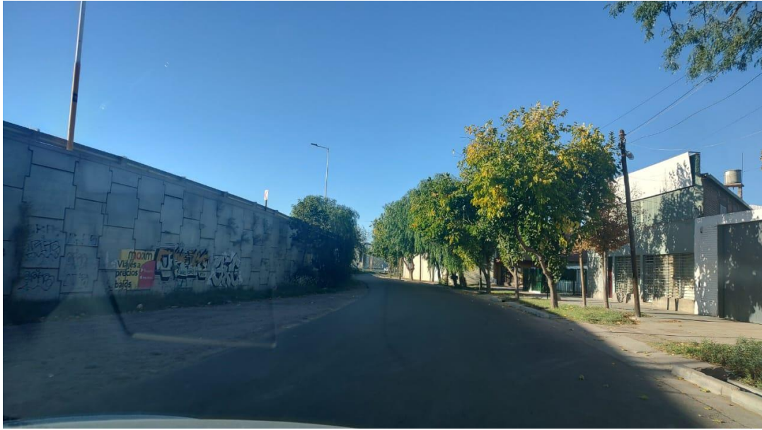
Fotografía 1. RN N 40 – J.J. paso-Azcuénaga- Colectora Oeste (Descendente). Inicio del tramo en J.J. Paso.
