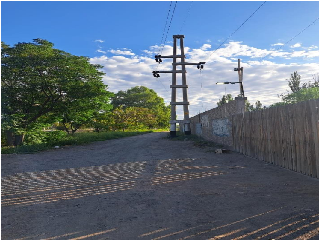
Fotografía 11. Vista del tipo y estado de la calzada entre Libertad y Constitución.
