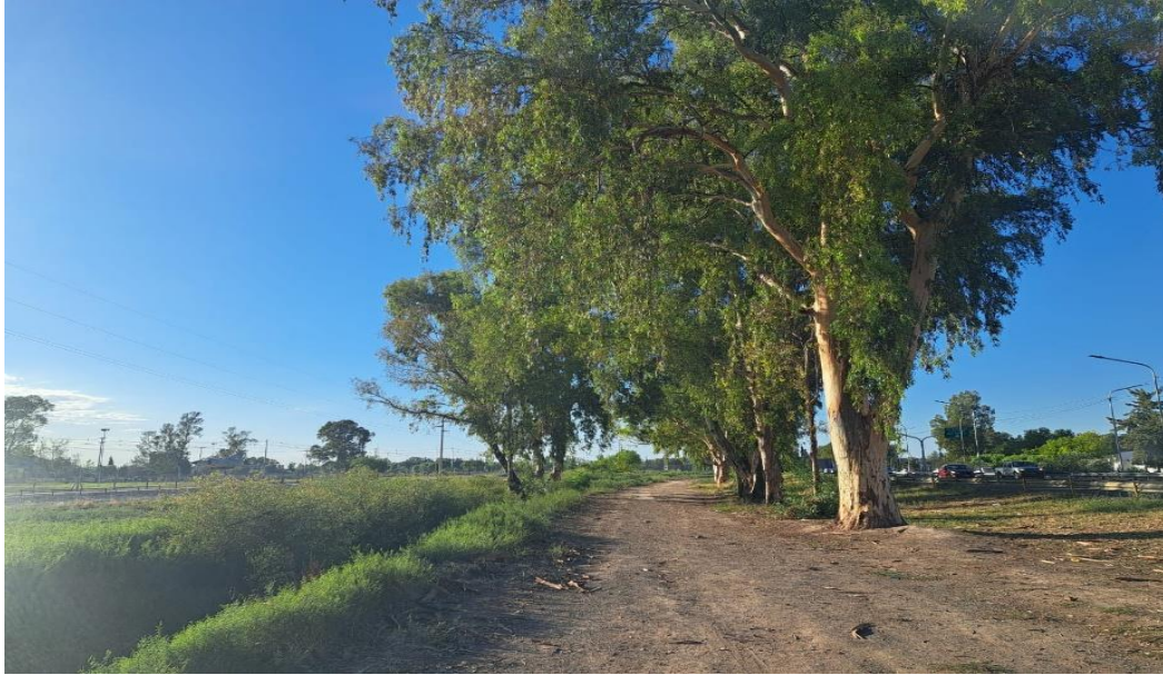
Fotografía 9. Vista del tipo y estado de la calzada entre Rotonda Gral. Paz e Independencia – Sin definir la colectora.
