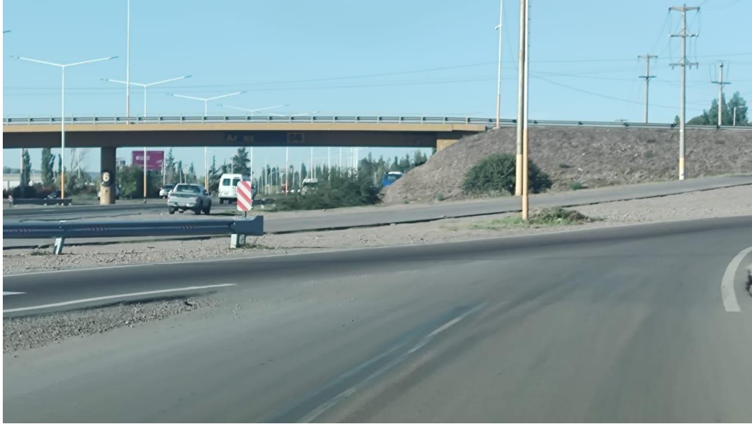
Fotografía 31. RN N 40 – J.J. Paso-Azcuénaga- Colectora Oeste (Descendente). Muestra el cruce con calle Araoz.
