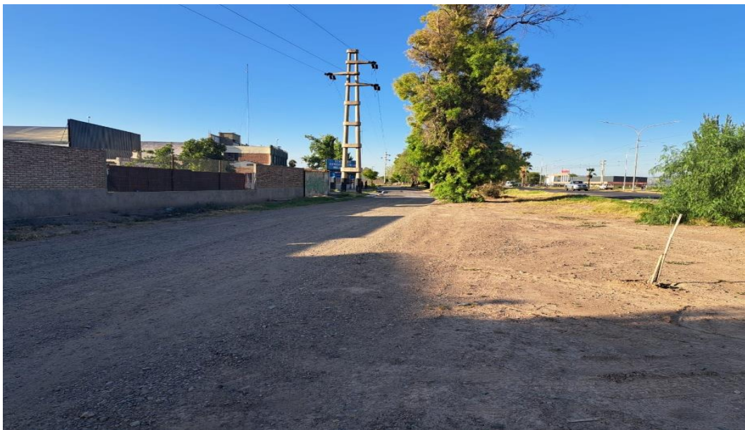
Fotografía 12 Vista del tipo y estado de la calzada entre Libertad y Constitución.
