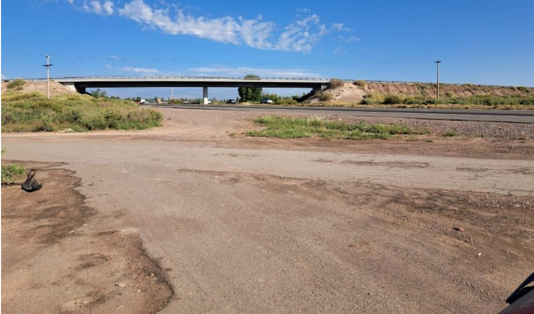
Fotografía 33. Muestra el estado de la calzada y las banquetas entre calle Nicola Serpa y calle Laprida. Cruce calle Las Margaritas.
