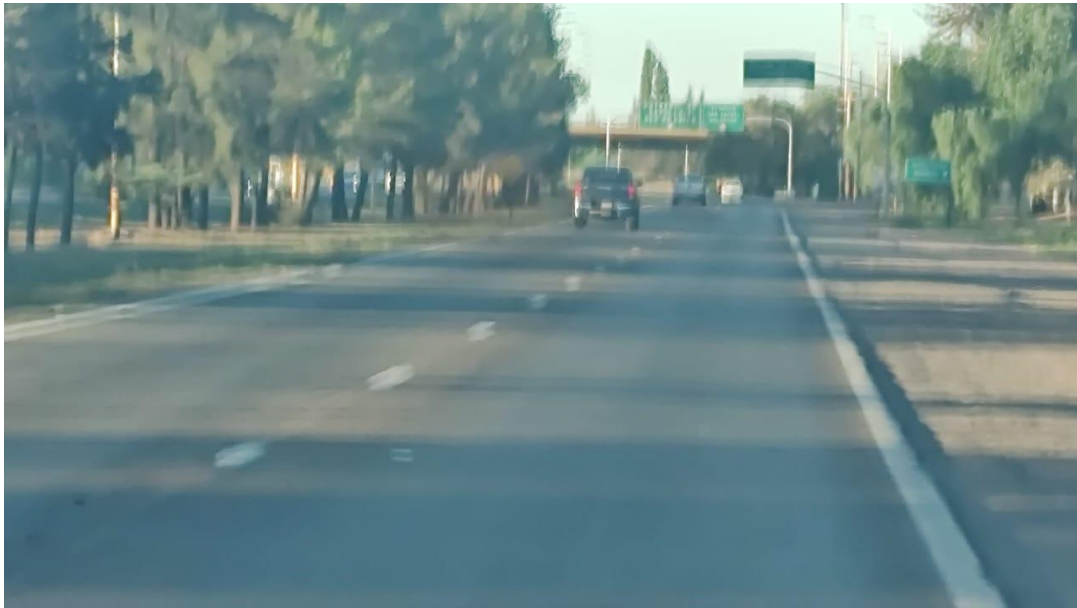
Fotografía 23. Muestra el estado de la calzada y la banquina externa entre calle Araoz y calle Azcuénaga.
