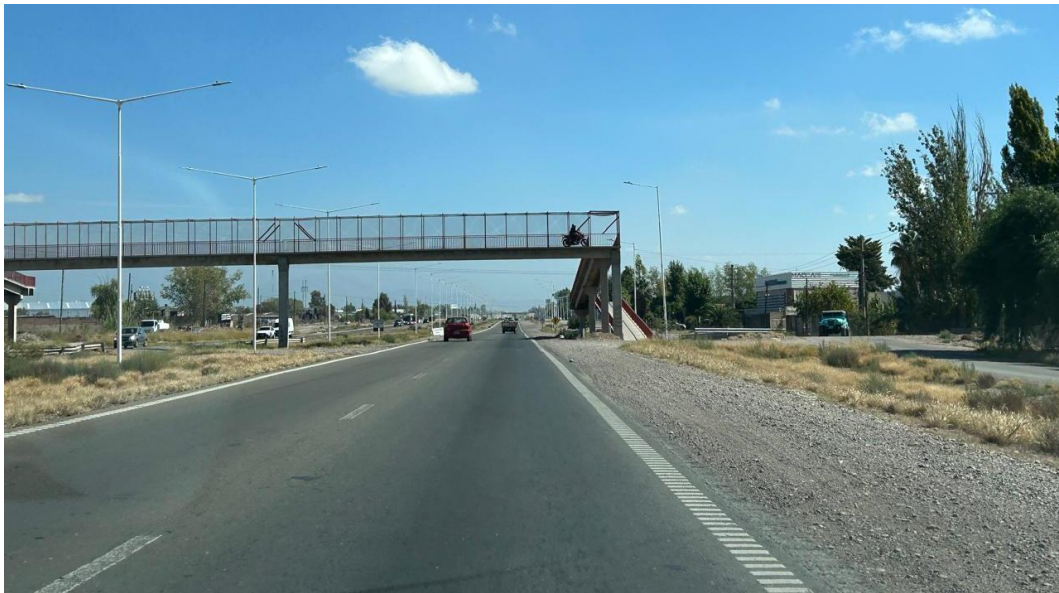
Fotografía 20. Muestra el estado de la calzada y las banquetas entre calle Los Álamos y Calle Tirasso.
