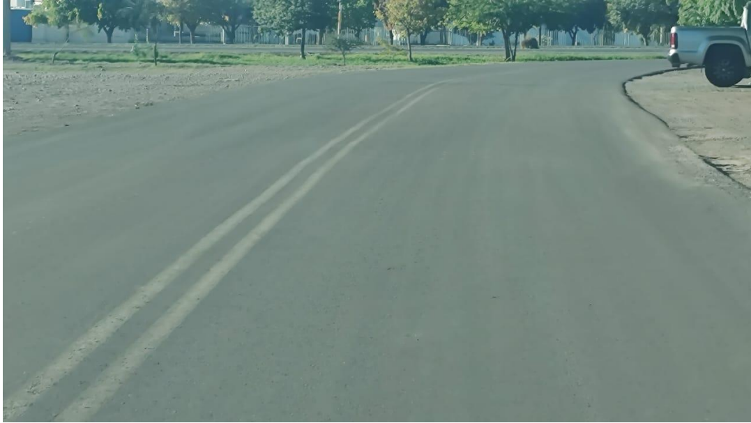
Fotografía 9. RN N 40 – J.J. Paso-Azcuénaga- Colectora Oeste (Descendente). Otra vista de la calzada y banquetas después del cruce con calle Malabia
