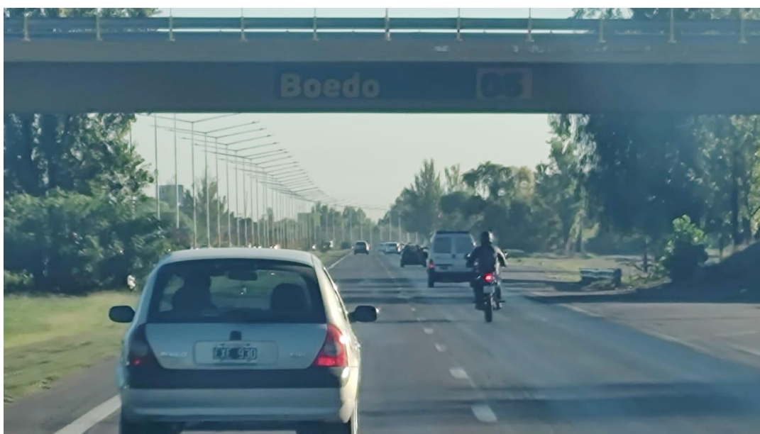
Fotografía 22. Muestra el estado de la calzada y las banquetas entre calle Araoz y J.J. Paso
