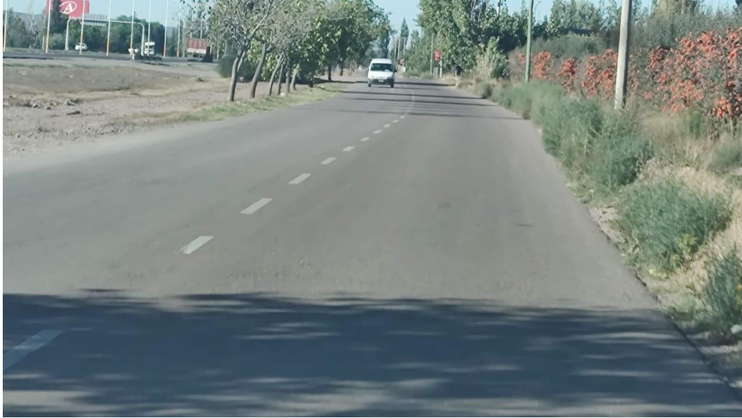
Fotografía 37. RN N 40 – J.J. Paso-Azcuénaga- Colectora Oeste (Descendente). Otra vista de la calzada y banquina después del cruce con calle Araoz.
