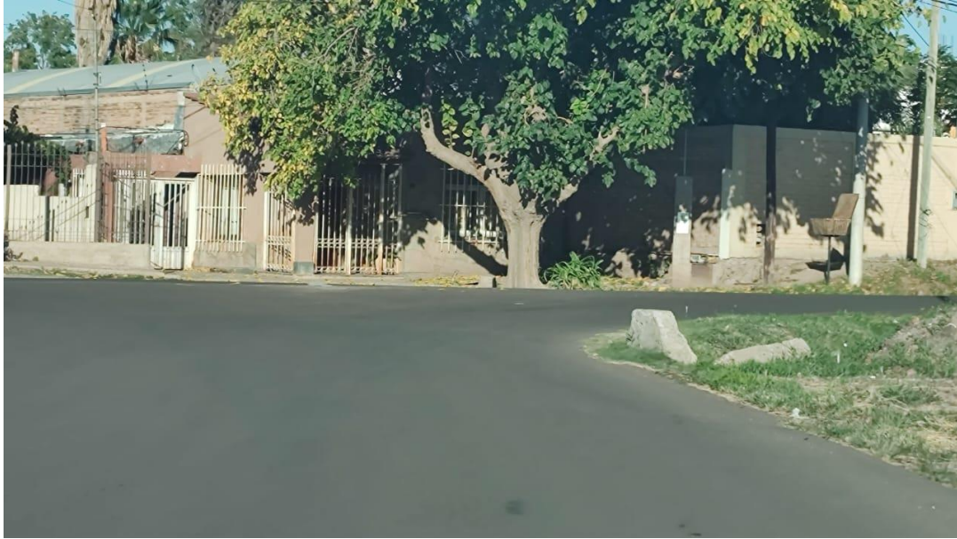
Fotografía 7. RN N 40 – J.J. Paso-Azcuénaga- Colectora Oeste (Descendente). Vista de la calzada y banquetas en cruce con calle Malabia.
