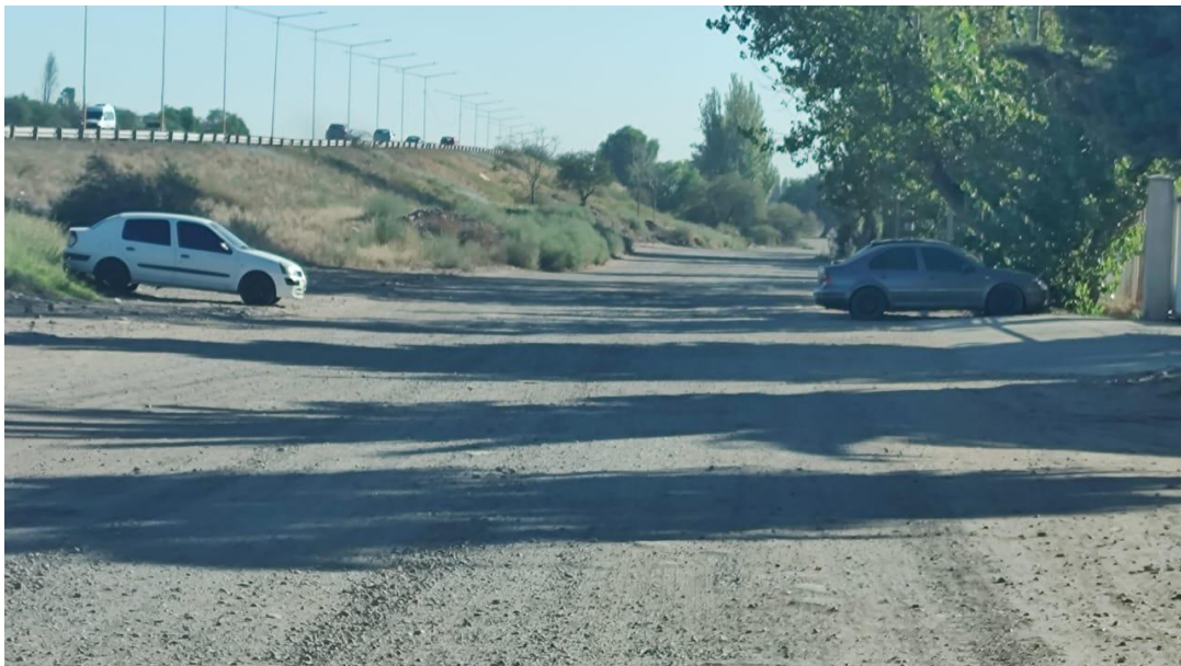
Fotografía 27. Muestra el estado de la calzada entre Calle Araoz y calle J.J. Paso.
