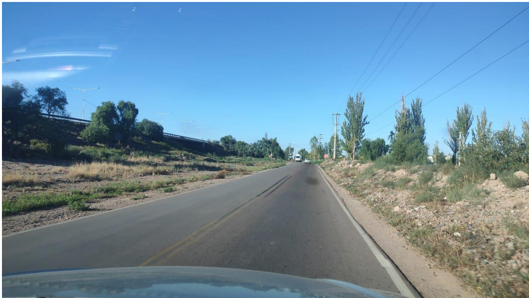
Fotografía 26. RN N 40 – J.J. Paso-Azcuénaga- Colectora Oeste (Descendente). Otra vista de la calzada y banquina después del cruce con calle Castro Barros.
