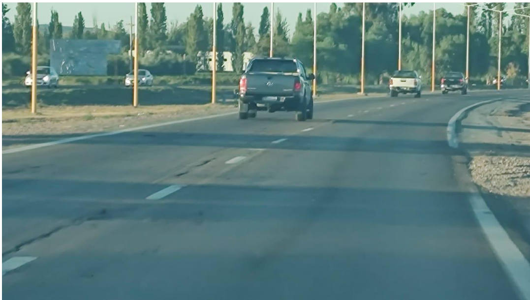
Fotografía 20. Muestra el estado de la calzada y la banquina externa entre calle Araoz y calle Azcuénaga.
