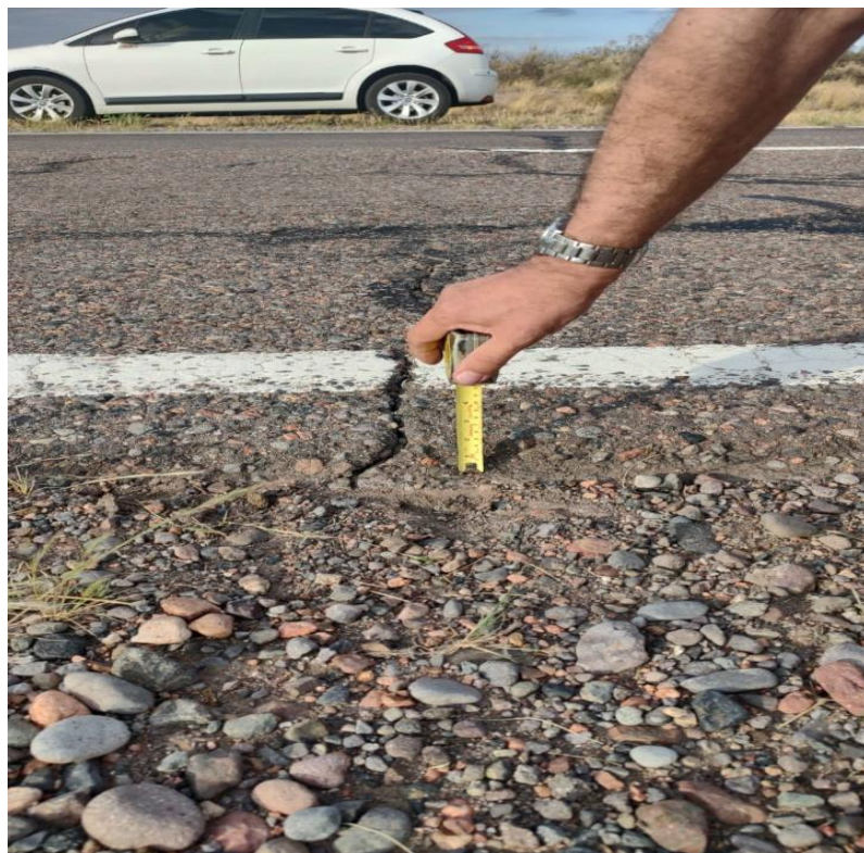
Fotografía 8. Muestra el espesor de la carpeta de rodamiento.
