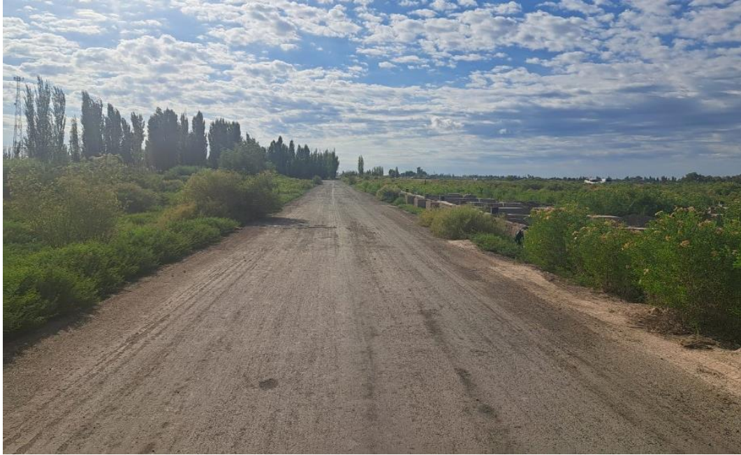
Fotografía 25. Muestra el estado de la calzada y las banquetas entre calle Nicola Serpa y calle Lamadrid.
