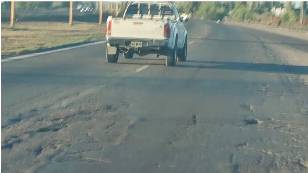
Fotografía 16. Muestra el estado de la calzada entre calle Araoz y calle Azcuénaga.
