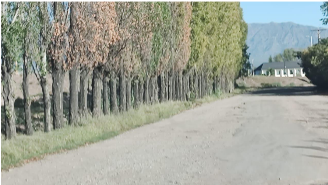
Fotografía 25. Muestra el estado de la calzada entre Calle Araoz y calle J.J. Paso.
