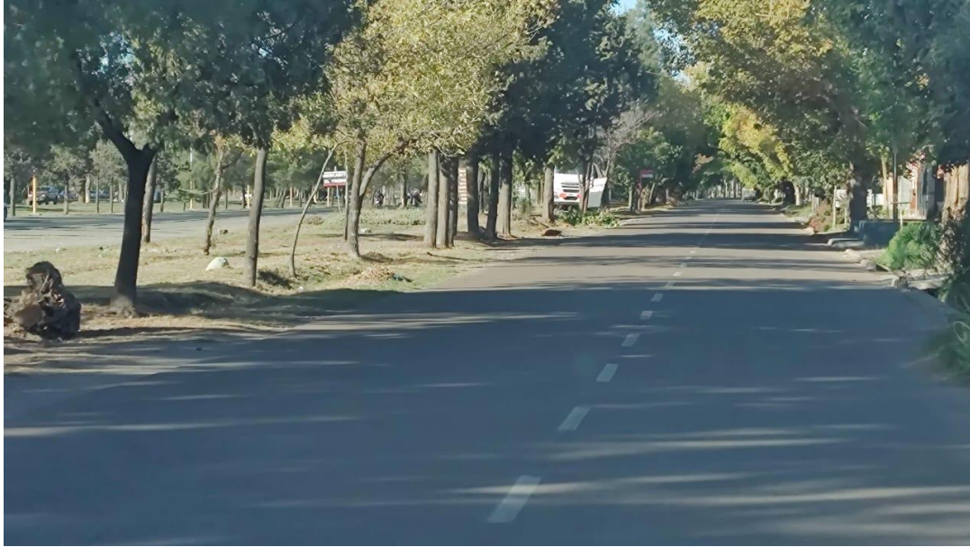
Fotografía 49. RN N 40 – J.J. Paso-Azcuénaga- Colectora Oeste (Descendente)
