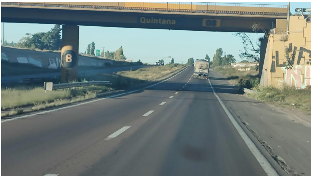
Fotografía 10: Muestra el estado de la calzada y banquetas. Zona Puente Quintana. Tramo Intersección Azcuénaga, Ruta 7
