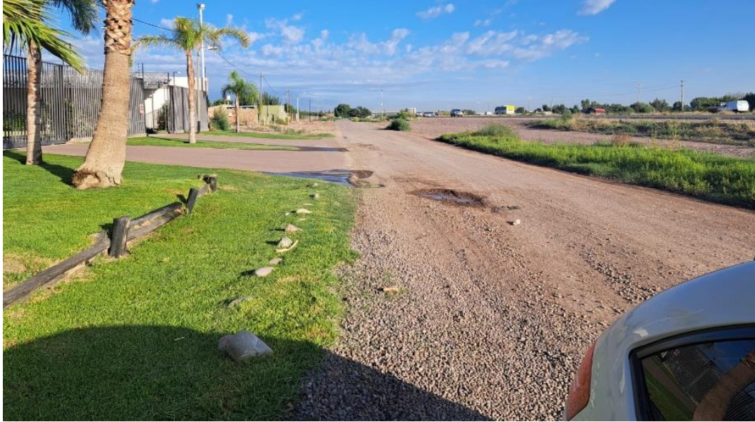
F Fotografía 17. Muestra el estado de la calzada y las banquetas entre calle Tirasso y calle Nicola Serpa.
