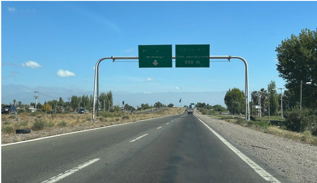
Fotografía 15. Muestra el estado de la calzada y las banquetas entre calle Medina y calle Los Álamos. – Zona de Juan L. Beltrán.
