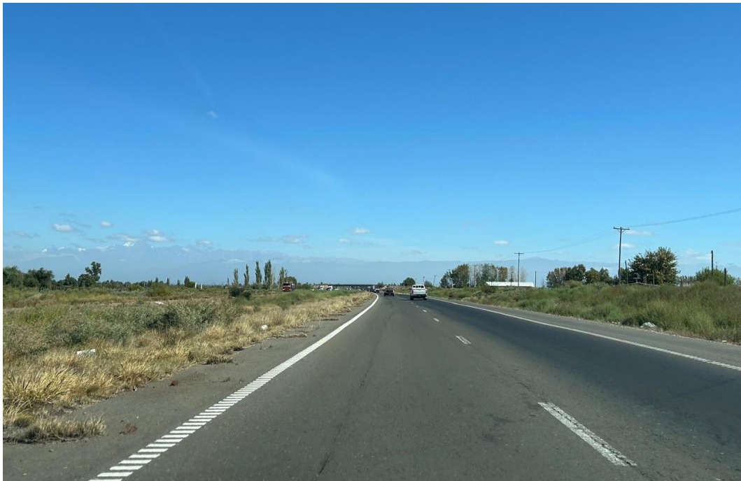
Fotografía 2. Muestra el estado de la calzada y las banquetas entre calle San Pedro y calle Medina.
