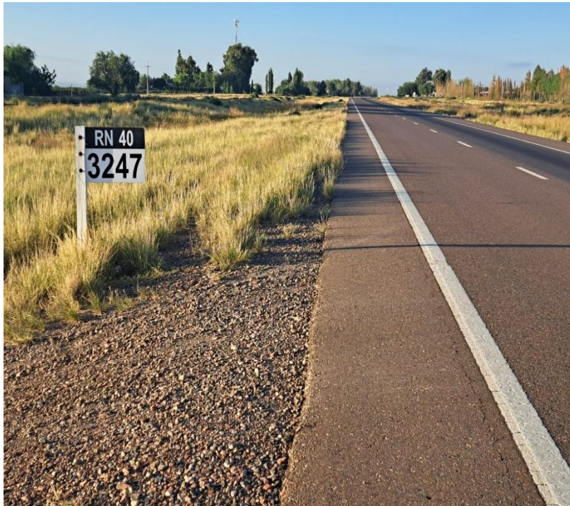
Fotografía 9. Muestra la banquina interna en el kilómetro 3247.
