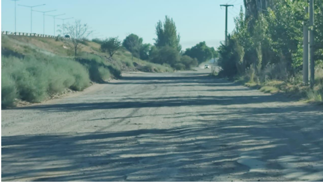
Fotografía 28. Muestra el estado de la calzada entre Calle Araoz y calle J.J. Paso.
