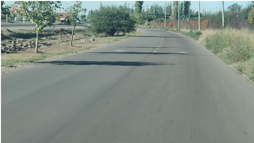
Fotografía 34. RN N 40 – J.J. Paso-Azcuénaga- Colectora Oeste (Descendente). Otra vista de la calzada y banquina después del cruce con calle Araoz.
