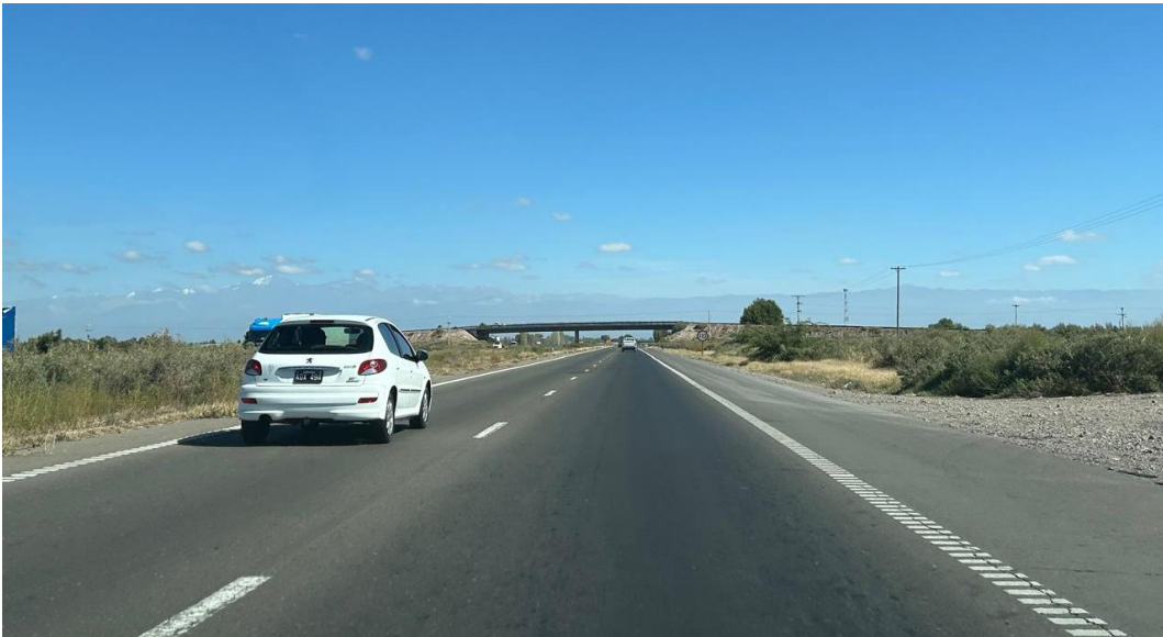
Fotografía 4. Muestra el estado de la calzada y las banquetas entre calle San Pedro y calle Medina.
