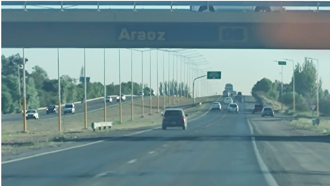
Fotografía 18. Muestra el estado de la calzada y las banquetas entre calle Azcuénaga y Calle Araoz.
