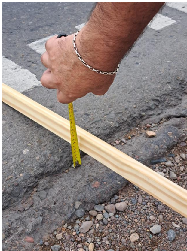
Fotografía 4. Muestra el espesor de la carpeta entre calle Tirasso y R. P. 50
