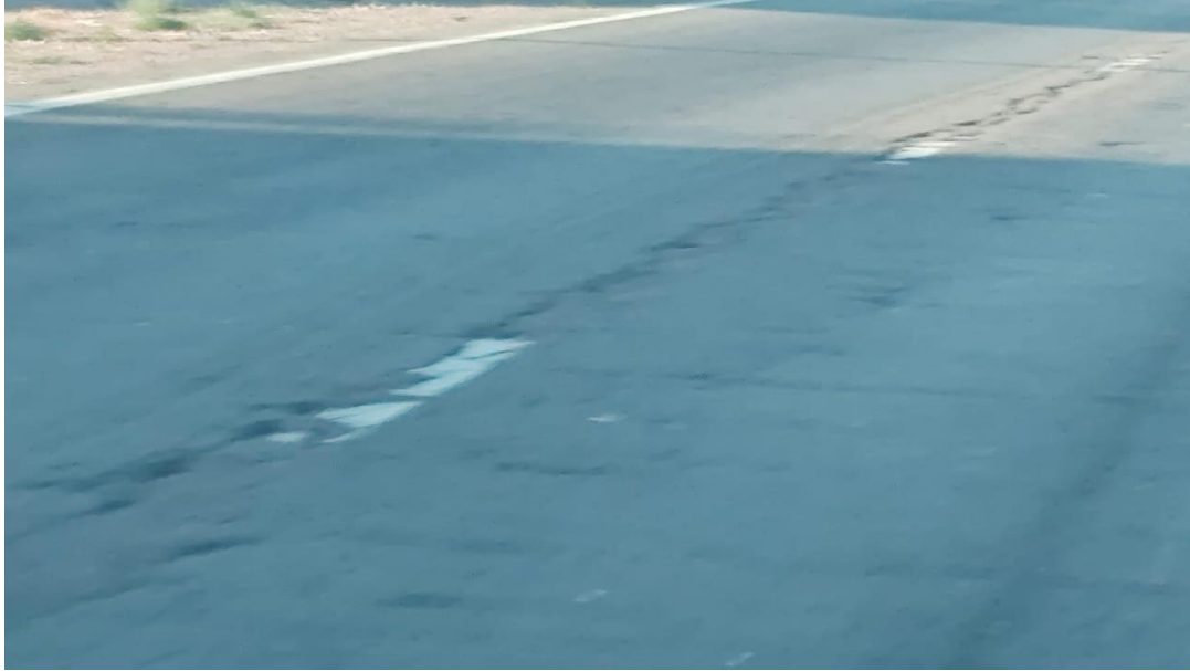
Fotografía 21. Muestra el estado de la calzada entre calle Araoz y calle Azcuénaga.
