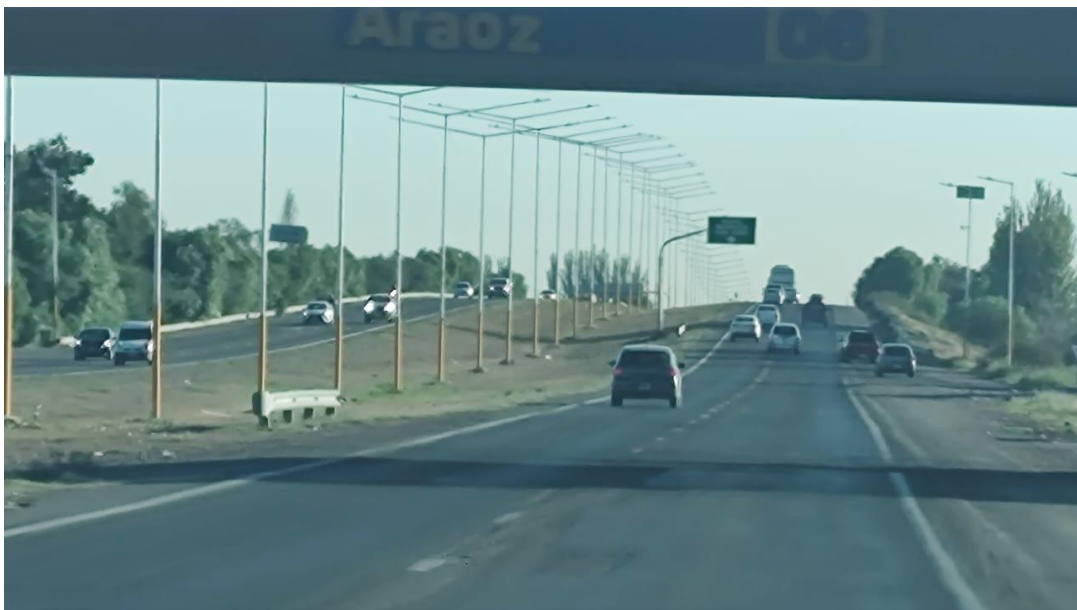
Fotografía 19. Muestra el estado de la calzada y las banquetas entre calle Araoz y J.J. Paso.
