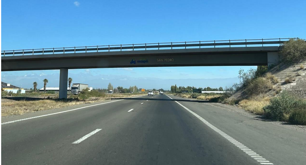
Fotografía 5. Muestra el estado de la calzada y las banquetas entre calle San Pedro y calle Medina. Cruce calle San Pedro.
