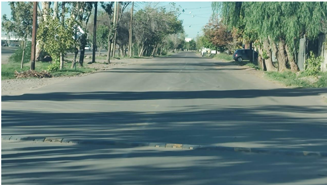
Fotografía 2. RN N 40 – J.J. Paso-Azcuénaga- Colectora Oeste (Descendente). Vista de la calzada después de J.J. Paso.
