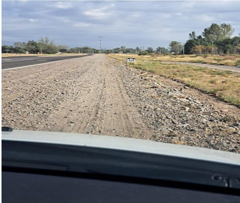
Fotografía 1. Muestra el estado de la banquina en el inicio del tramo en el poste kilométrico 535.
