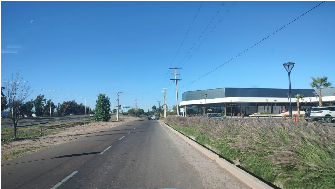
Fotografía 24. RN N 40 – J.J. Paso-Azcuénaga- Colectora Oeste (Descendente). Otra vista de la calzada y la banquina-cordón-cuneta después del cruce con calle Castro Barros.
