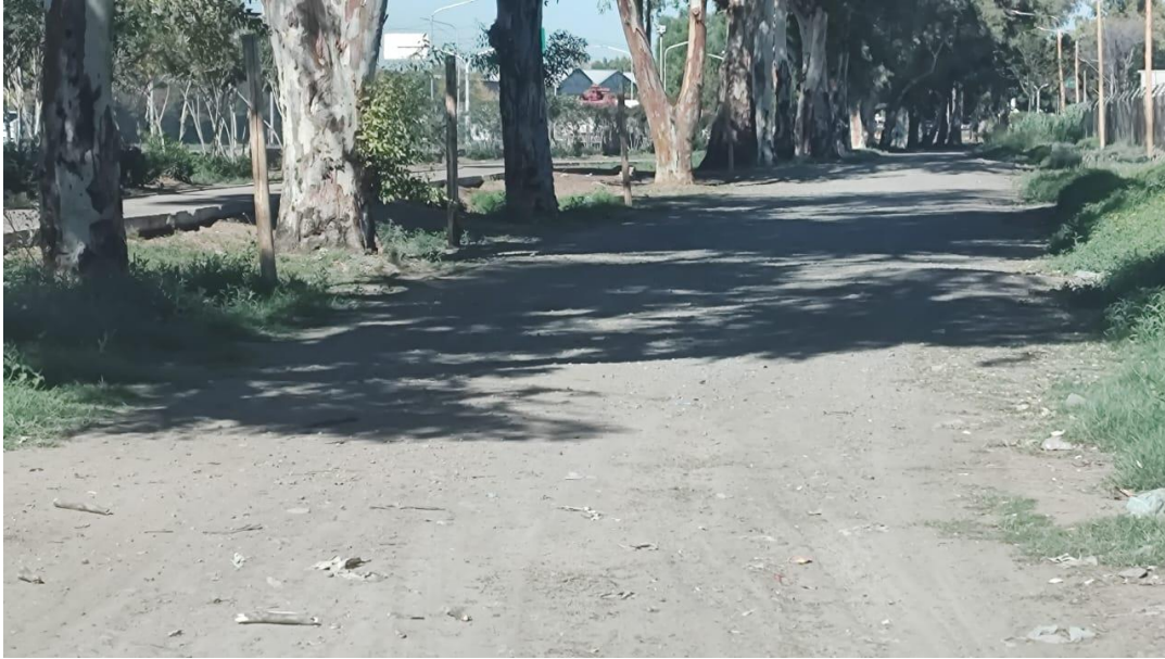
Figura 5. Vista del tipo y estado de la calzada entre calle Los Pescadores y Pedro P. Segura.
