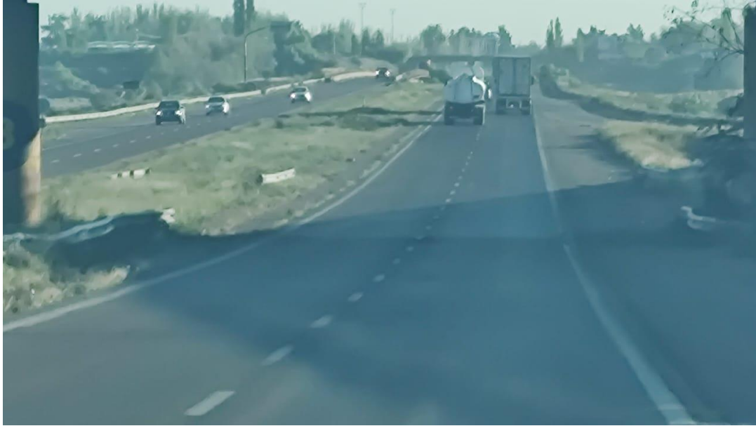
Fotografía 21: Muestra el estado de la calzada y banquetas. Tramo Intersección Ruta 7 y Azcuénaga.
