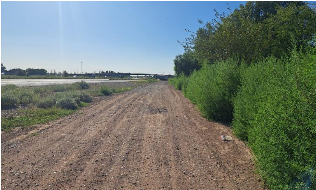
Fotografía 29. Muestra el estado de la calzada y las banquetas entre calle Nicola Serpa y calle Laprida.
