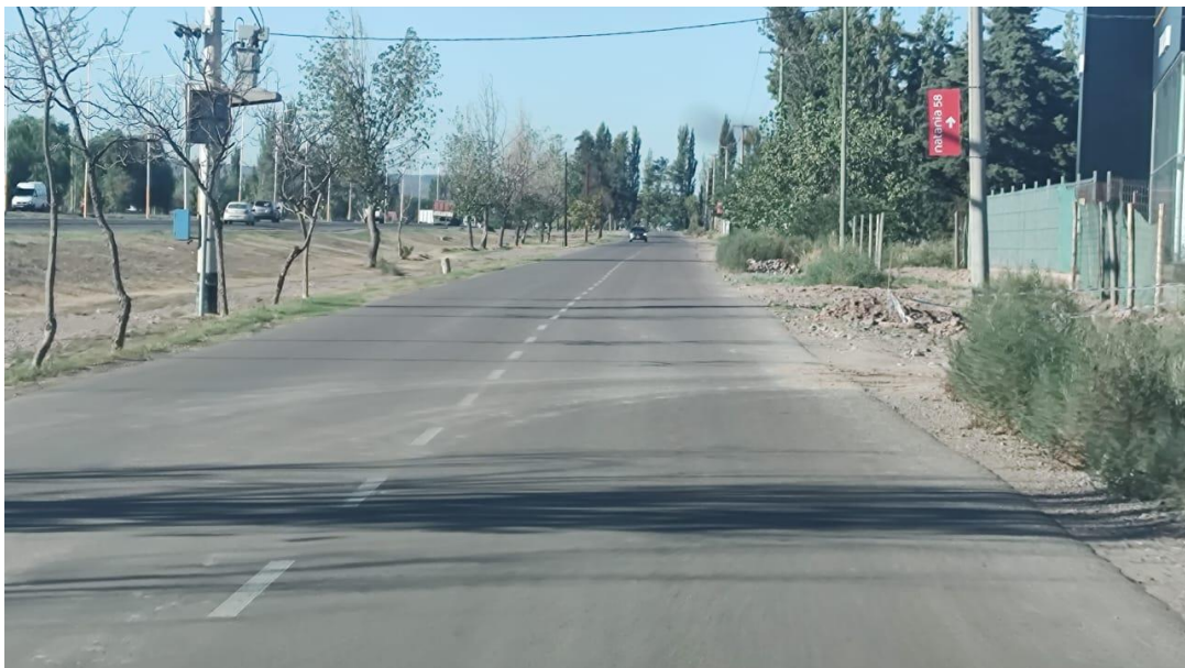
Fotografía 38. RN N 40 – J.J. Paso-Azcuénaga- Colectora Oeste (Descendente). Otra vista de la calzada y banquina después del cruce con calle Araoz.
