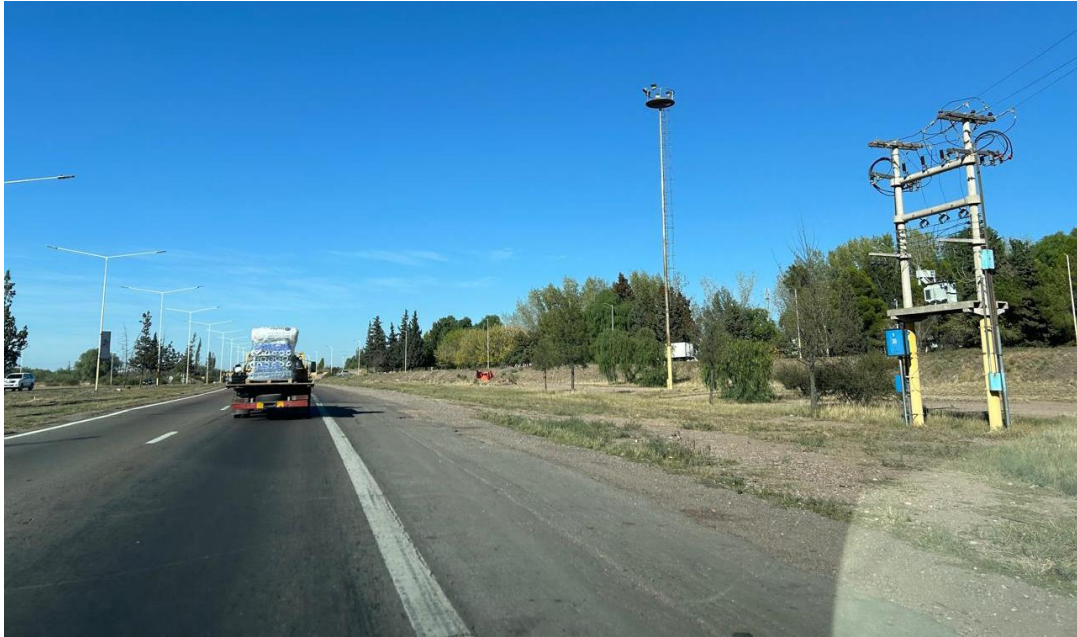
Fotografía 1: Muestra el estado de la calzada, rama salida Azcuénaga. Tramo Intersección Azcuénaga, Ruta 7, colectora Oeste.
