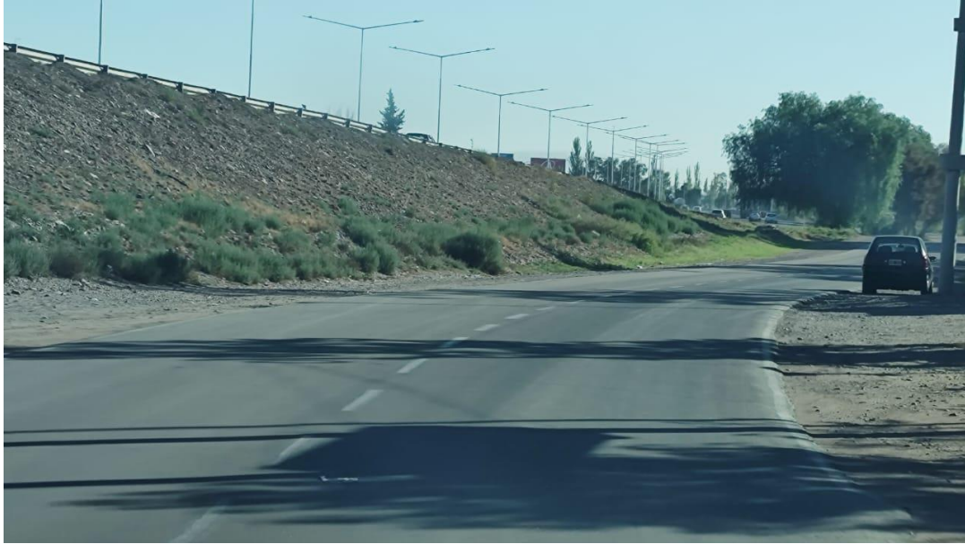
Fotografía 11. Muestra el estado de la calzada entre Calle Azcuénaga y Calle Araoz.
