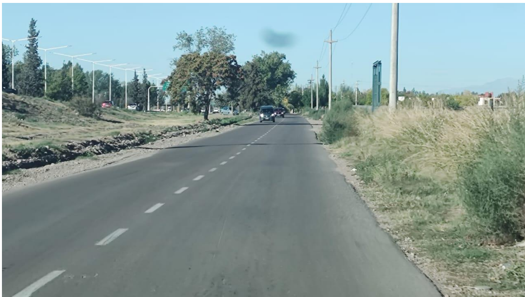
Fotografía 46. RN N 40 – J.J. Paso-Azcuénaga- Colectora Oeste (Descendente)
