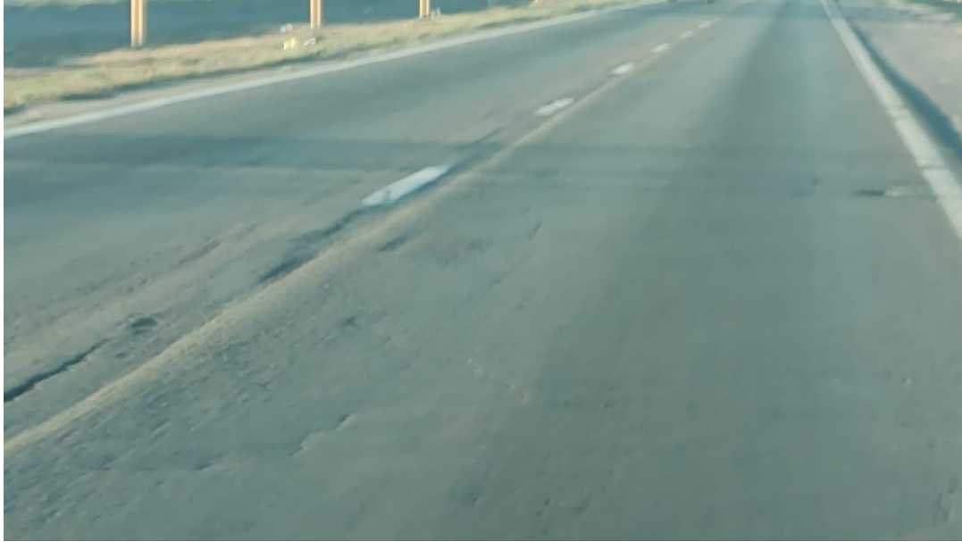
Fotografía 17. Muestra el estado de la calzada entre calle Araoz y calle Azcuénaga.
