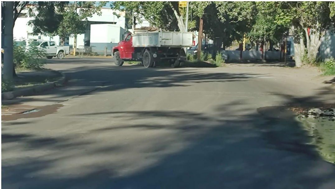
Fotografía 50. RN N 40 – J.J. Paso-Azcuénaga- Colectora Oeste (Descendente)
