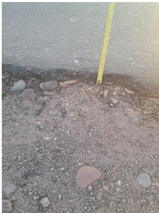
Fotografía 2. Muestra el espesor de la calzadas entre calle Tirazzo y R. P. 50
