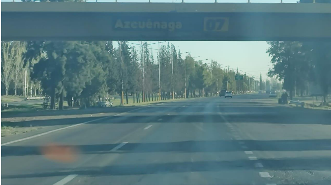
Fotografía 1. Calle Azcuénaga – Inicio del tramo.
