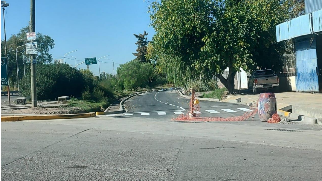
Figura 13. Vista del tipo y estado de la calzada en el cruce con Av. Independencia.
