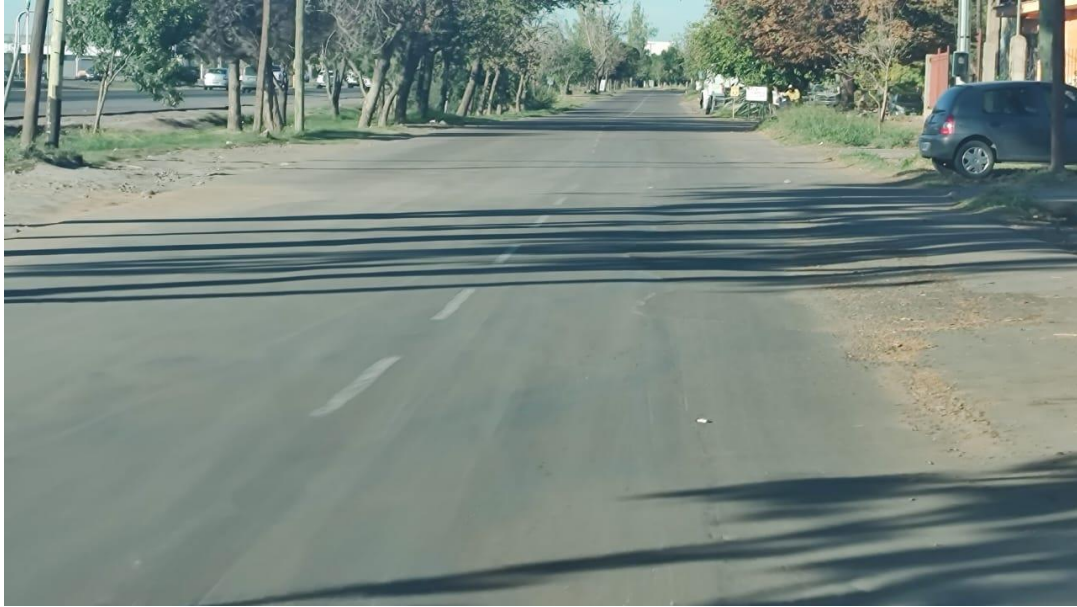
Fotografía 5. RN N 40 – J.J. Paso-Azcuénaga- Colectora Oeste (Descendente). Vista de la calzada y banquetas después de J.J. Paso y próxima al cruce con calle Malabia.
