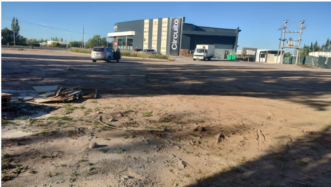
Fotografía 22. RN N 40 – J.J. Paso-Azcuénaga- Colectora Oeste (Descendente). Vista de la calzada de ripio y banquina después del cruce con calle Castro Barros.
