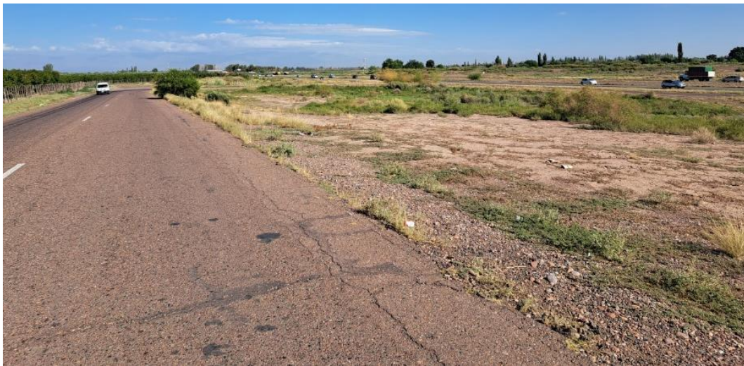
Fotografía 32. Muestra el estado de la calzada y las banquetas entre calle Nicola Serpa y calle Laprida.
