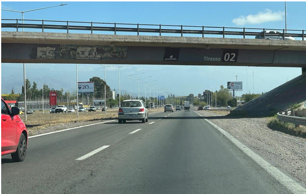
Fotografía 24. Muestra el estado de la calzada y las banquetas entre calle Los Álamos y Calle Tirasso. Fin del tramo
