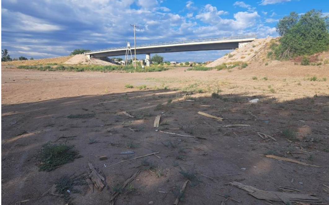
Fotografía 15. Muestra el estado de la calzada y las banquetas entre calle Nicola Serpa y calle Lamadrid.
