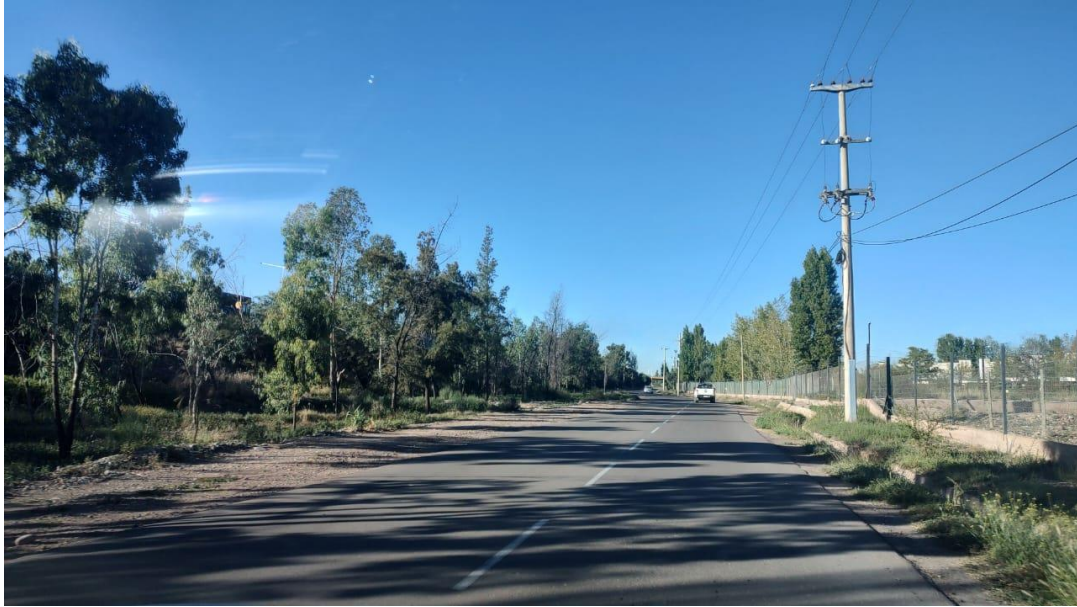
Fotografía 29. RN N 40 – J.J. Paso-Azcuénaga- Colectora Oeste (Descendente). Muestra la calzada y banquina después del cruce con calle Bulnes.
