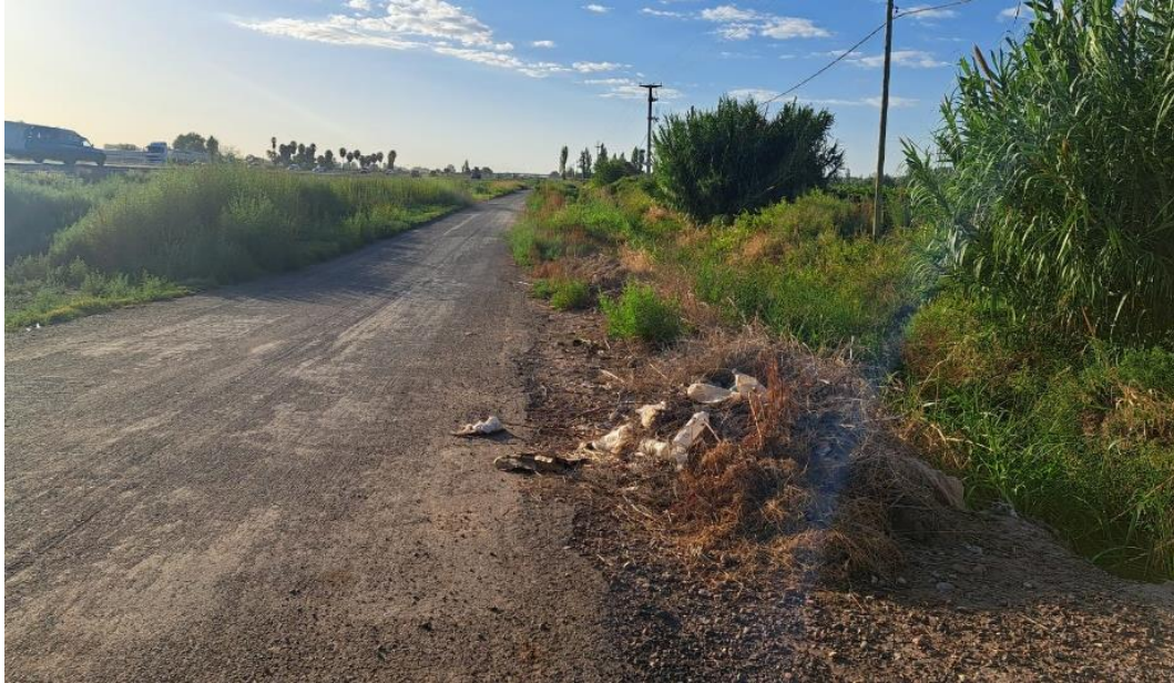
Fotografía 13. Muestra el estado de la calzada y las banquetas entre calle Tirasso y calle Nicola Serpa.
