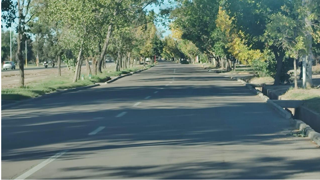
Fotografía 47. RN N 40 – J.J. Paso-Azcuénaga- Colectora Oeste (Descendente)
