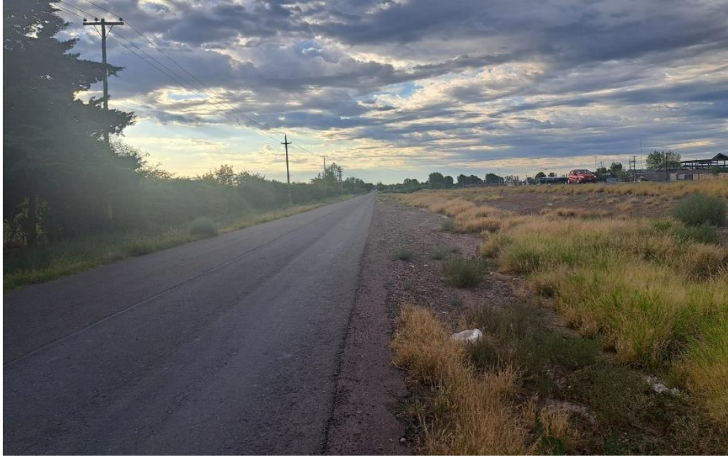
Fotografía 9. Muestra el estado de la calzada y las banquetas entre calle Tirazzo y R. P. 50
