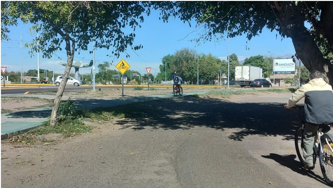
Figura 1. Vista del tipo y estado de la calzada entre Rotonda del Avión y calle Los Pescadores.
