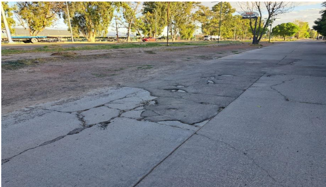
Fotografía 6. Vista del tipo y estado de la calzada entre la rotonda del Avi3 y calle Los Pescadores
