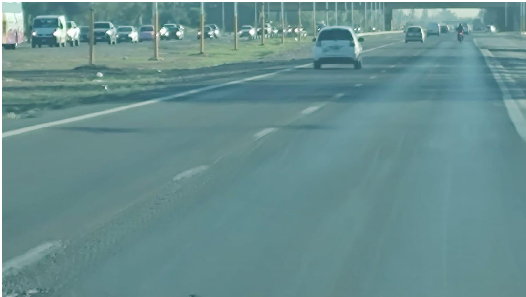
Fotografía 28. Muestra el estado de la calzada y las banquetas entre calle Araoz y J.J. Paso.
