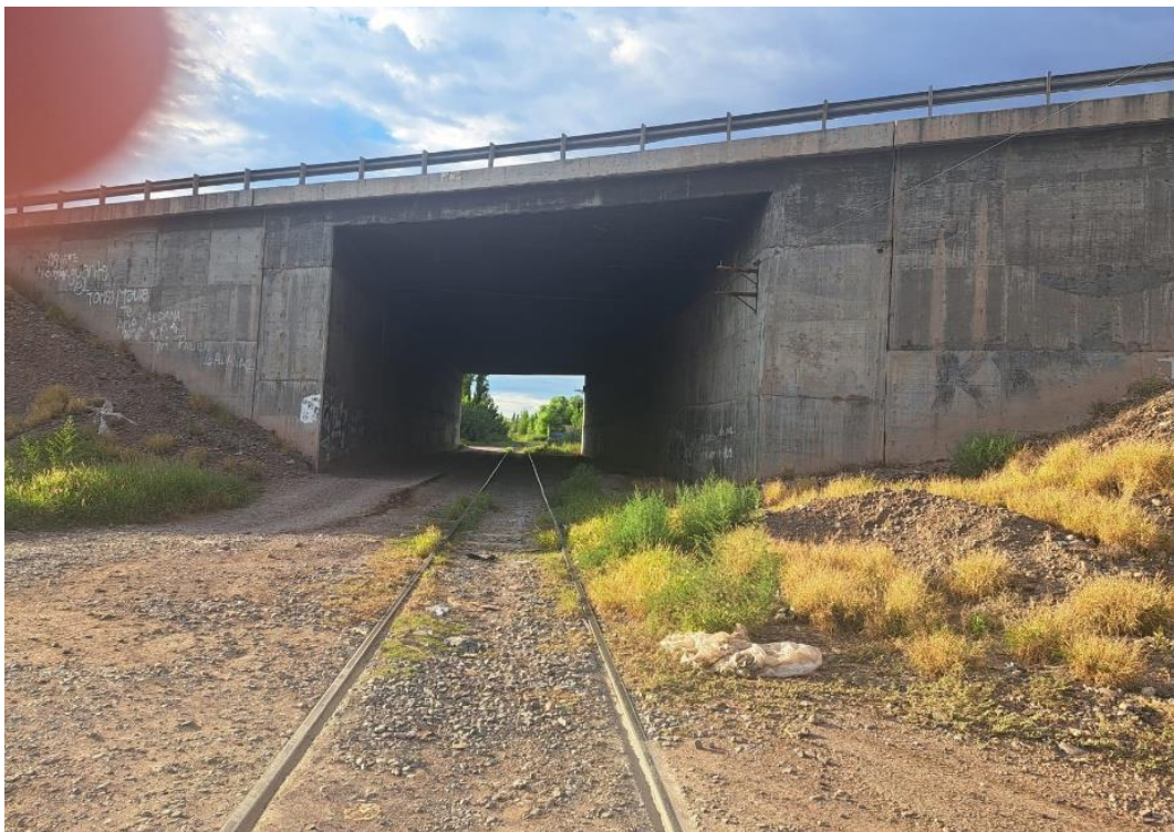
Fotografía 10. Muestra el cruce ferroviario entre calle Tirazzo y R. P. 50
