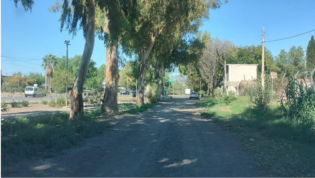
Figura 3. Vista del tipo y estado de la calzada entre Rotonda del Avión y calle Los Pescadores.
