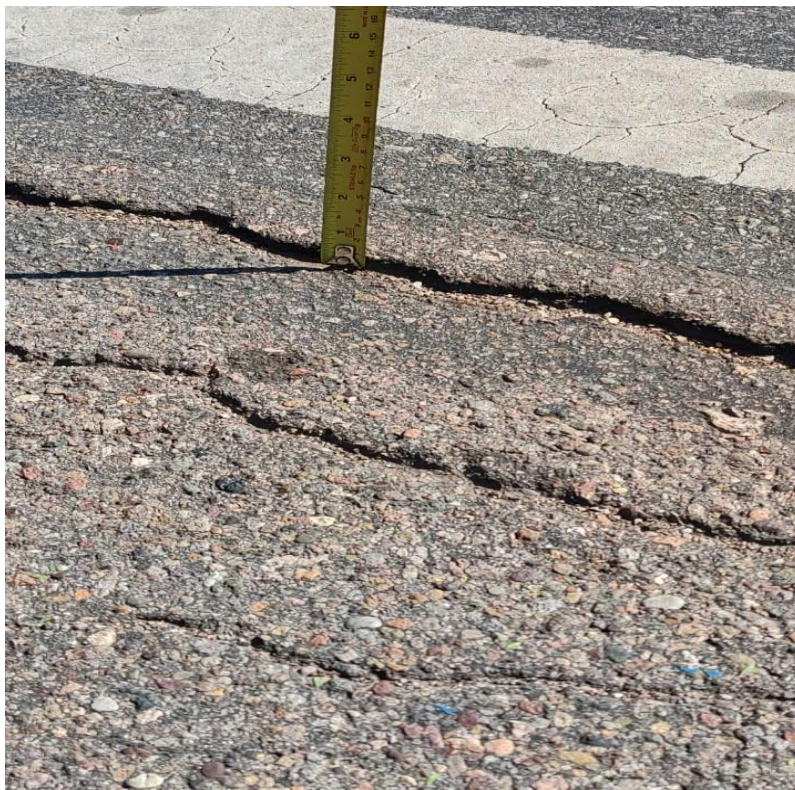
Fotografía 30. Muestra el espesor del slurry en la zona del puente del Arrollo La Hedionda.
