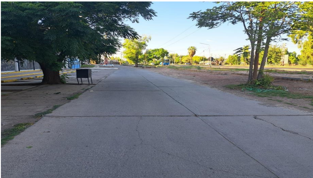
Fotografía 8. Vista del tipo y estado de la calzada entre Manuel A. Sáenz y Rotonda Gral. Paz
