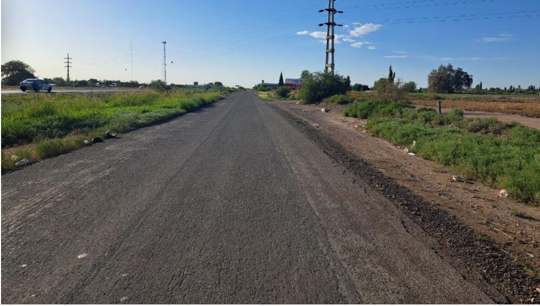
Fotografía 19. Muestra el estado de la calzada y las banquetas entre calle Nicola Serpa y calle Laprida.
