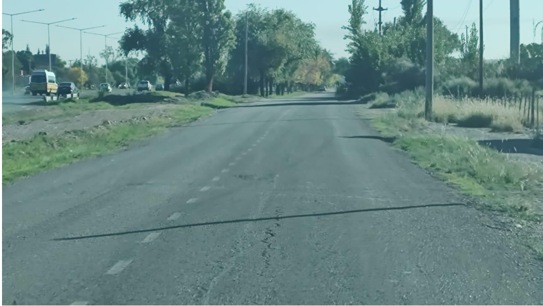
Fotografía 38. Muestra el estado de la calzada entre Calle Araoz y calle J.J. Paso.
