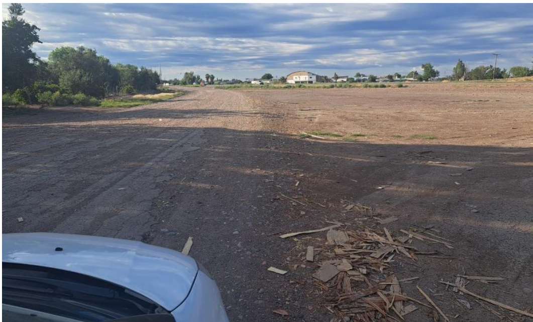
Fotografía 18. Muestra el estado de la calzada y las banquetas entre calle Nicola Serpa y calle Lamadrid.
