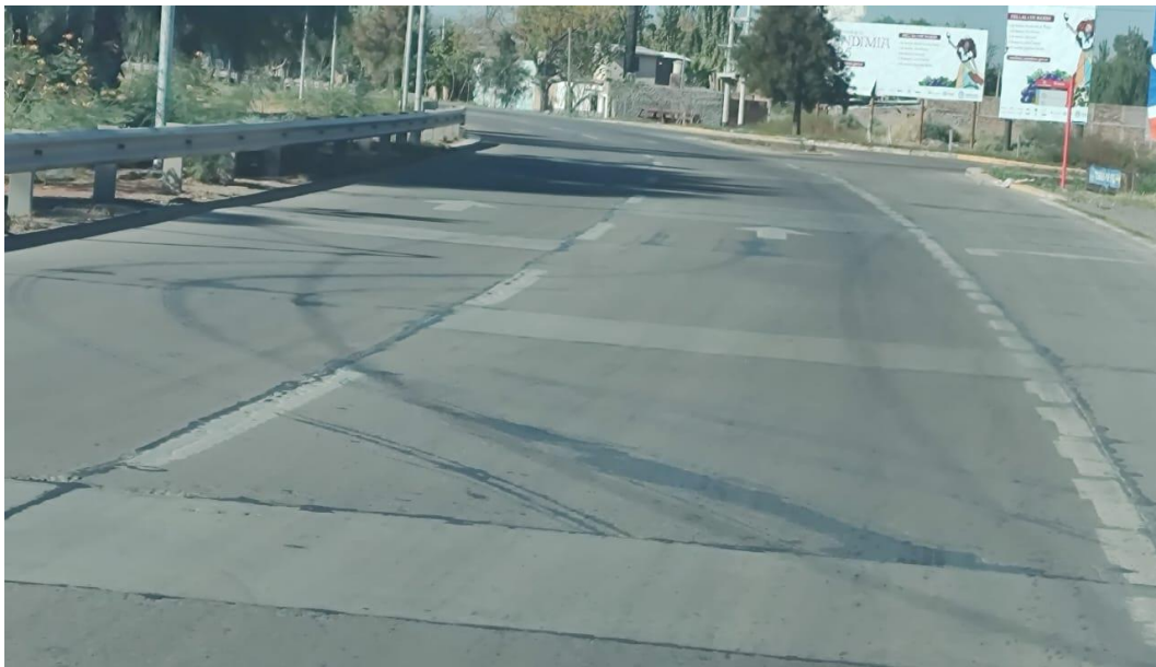
Fotografía 2. Calzada Principal – Descendente. Muestra las reparaciones de la calzada y el estado de las juntas después del inicio del tramo.
