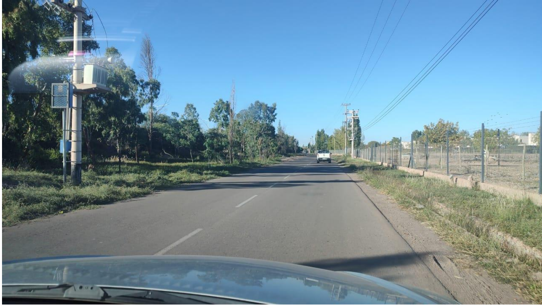
Fotografía 27. RN N 40 – J.J. Paso-Azcuénaga- Colectora Oeste (Descendente). Otra vista de la calzada y banquina entre calle Castro Barros y calle Bulnes.
