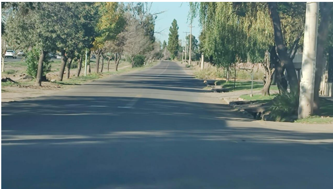
Fotografía 10. RN N 40 – J.J. Paso-Azcuénaga- Colectora Oeste (Descendente). Vista de la calzada y banquetas entre calle Malabia y calle Boedo.
