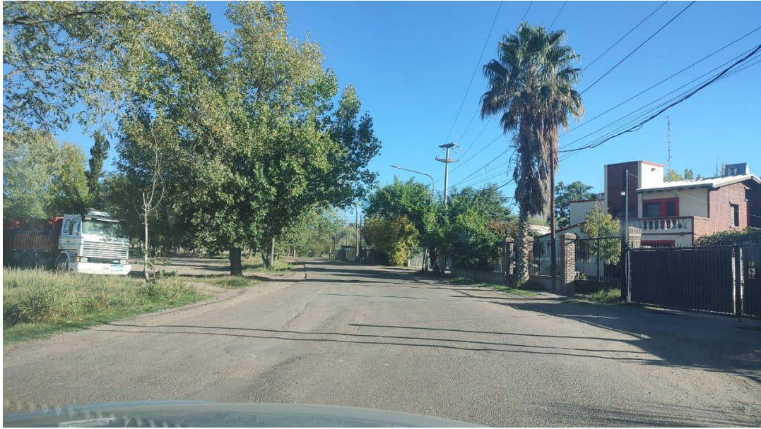
Fotografía 1. Muestra el estado de la calzada calle Azcuénaga. Inicio del tramo.
