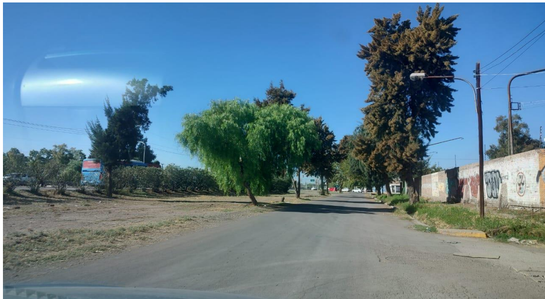
Figura 12. Vista del tipo y estado de la calzada entre calle Gral. Paz e Independencia.
