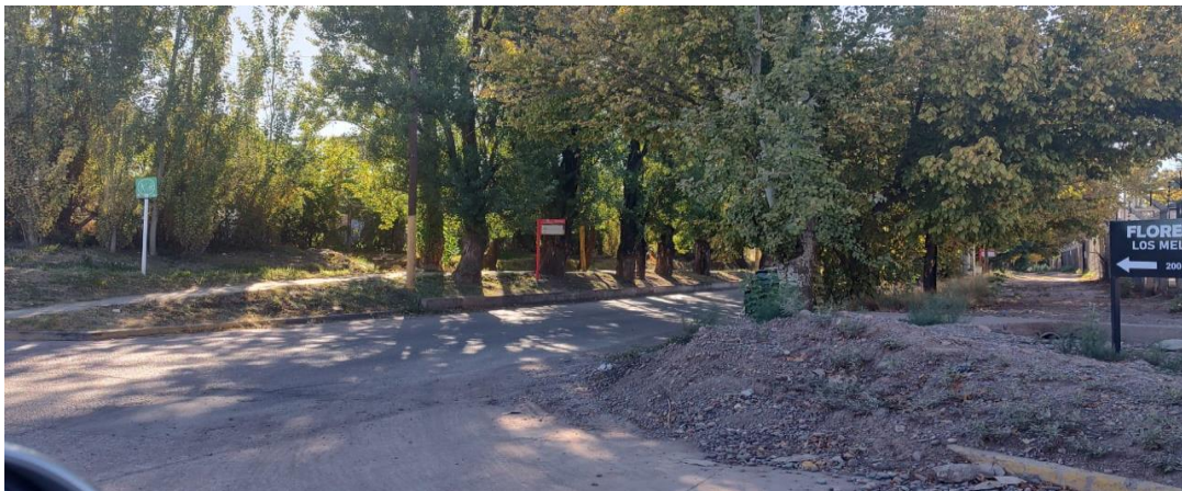
Fotografía 10. Muestra el estado de la calzada entre Calle Azcuénaga y Calle Araoz. Cruce con calle Anchorena.
