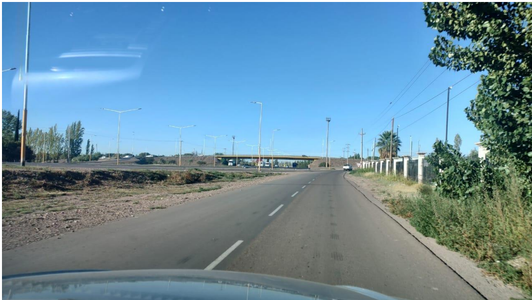
Fotografía 30. RN N 40 – J.J. Paso-Azcuénaga- Colectora Oeste (Descendente). Muestra la calzada y banquina antes del cruce con calle Araoz.
