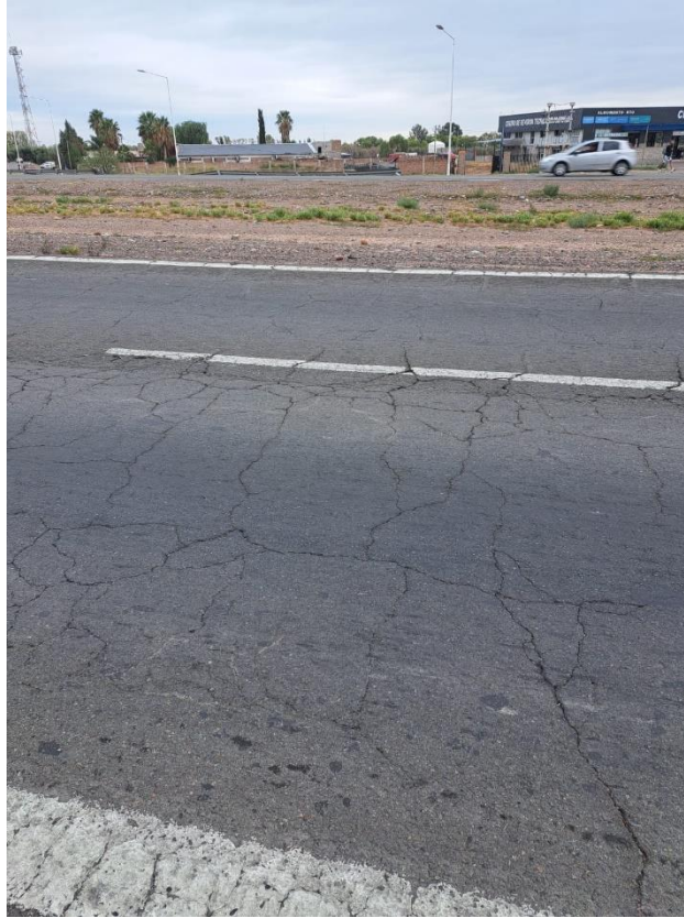
Fotografía 21. Muestra el estado de la calzada entre R.P. 50 y calle Lamadrid.
