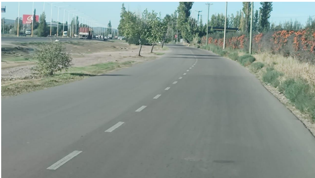
Fotografía 36. RN N 40 – J.J. Paso-Azcuénaga- Colectora Oeste (Descendente). Otra vista de la calzada y banquina después del cruce con calle Araoz.
