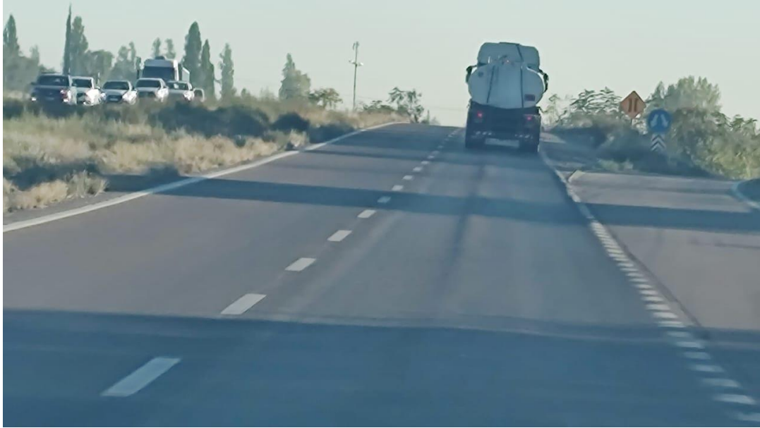
Fotografía 15: Muestra el estado de la calzada y banquetas. Tramo Intersección Ruta 7 y Azcuénaga.
