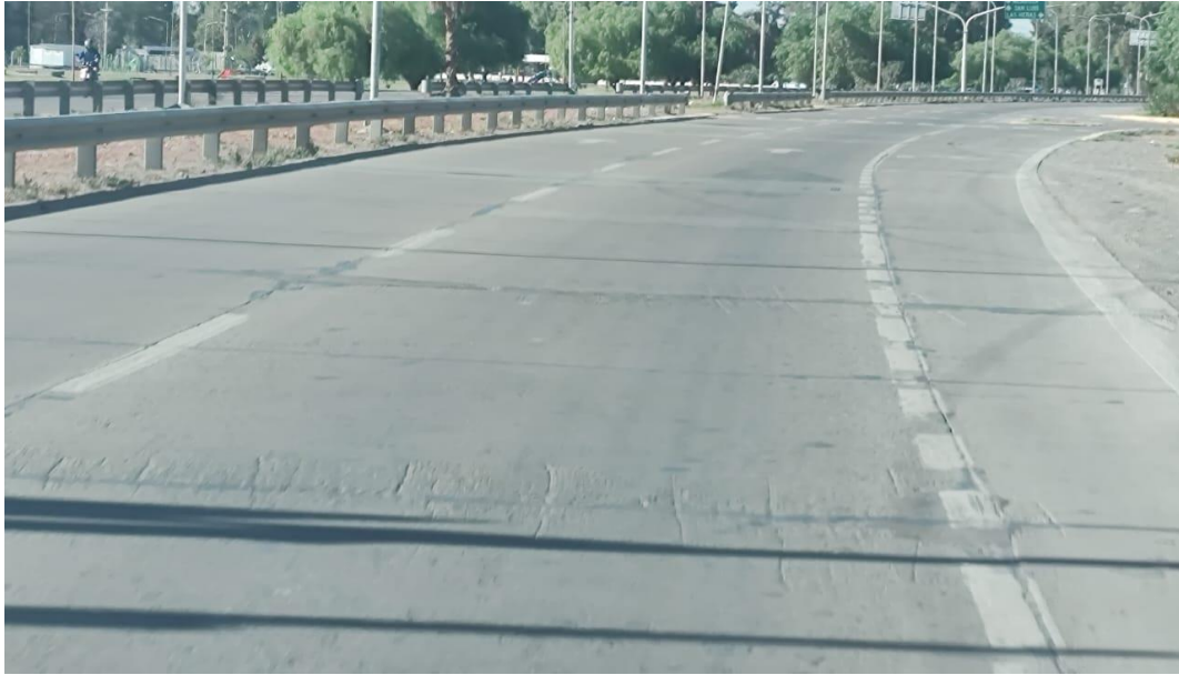
Fotografía 5. Calzada Principal – Descendente. Muestra fresado de la loza de hormigón y el estado de las juntas en cruce con calle Libertad.
