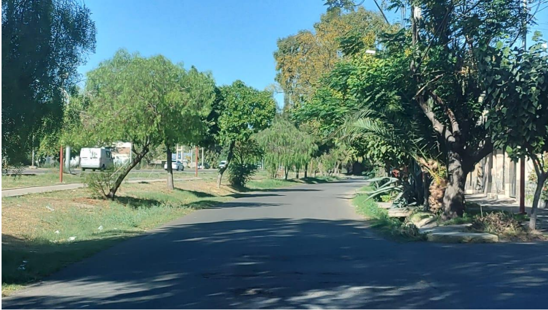
Figura 9. Vista del tipo y estado de la calzada entre calle Pedro P. Segura y Manuel A. Sáenz.
