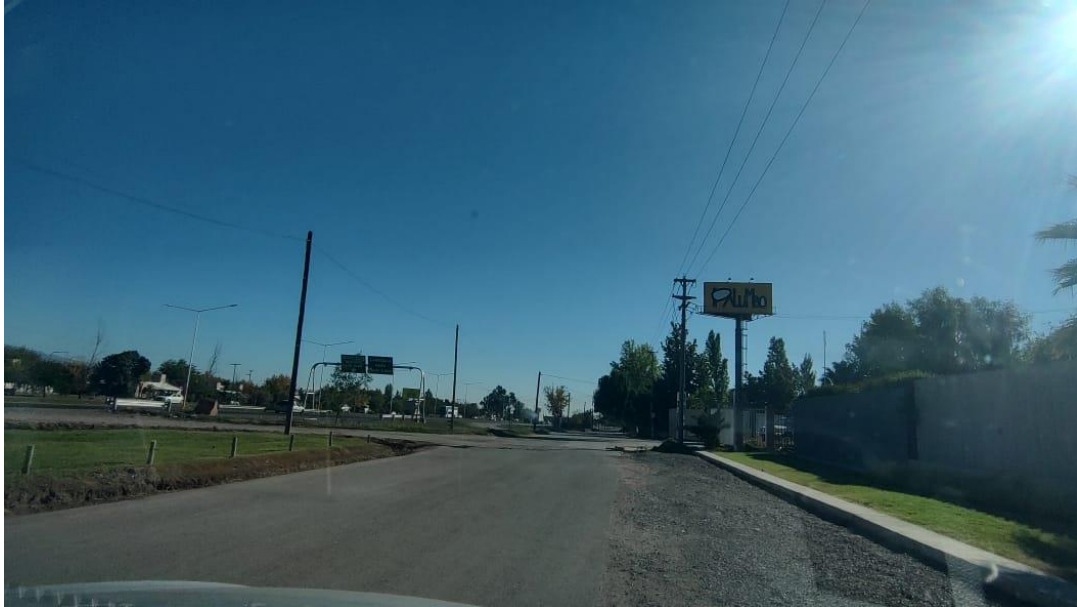
Fotografía 42. Muestra el estado de la calzada entre Calle Araoz y calle J.J. Paso.
