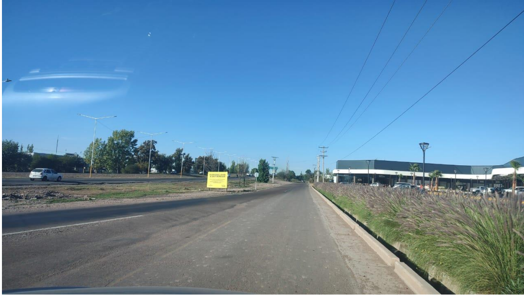
Fotografía 23. RN N 40 – J.J. Paso-Azcuénaga- Colectora Oeste (Descendente). Vista de la calzada y la banquina-cordón-cuneta después del cruce con calle Castro Barros.
