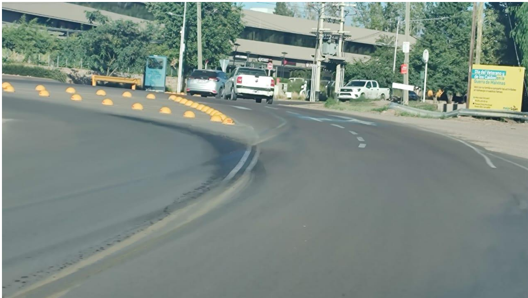
Fotografía 14. RN N 40 – J.J. Paso-Azcuénaga- Colectora Oeste (Descendente). Vista de cruce con calle Boedo.
