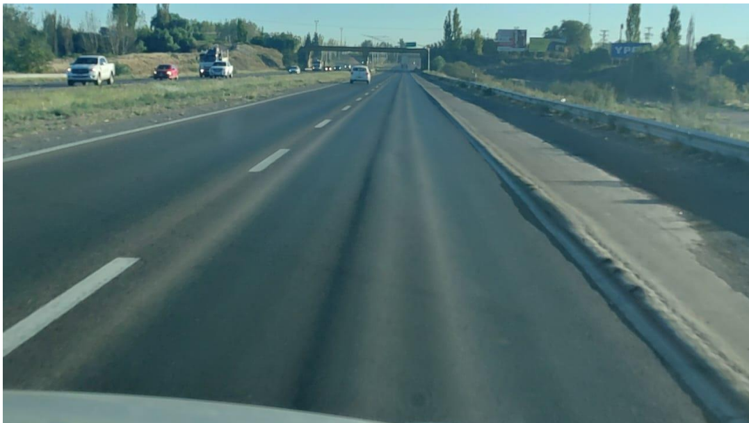
Fotografía 24: Muestra el estado de la calzada y banquetas. Tramo Intersección Ruta 7 y Azcuénaga.
