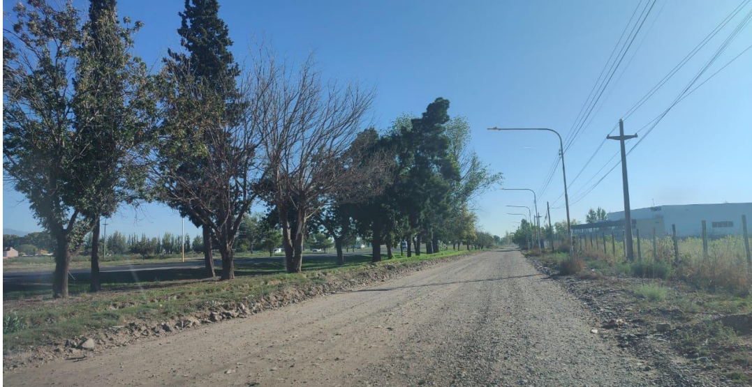
Fotografía 7. Muestra el estado de la calzada entre Calle Azcuénaga y Calle Araoz.
