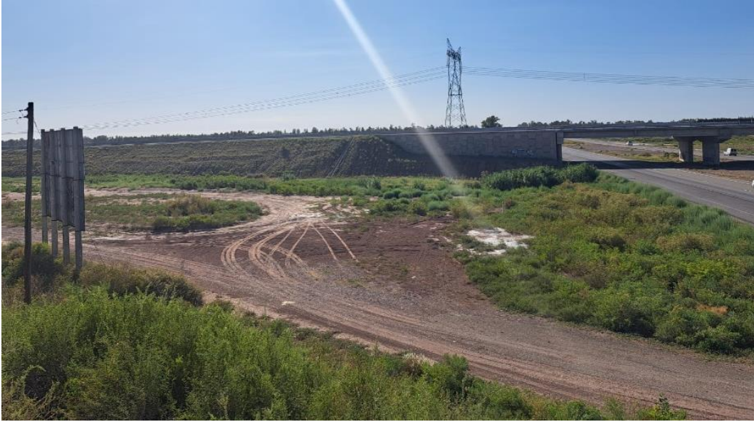
Fotografía 35. Muestra el puente de calle Laprida. Fin del tramo.
