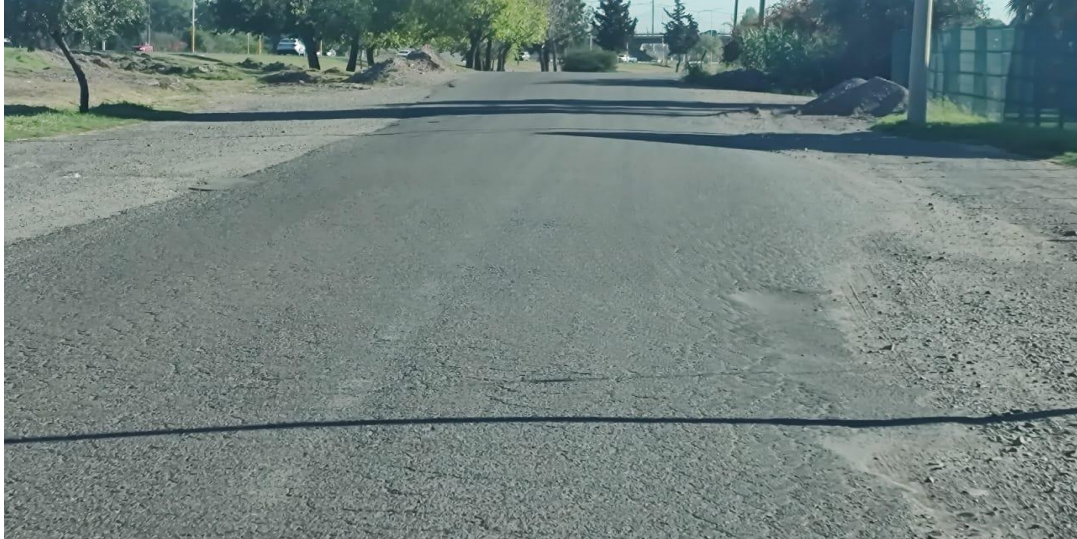
Fotografía 20. Muestra el estado de la calzada entre Calle Azcuénaga y Calle Araoz.
