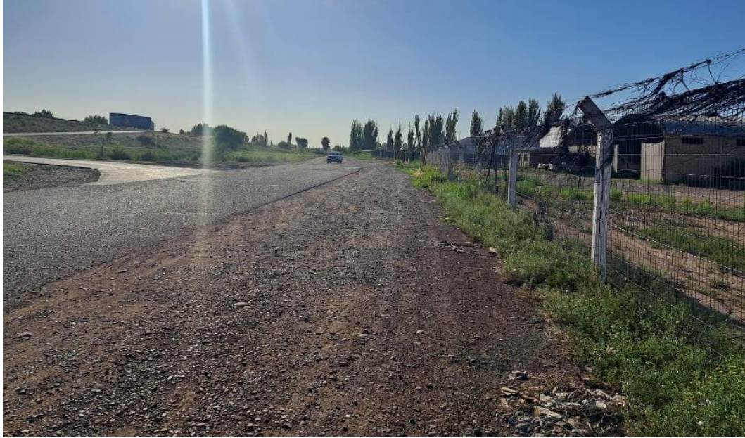
Fotografía 23. Muestra el estado de la calzada y las banquetas entre calle Nicola Serpa y calle Laprida.
