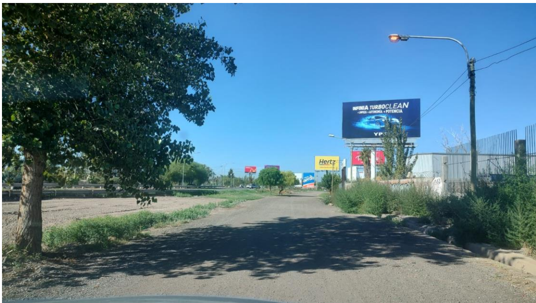
Figura 16. Vista del tipo y estado de la calzada entre calle Constitución y Libertad.
