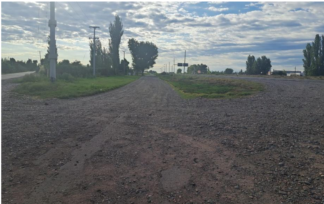
Fotografía 24. Muestra el estado de la calzada y las banquetas entre calle Nicola Serpa y calle Lamadrid.
