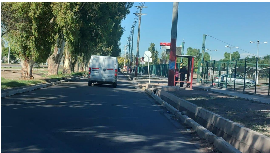
Figura 8. Vista del tipo y estado de la calzada entre calle Pedro P. Segura y Manuel A. Sáenz.
