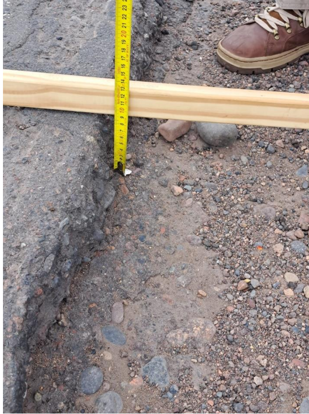
Fotografía 5. Muestra el espesor de la carpeta entre calle Tirasso y R. P. 50
