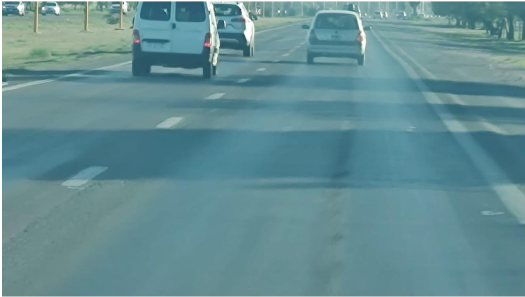
Fotografía 25. Muestra el estado de la calzada y las banquetas entre calle Araoz y J.J. Paso.
