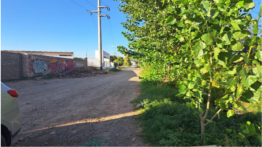
Fotografía 13. Vista del tipo y estado de la calzada entre Libertad y Constitución.
