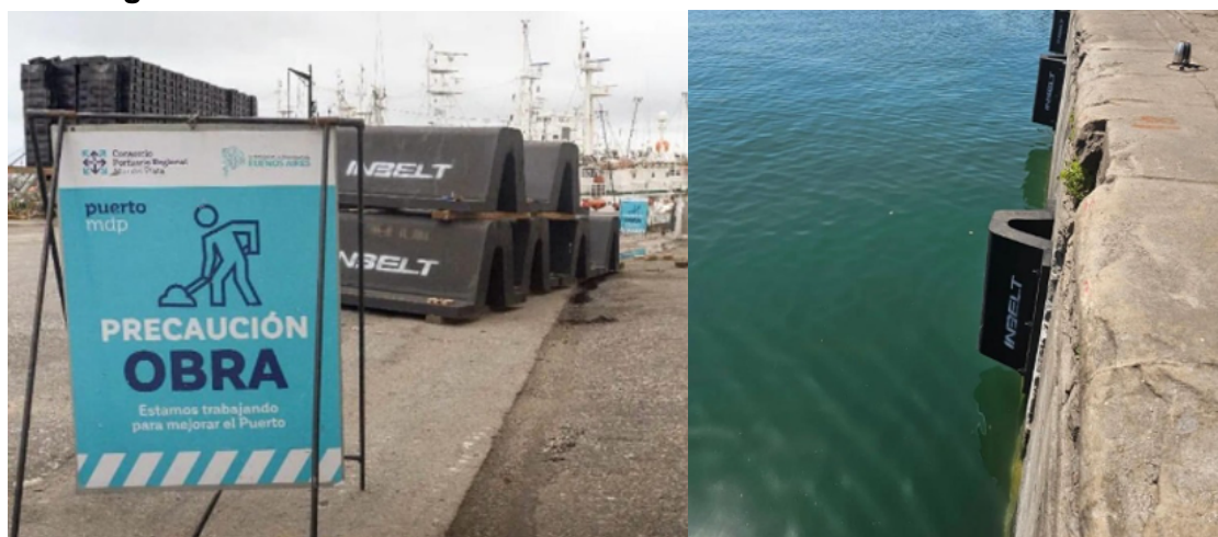
Figura 28: Nuevas Defensas instaladas en el Puerto de Mar del Plata.
