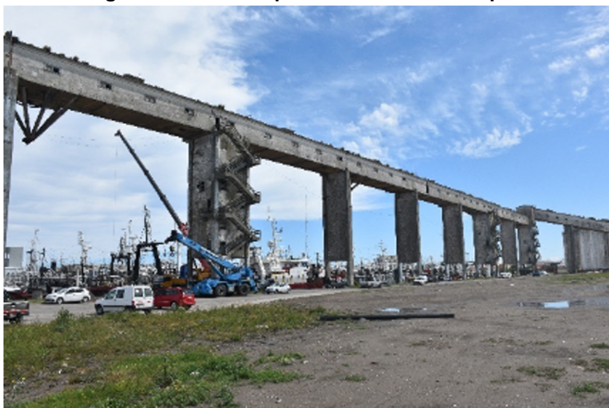
Figura 13: Vista de la galería de embarque fuera de uso en el perímetro del espigón 3.
