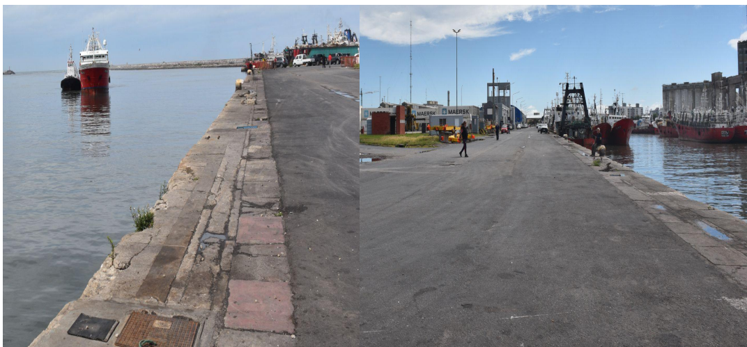
Figura 89: Sección 8 del Espigón 2 del puerto de Mar del Plata. Vista hacia el mar y hacia puerto.
