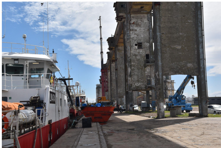
Figura 52: Vista desde el espigón 3 de la sección 13 y galería de granos (izquierda).
