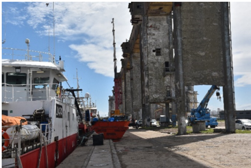
Figura 12: Vista de la galería de embarque fuera de uso en el perímetro del espigón 3.
