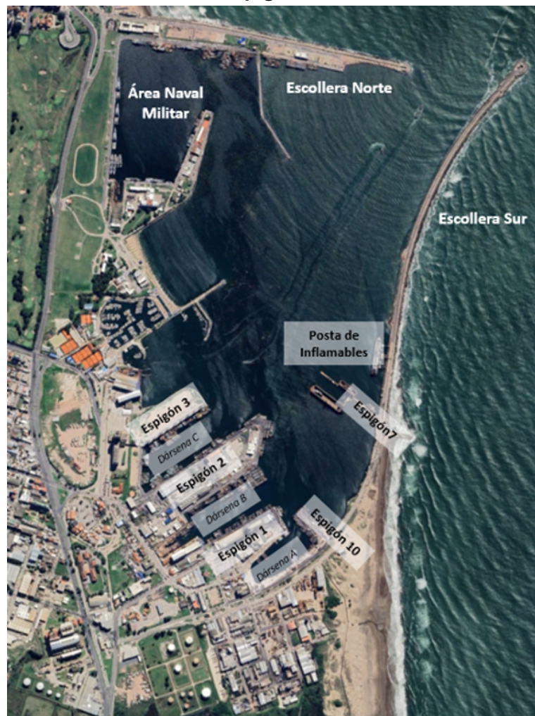
Figura 3: Vista aérea del área portuaria con identificación de escolleras, dársenas y espigones.
