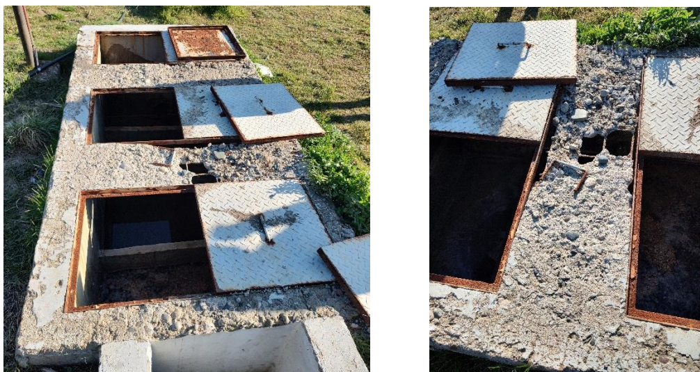
Figura 18: Fotografías 11/09/2024: Cámara Desengrasadora.
