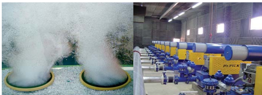
Uso en aireación de efluentes líquidos con difusores a membrana
