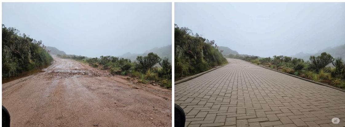
Figura 28 - Tramo del camino (izquierda: situación actual / derecha: ejemplo pavimentado)
