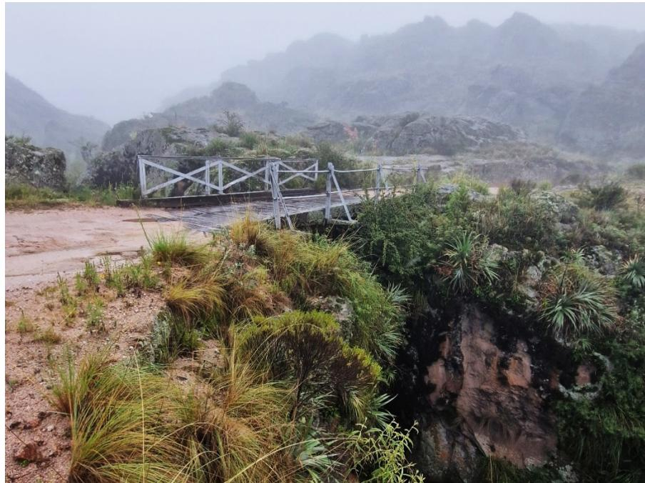
*Figura 16 - Fotografía actual del Puente N° 3 (Prg. Km 5,43). Es el único puente que no presenta formato de puente colgante. Es, a su vez, el puente de menor longitud (8m en total)*
