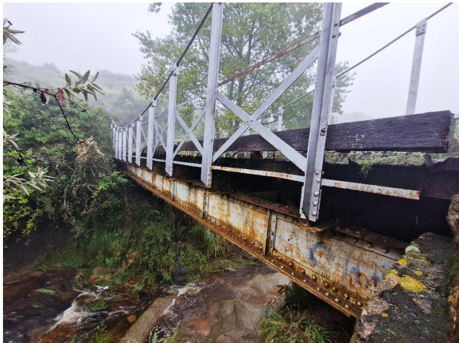
*Figura 15 - Fotografía actual del Puente N° 2 (Prg. Km 5,09). Se aprecia la infraestructura conformada por una viga metálica*
