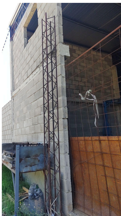
Ingreso sin terminar.
