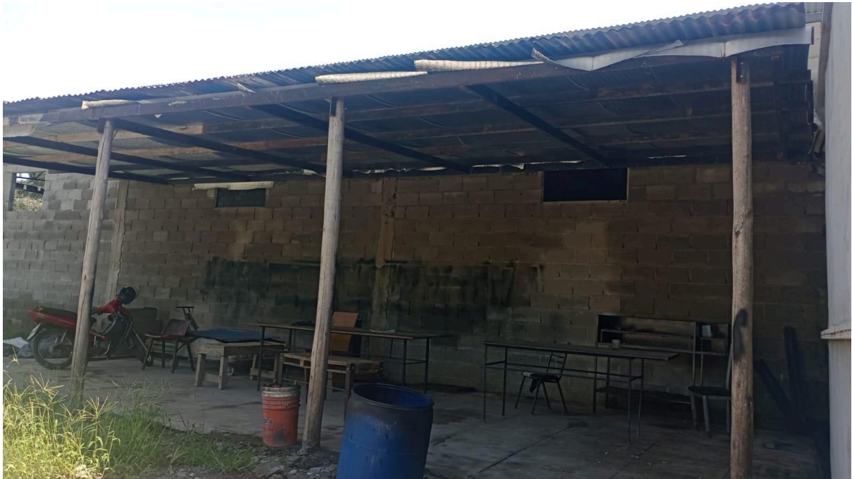
Estado actual del avance de obra de la cocina-comedor.
