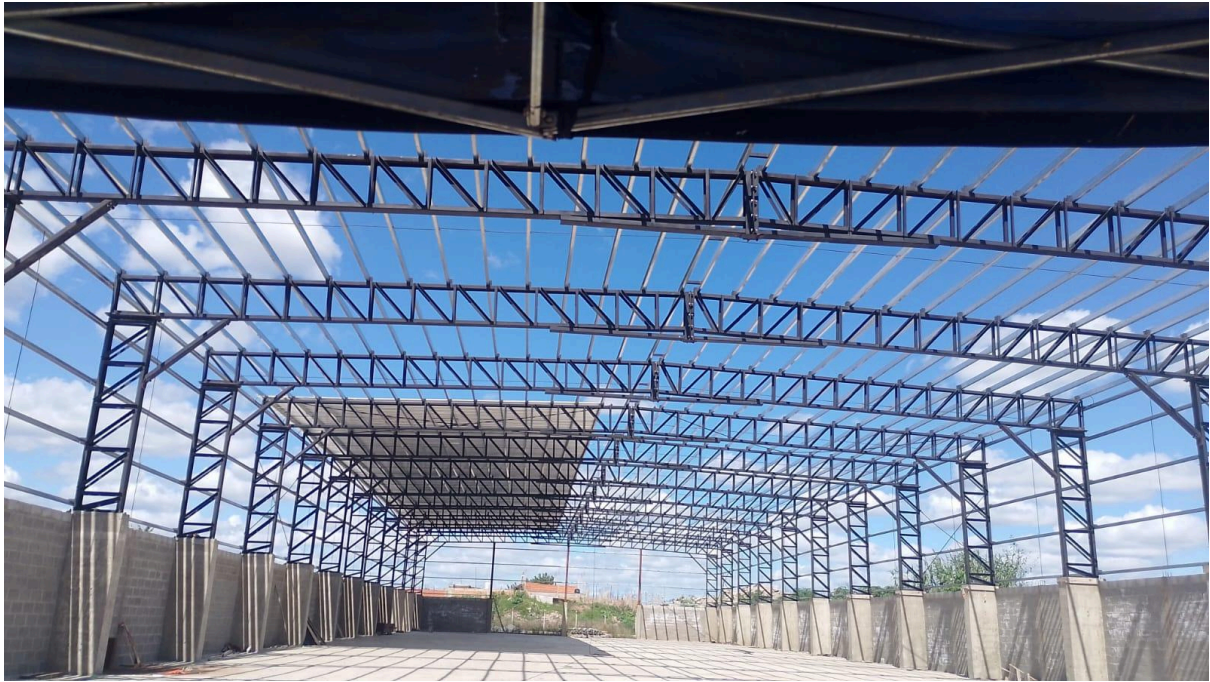
Fotos del trabajo realizado en Matanza correspondientes a la colocación del tinglado.
