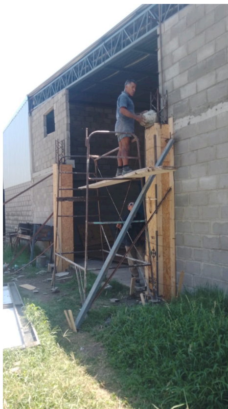
Mejoras para el cerramiento del ingreso.
