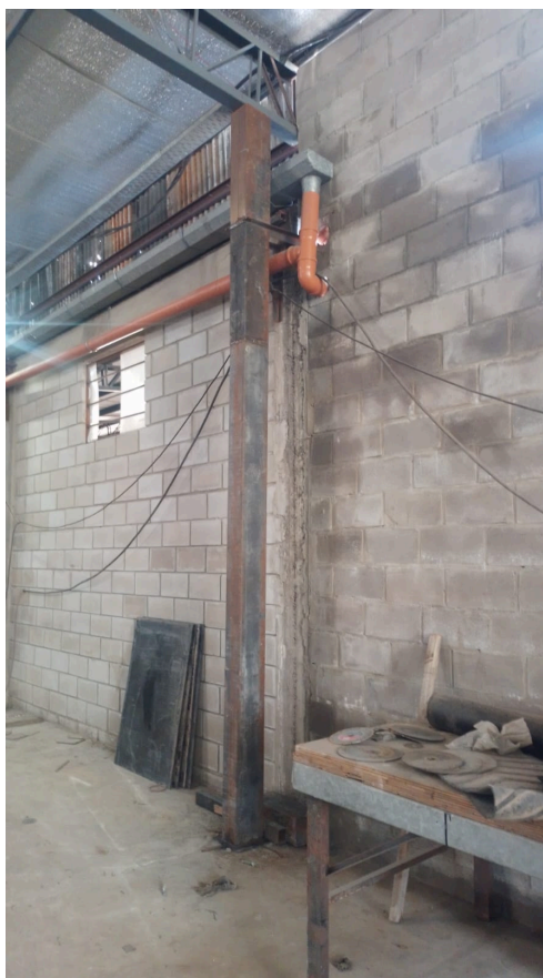
Apoyo reforzado después.
