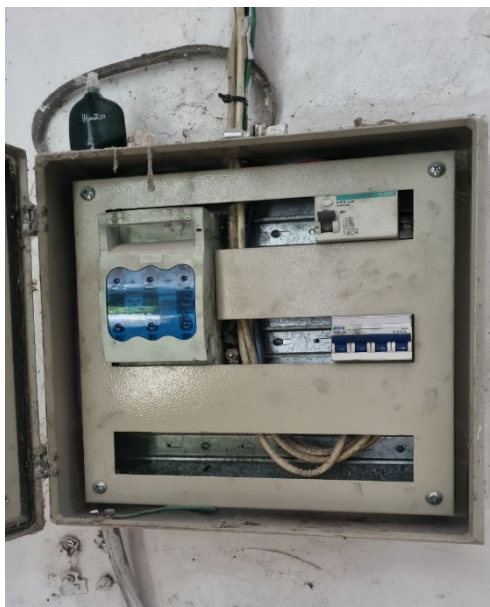
Figura 1.2.1.1 Tablero general de baja tensión (TGBT) ubicado en el depósito que distribuye hacia la línea de producción y el local comercial.
