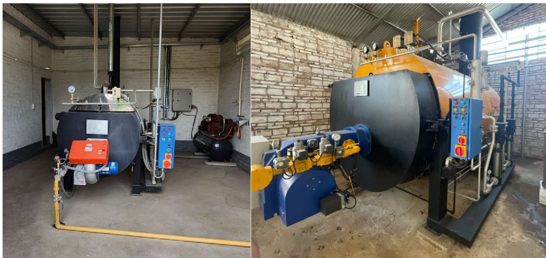
Figura 10 Equipos para generación de vapor basados en calderas alimentadas a GLP pertenecientes a las empresas Proveeduría Integral y FedHec.
