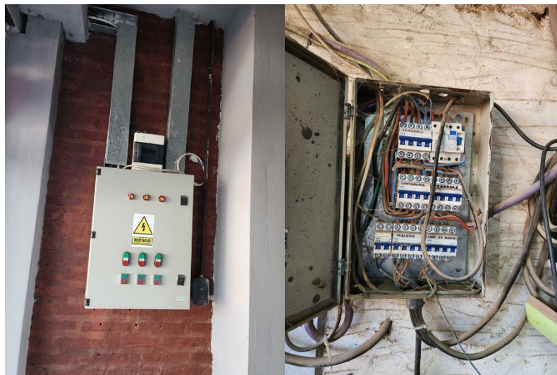
Figura 2.2.1.2 (Izquierda) Tablero principal de la zona de administración y oficinas. (Derecha) Tablero de distribución secundario hacia zona de carpinterías.
