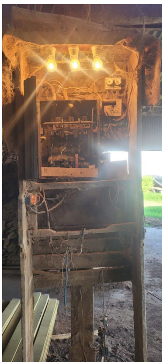
Figura 2.2.1.1 Tablero general de baja tensión (TGBT) ubicado en el patio de máquina que distribuye hacia líneas de producción.
