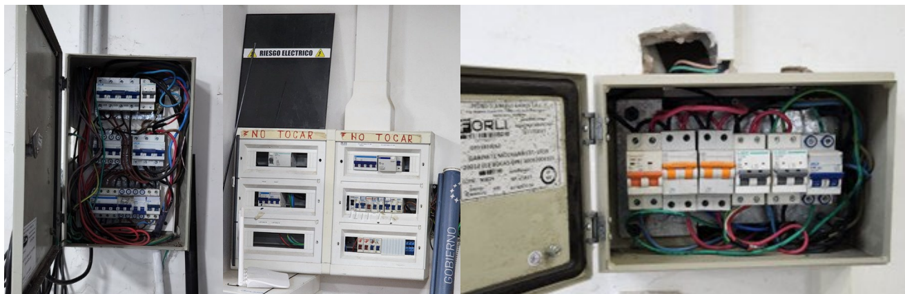
Figura 2.2.1.2 Tableros de distribución secundarios hacia zona de segundo, tercer piso
