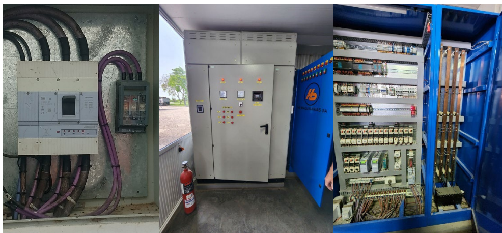
Figura 2.2.1.1 (Izq) Tablero general de baja tensión (TGBT) ubicado en el muro exterior del predio y que distribuye hacia la planta y servicios auxiliares. (Med y Der) Tablero Principal de Baja Tensión ubicado en la oficina de producción.
