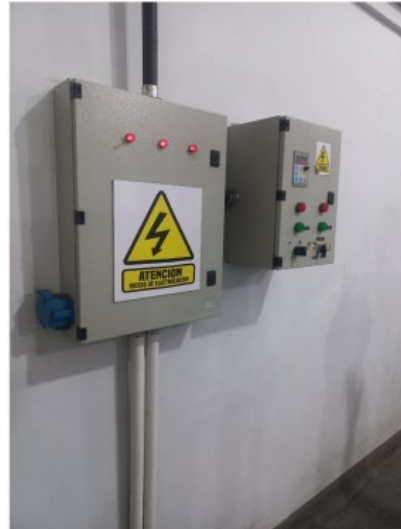
Figura 2.2.1.2 Tablero secundario de la zona de administración, oficinas y hacia zona de envasadora de dulces.
