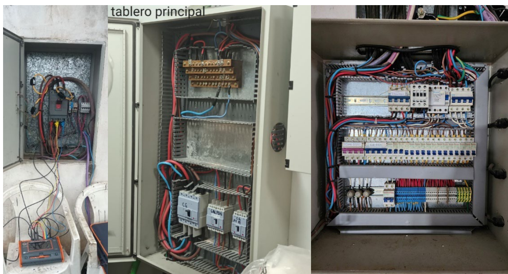
Figura 2.2.1.1 (Izq) Tablero general de baja tensión (TGBT) ubicado en el muro exterior del predio y que distribuye hacia la planta y servicios auxiliares. (Med y Der) Tablero Principal de Baja Tensión (TPBT) ubicado en la oficina de producción.
