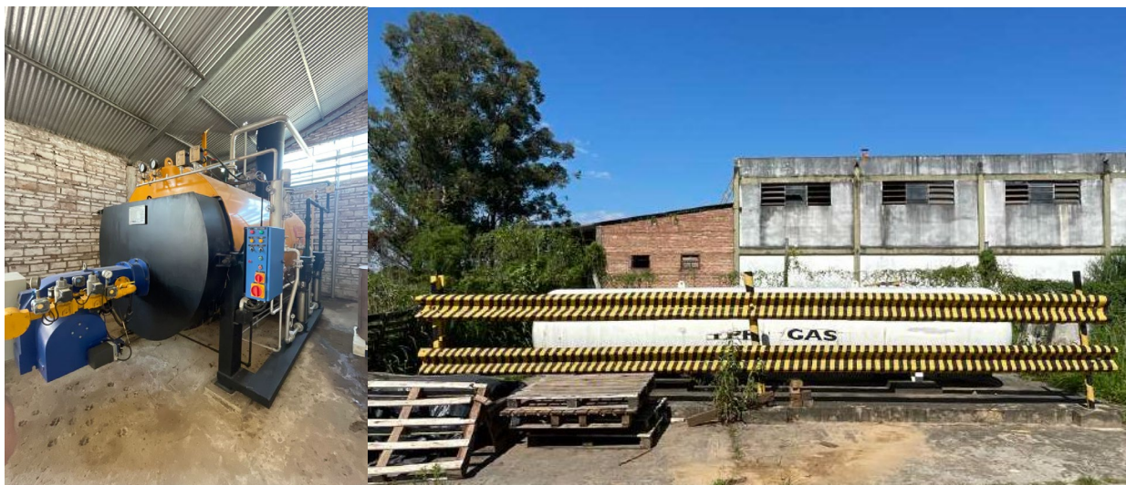
Figura 2.2.1.5 Patio de caldera donde se encuentran emplazadas la caldera de vapor BOILERMAX modelo HL3R200 y el zepelín de gas licuado para alimentar a la misma.
