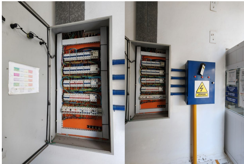
Figura 2.2.1.1 Tablero general de baja tensión (TGBT) ubicado en el patio de máquina que distribuye hacia las líneas de producción, el depósito y las oficinas.
