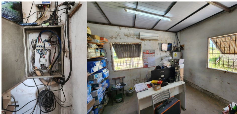
Figura 1.2.1.1 Tablero general de baja tensión (TGBT) ubicado en la oficina que distribuye hacia todas las líneas y el depósito.
