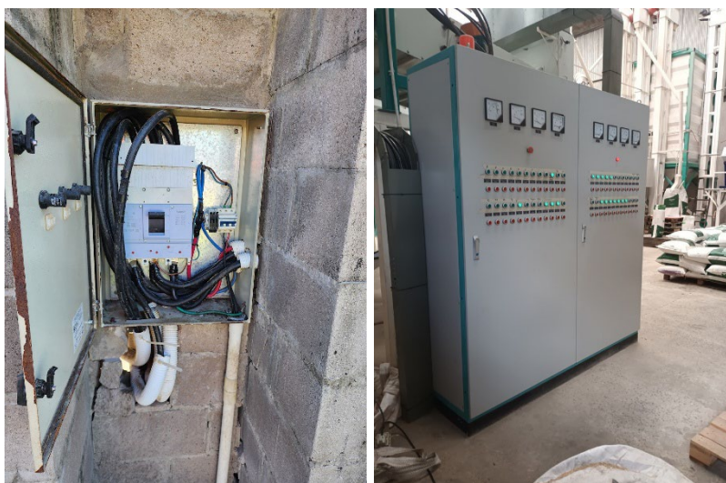
Figura 2.2.1.1 (izq) Tablero general de baja tensión (TGBT) ubicado en el muro que delimita el predio de la empresa y distribuye hacia la línea de producción y el depósito. (der) Tablero Distribución Baja Tensión Línea de producción ubicado dentro de la zona de producción.
