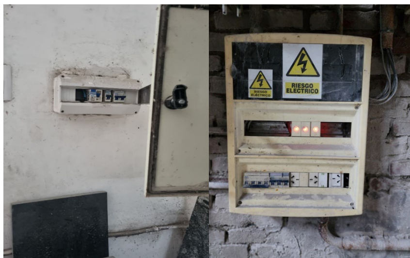
Figura 1.2.1.2 (Izquierda) Tablero principal de la zona de administración y oficinas. (Derecha) Tablero de distribución secundario hacia zona de producción.
