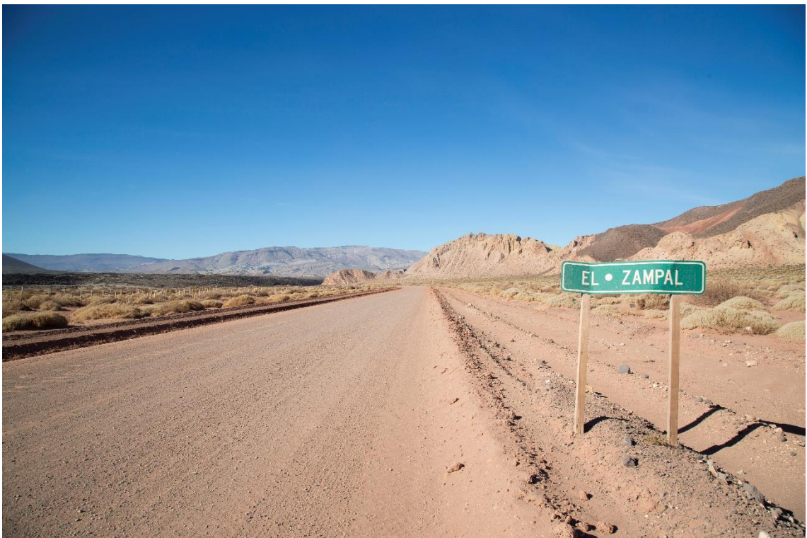
Fotografía 24 – Progresiva 19+500 – Vista de la calzada a la altura de El Zampal
