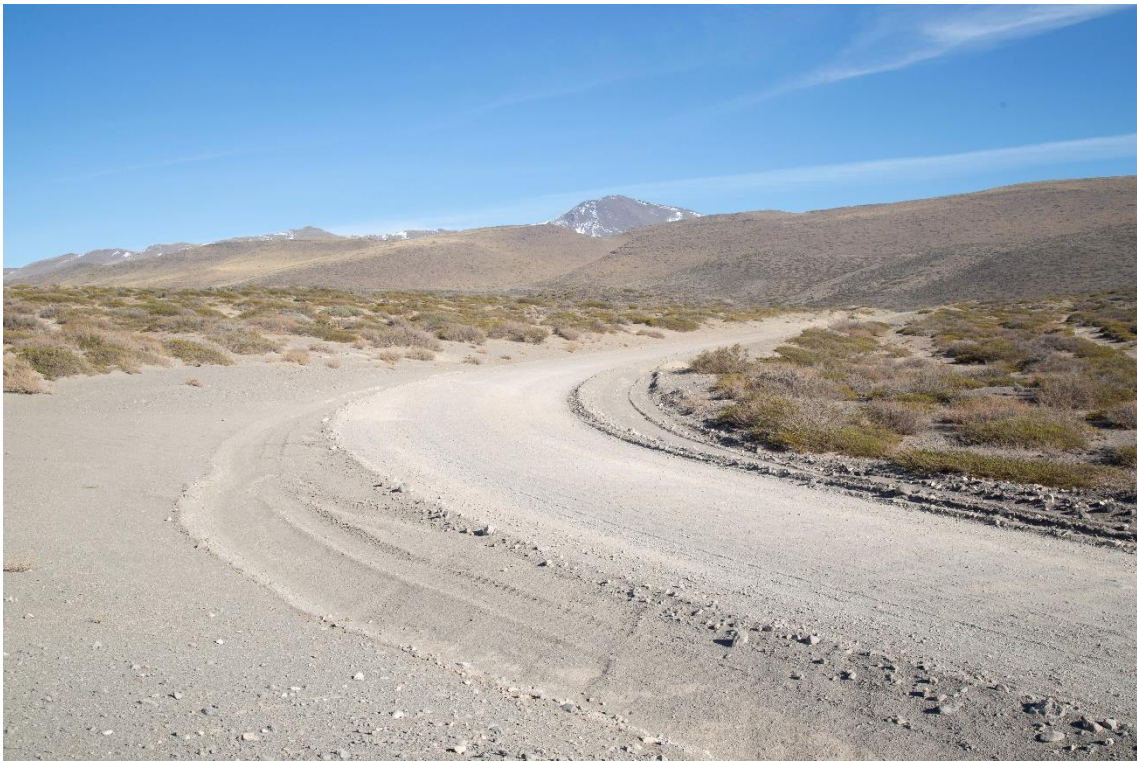
Fotografía 4. Progresiva 0+500 – Vista de la traza
