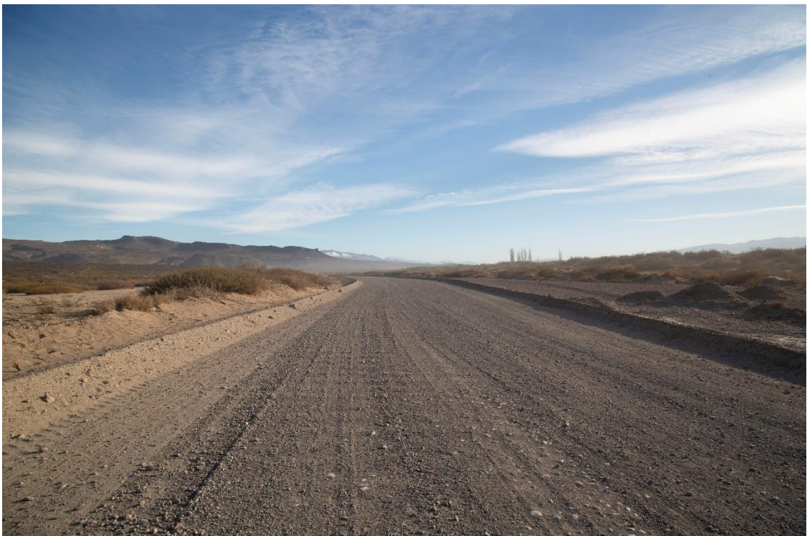
Fotografía 8 – Progresiva 17+700 – Vista de la calzada enripiada
