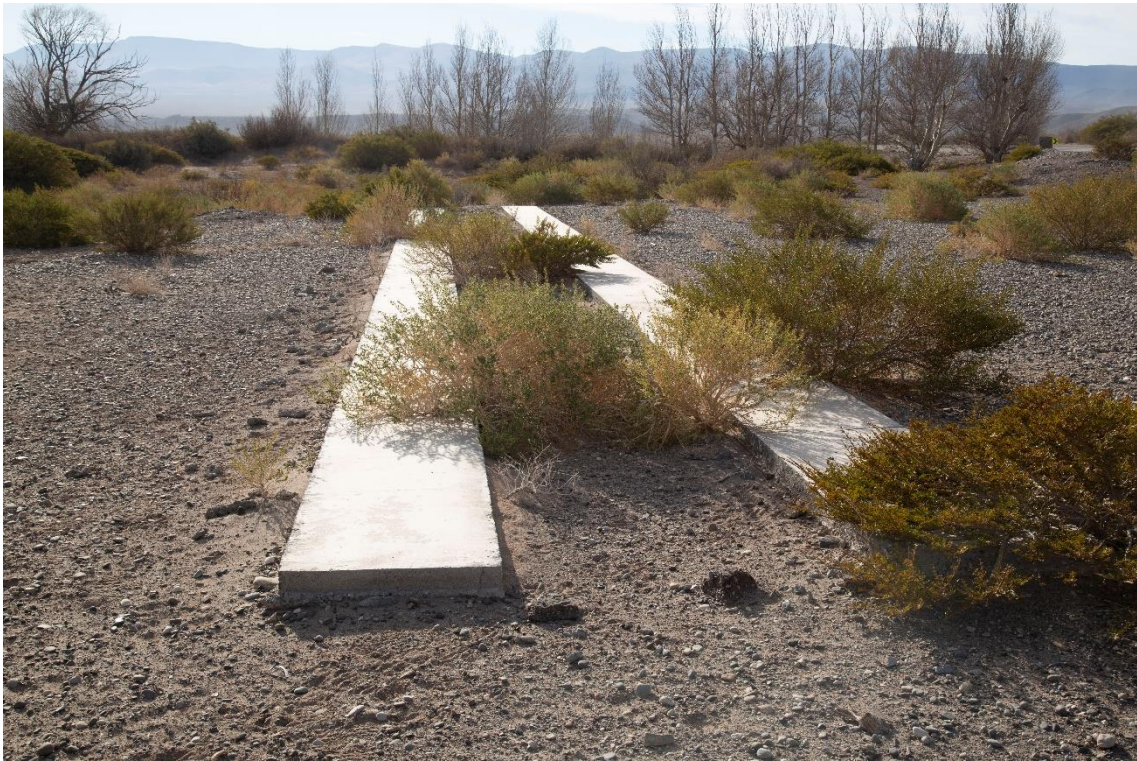
Fotografía 24 - Progresiva Km 24+000 – Cama para la fabricación de las vigas.
