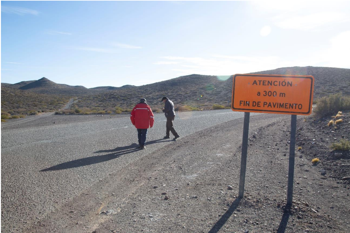
Fotografía 1. Progresiva 0+000 Inicio de la Sección 1
