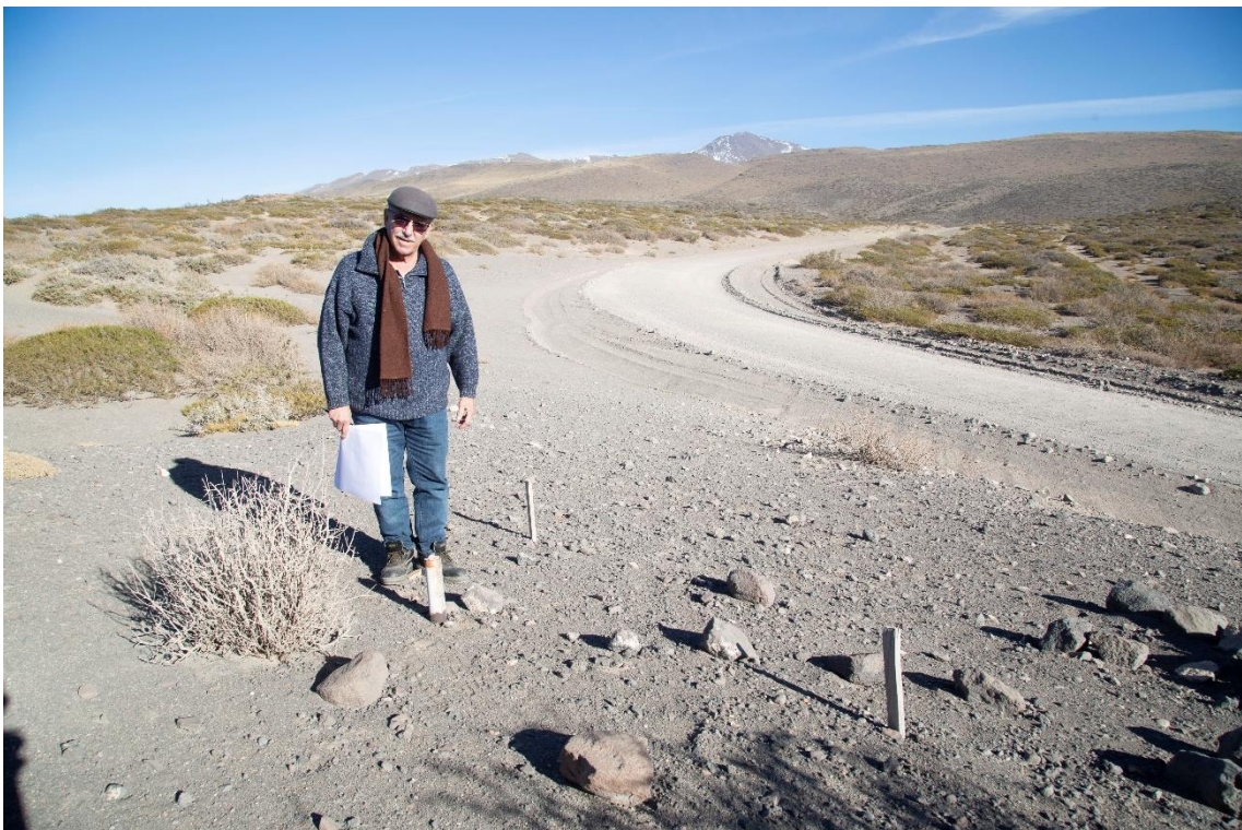
Fotografía 6. Progresiva 0+500 – Vista de las estacas del vértice de la primera curva
