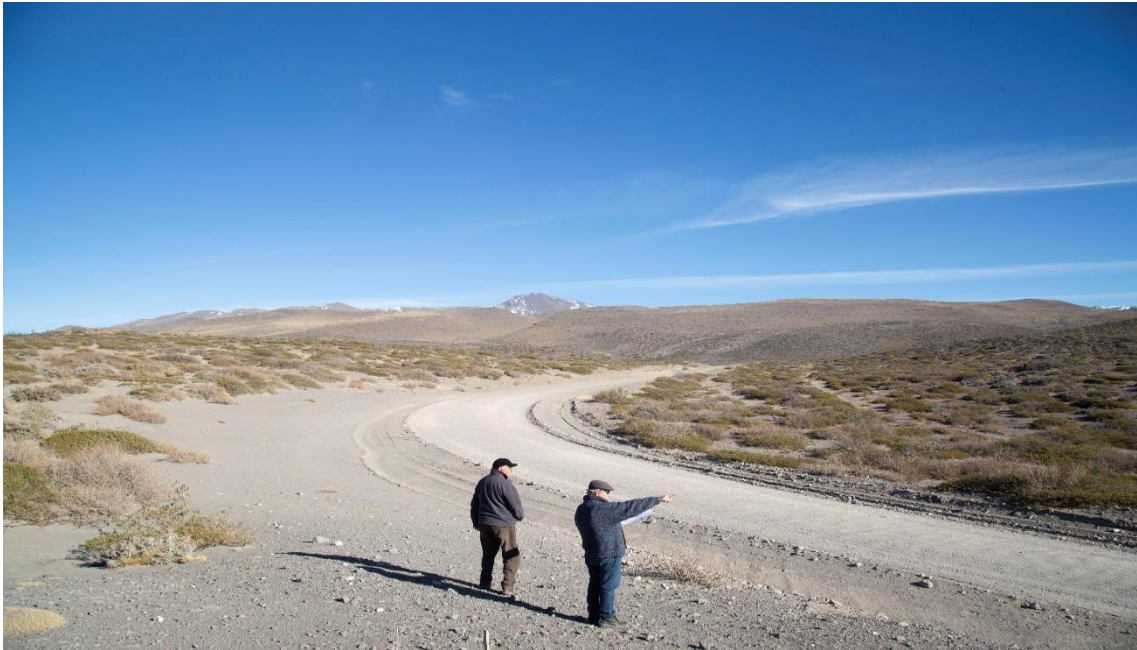
Fotografía 7. Progresiva 0+500 – Vista de la traza de la primera curva
