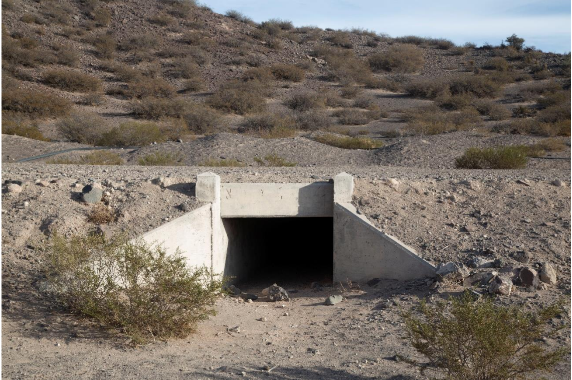
Fotografía 11 – Progresiva 21+300 – Alcantarilla construida según el Proyecto Ejecutivo
