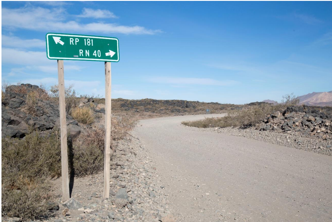
Fotografía 31 – Progresiva 48+000 – Otra vista de la Intersección con RP 181, Final de la Sección 1
