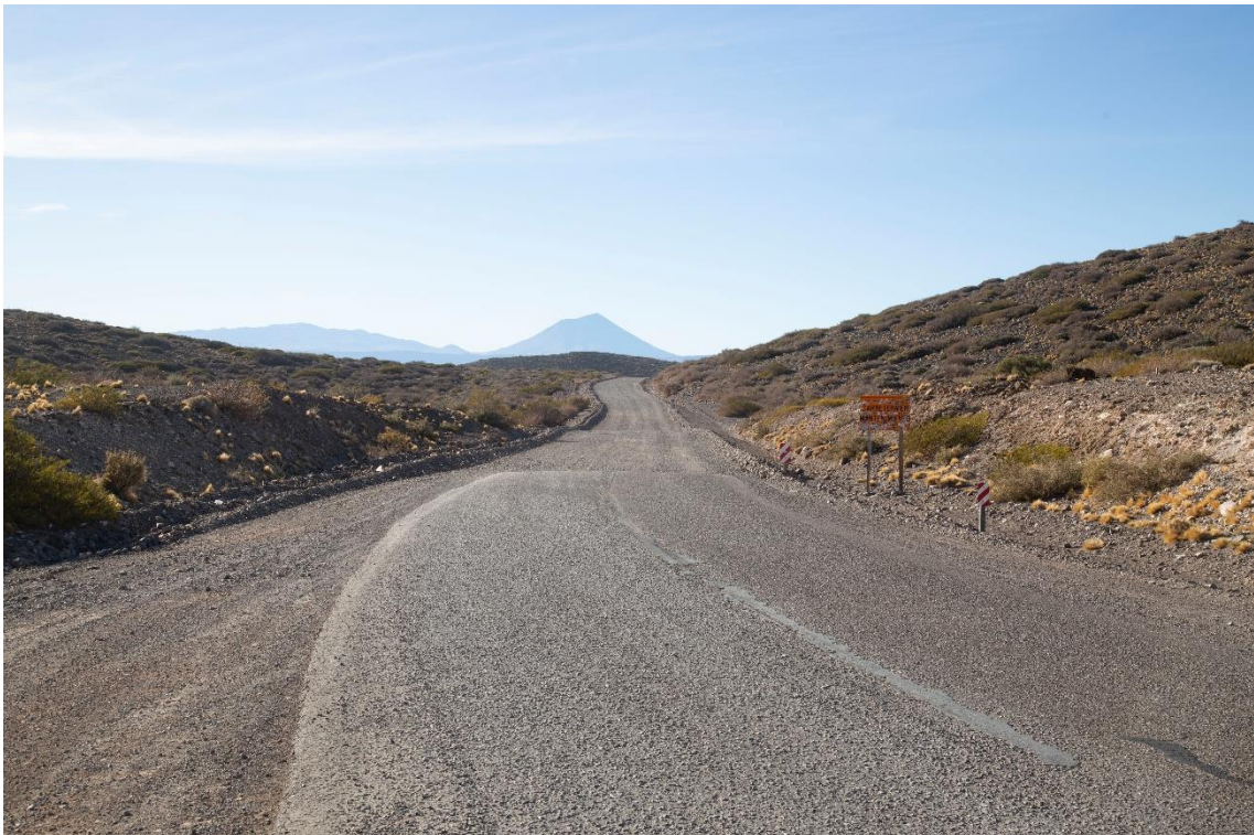
Fotografía 2. Progresiva 0+000 Inicio de la Sección 1
