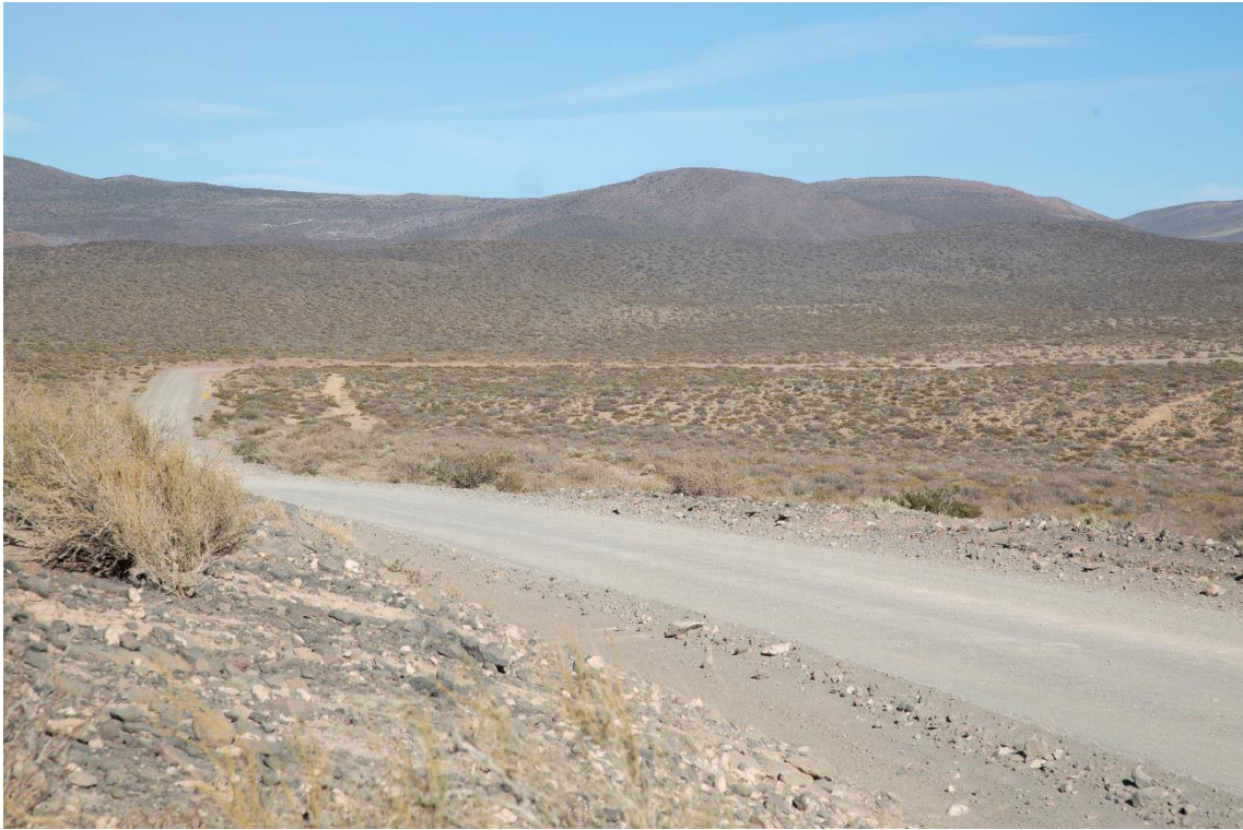
Fotografía 13. Progresiva 6+000 – Otra vista de la traza
