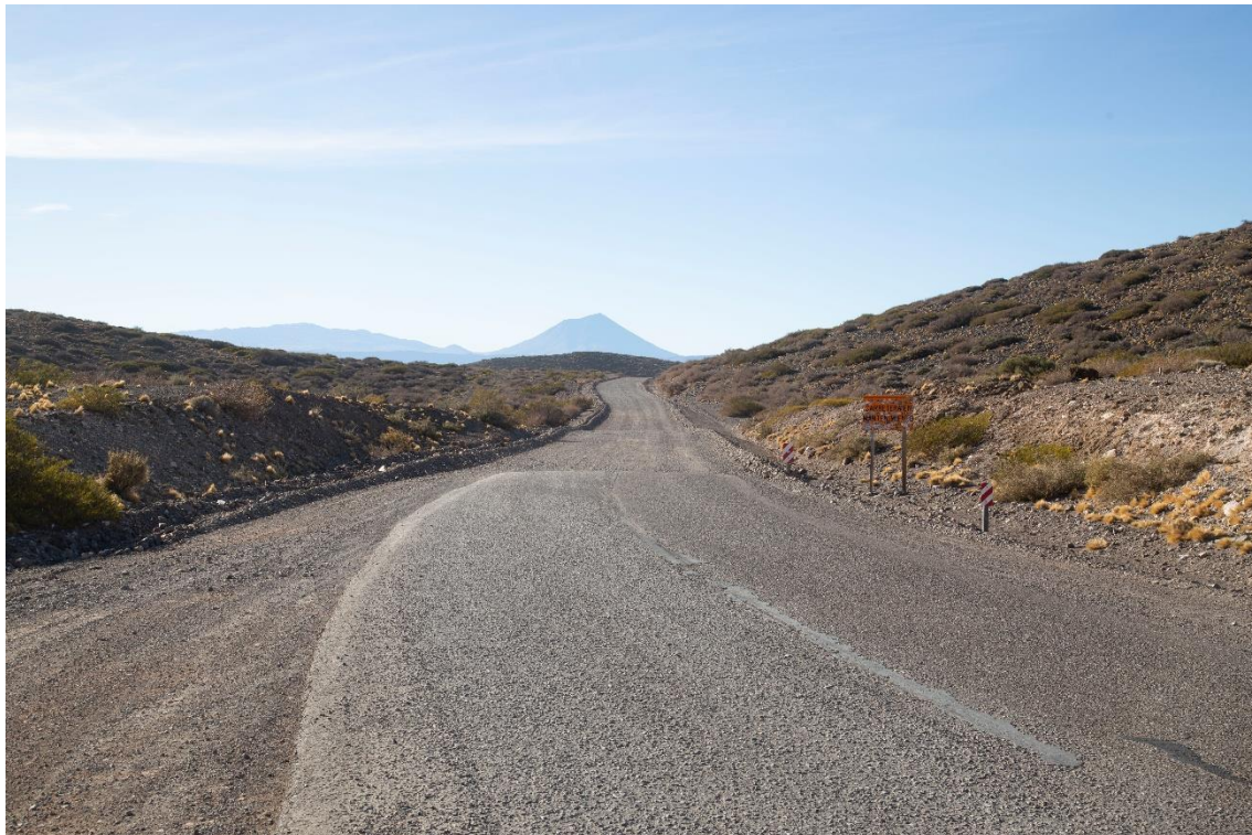
Fotografía 2. Progresiva 0+000 Inicio de la Sección 1
