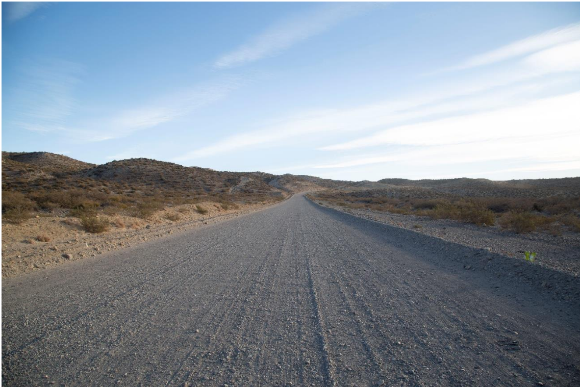
Fotografía 1 – Progresiva 12+500 – Vista de la calzada enripiada
