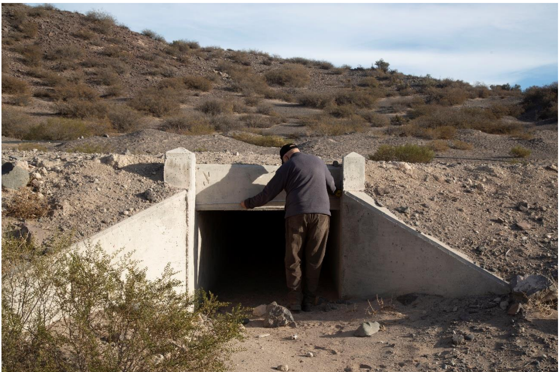
Fotografía 12 - Progresiva 21+300 – Alcantarilla construida según el Proyecto Ejecutivo
