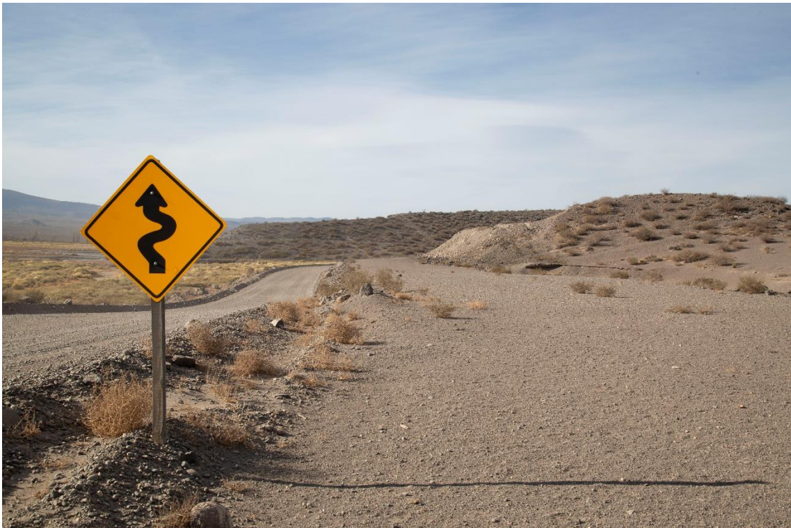
Fotografía 29 – Progresiva 28+800 – Inicio variante para rectificar traza muy sinuosa.
