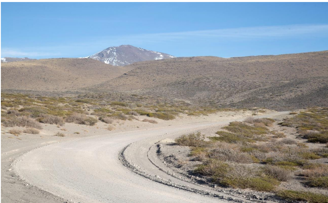
Fotografía 8. Progresiva 0+500 – Otra vista de la traza de la primera curva
