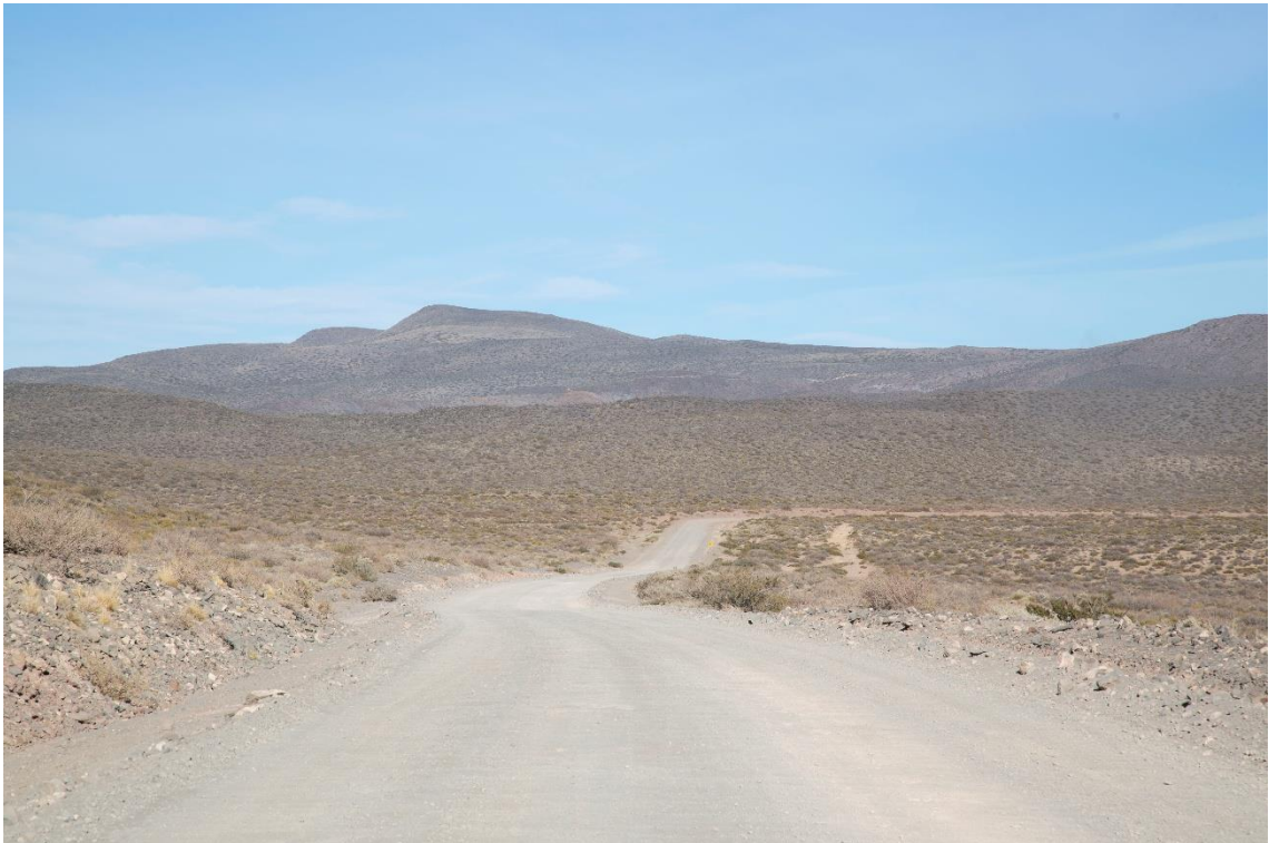
Fotografía 12. Progresiva 6+000 – Vista de la traza con pendiente importante
