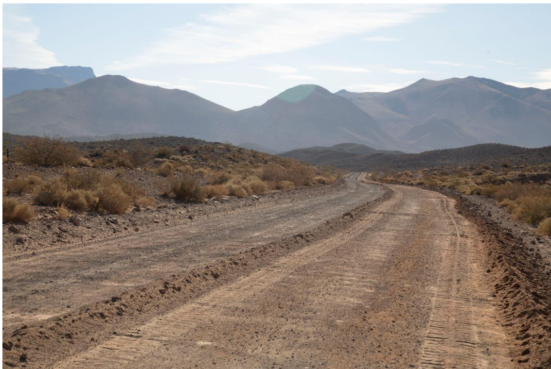
Fotografía 18 - Progresiva 9+150 – Otra vista de la calzada con el trabajo de la motoniveladora
