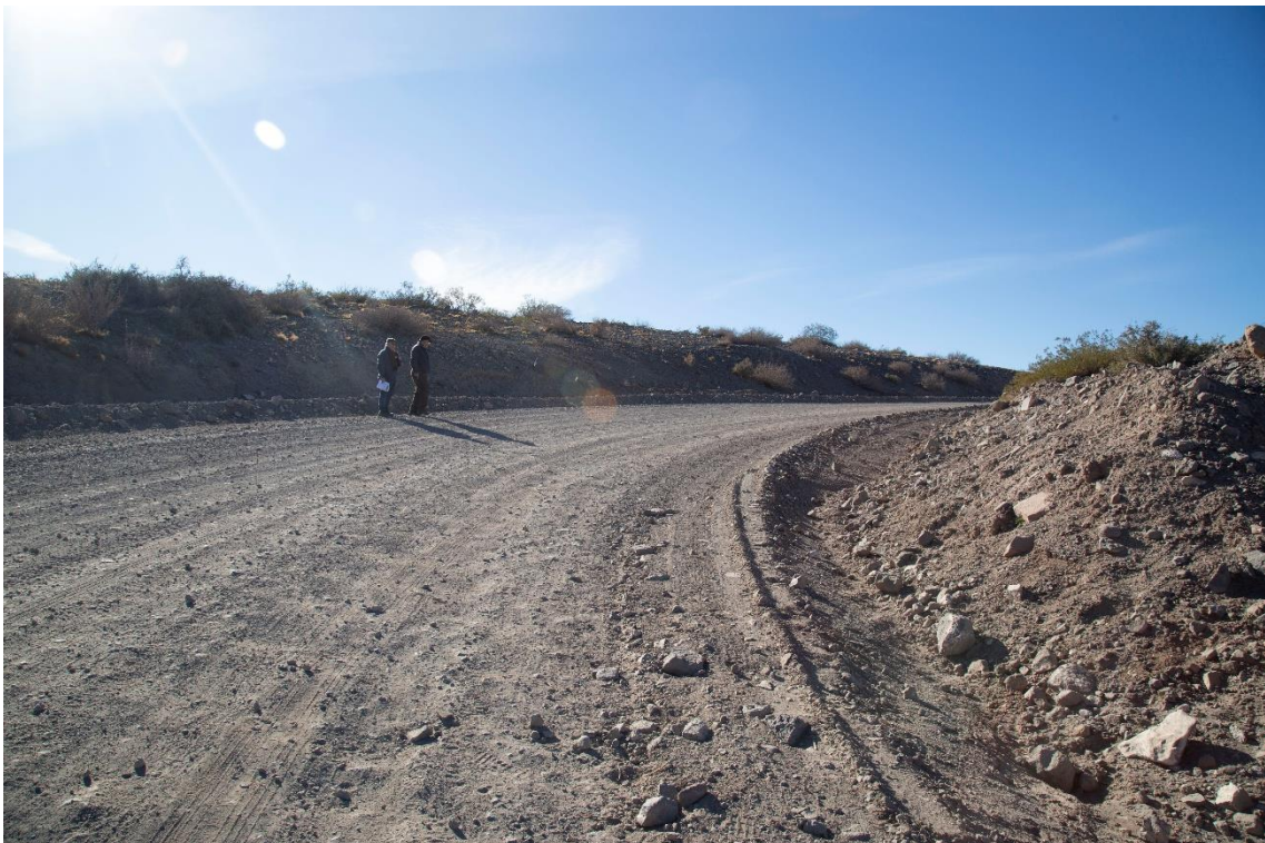
Fotografía 10 - Progresiva 2+000 – Otra vista de la curva que se propone rectificar
