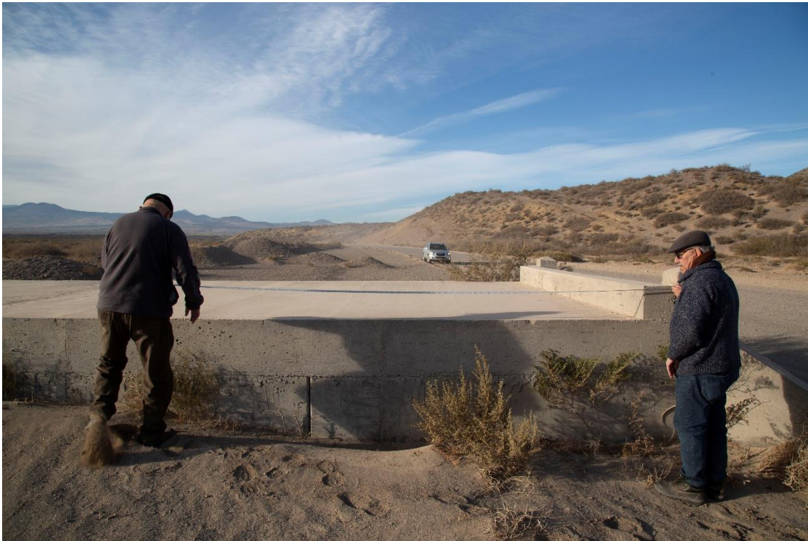
Fotografía 5 – Progresiva 17+700 – Alcantarilla de hormigón en la Variante prevista en el Proyecto Ejecutivo. Obra paralizada
