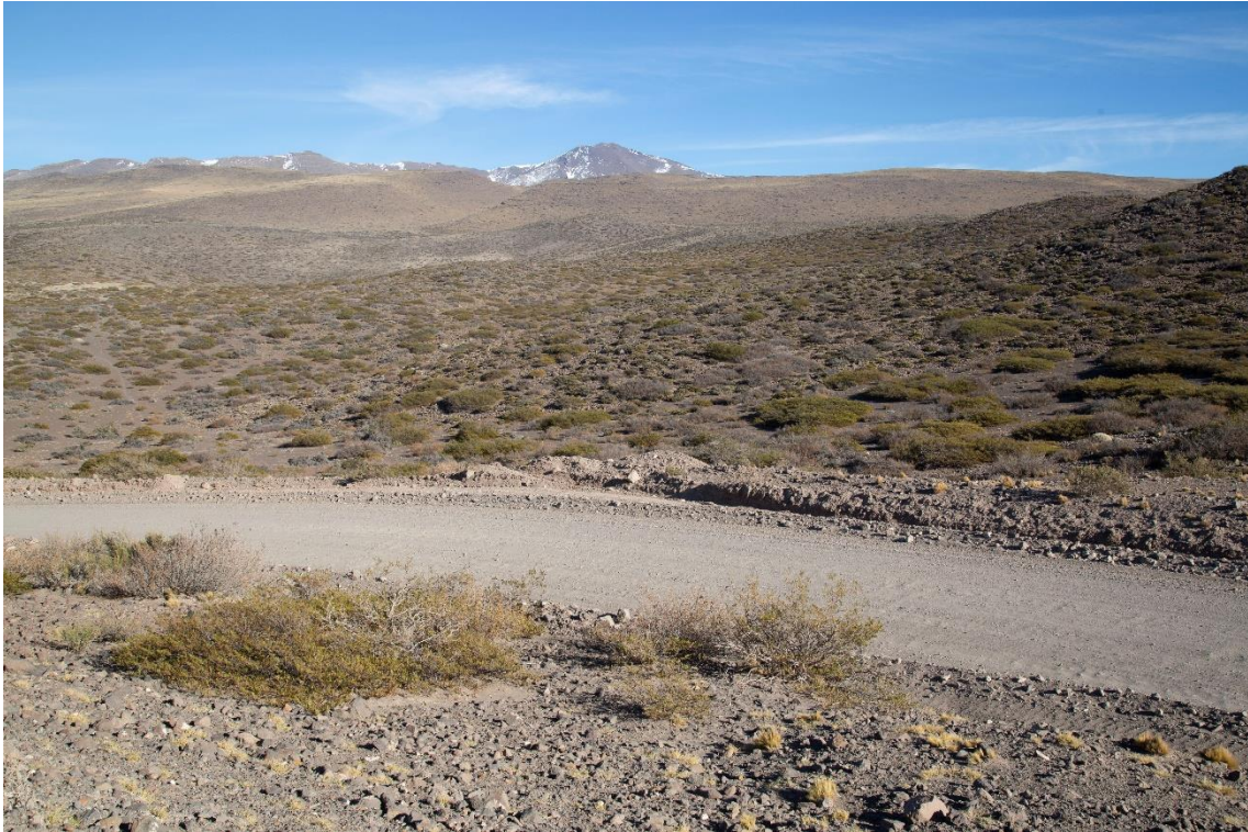
Fotografía 9. Progresiva 2+000 – Vista de la curva que se propone rectificar
