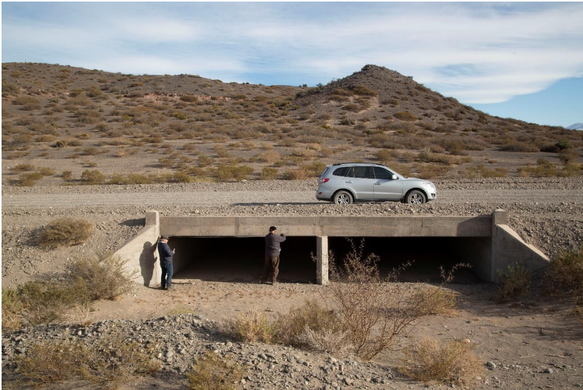
Fotografía 18 – Progresiva 23+000 – Vista alcantarilla nueva de hormigón de grandes dimensiones sobre traza existente.
