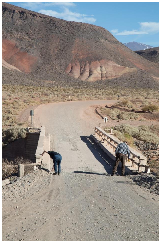
Fotografía 26 – Progresiva 20+100 – Midiendo el Ancho de calzada del puente. Tiene 3,70 m
