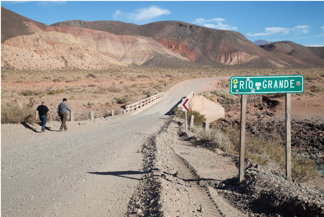
Fotografía 25 – Progresiva 20+000 – Vista del puente sobre el Río Grande en El Zampal
