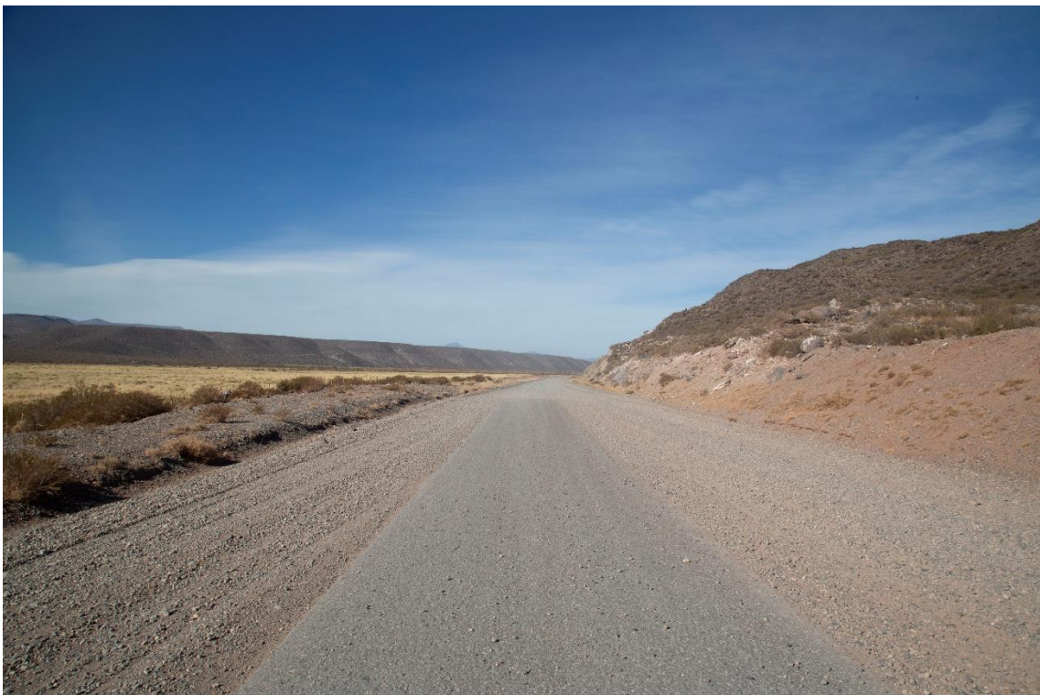
Fotografía 33 – Progresiva 45+800 – Vista de la traza próxima al comienzo del pavimento.
