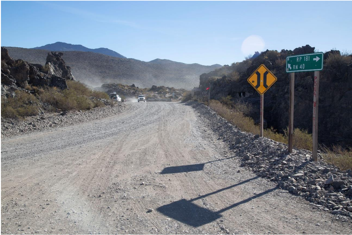
Fotografía 33 – Progresiva 48+100 – Vista de la traza después de la intersección con la RP 181. Final de la Sección 1
