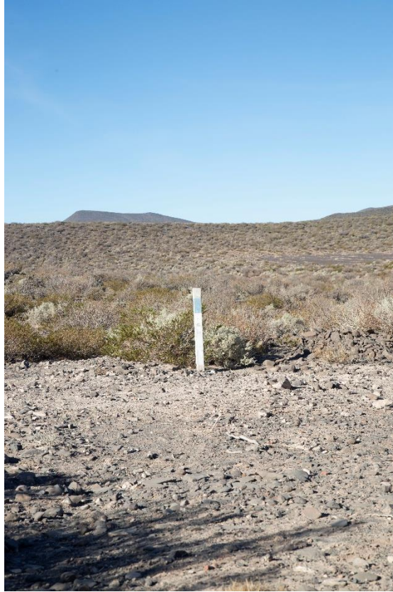
Fotografía 11. Progresiva 2+000 – Poste indicativo de la presencia de fibra óptica. Está a lo largo de toda la Sección
