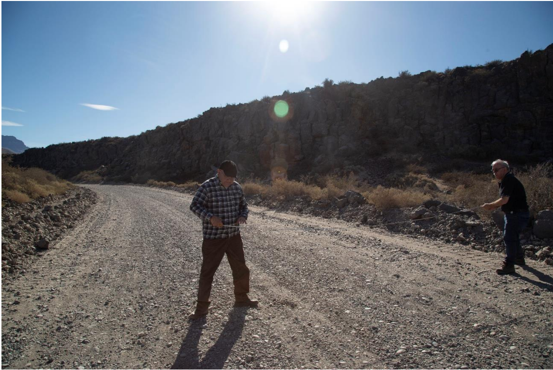
Fotografía 27 – Progresiva 26+300 – Midiendo el ancho de calzada. Tiene 10 m
