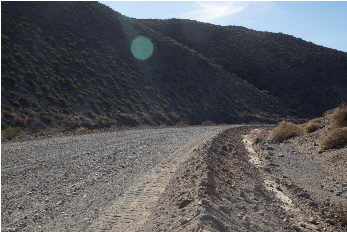
Fotografía 19 – Progresiva 13+900 – Vista de la calzada. Curva con pendiente
