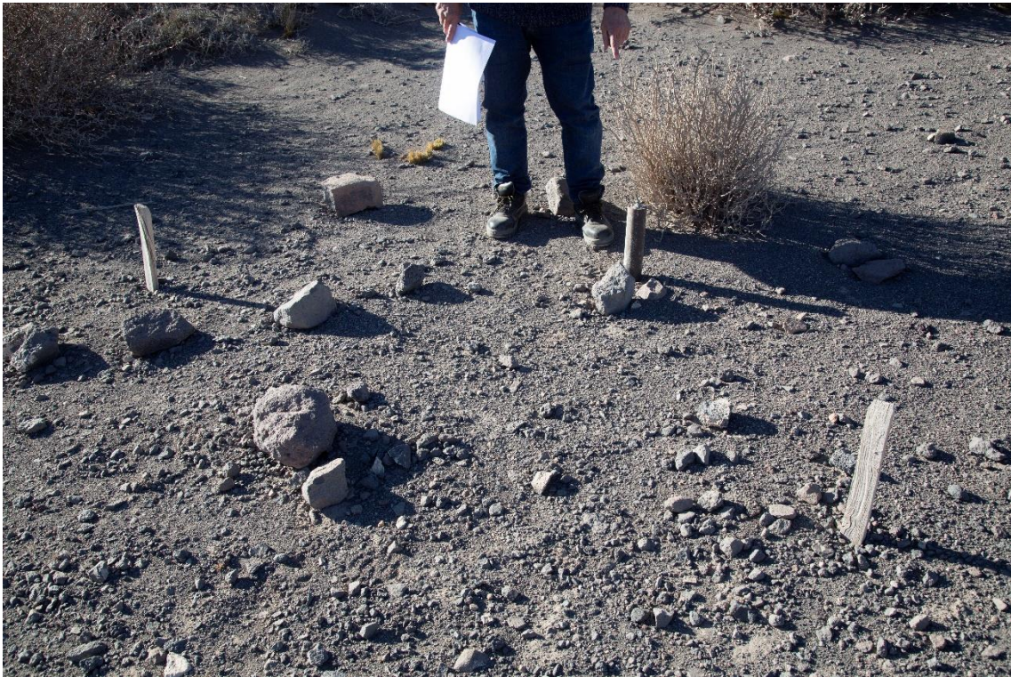
Fotografía 5. Progresiva 0+500 – Vista de las estacas del vértice de la primera curva
