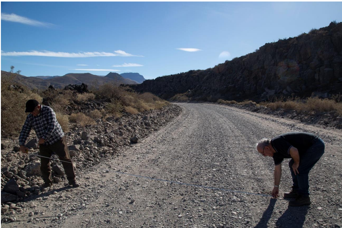
Fotografía 28 – Progresiva 26+300 – Midiendo el ancho de calzada. Tiene 10 m
