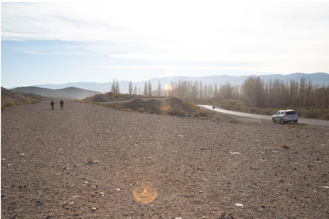
Fotografía 13 – Progresiva 21+400 - Vista de terraplén sur de Acceso al Puente sobre canal de riego y de la traza actual. Obra paralizada
