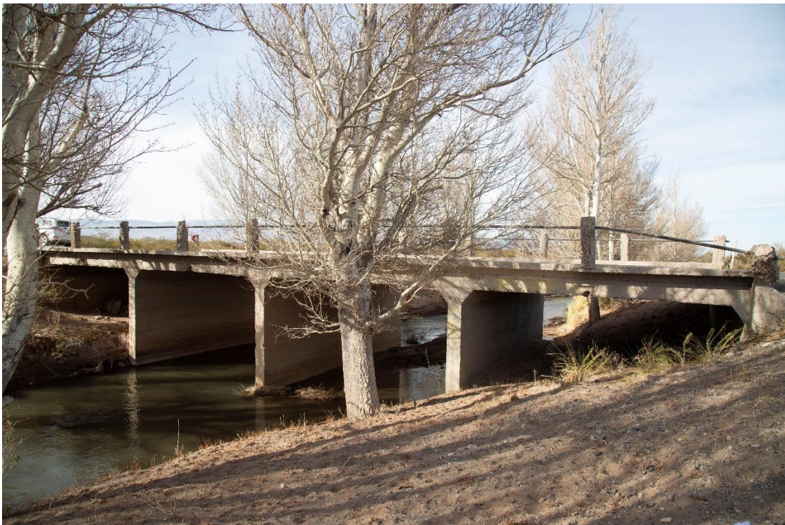
Fotografía 25 – Progresiva Km 24+000 – Puente actual sobre canal de riego en regular estado.
