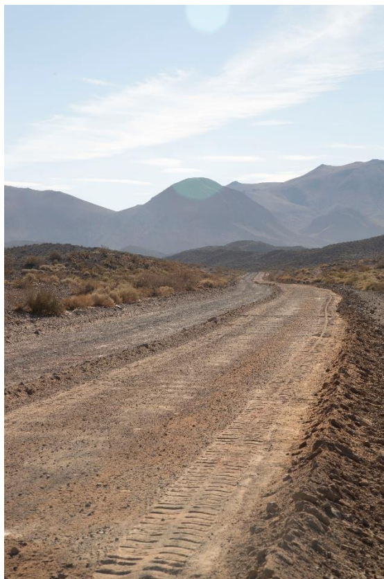
Fotografía17 – Progresiva 9+150 – Vista de la calzada con el trabajo de la motoniveladora
