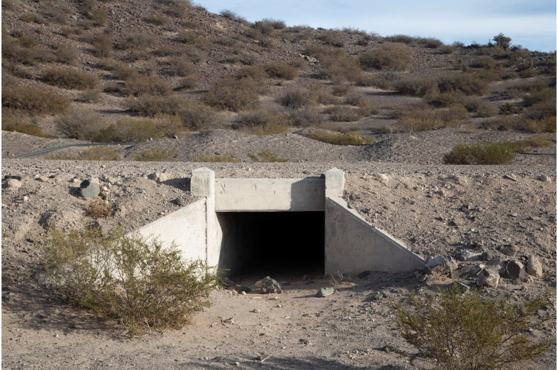
Fotografía 11 – Progresiva 21+300 – Alcantarilla construida según el Proyecto Ejecutivo
