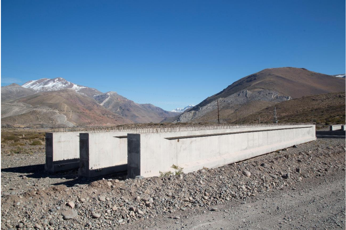
Fotografía 46 – Progresiva 72+000 – Otra vista de las vigas del lado norte para el puente sobre el Arroyo Agua Botada. Obra paralizada.
