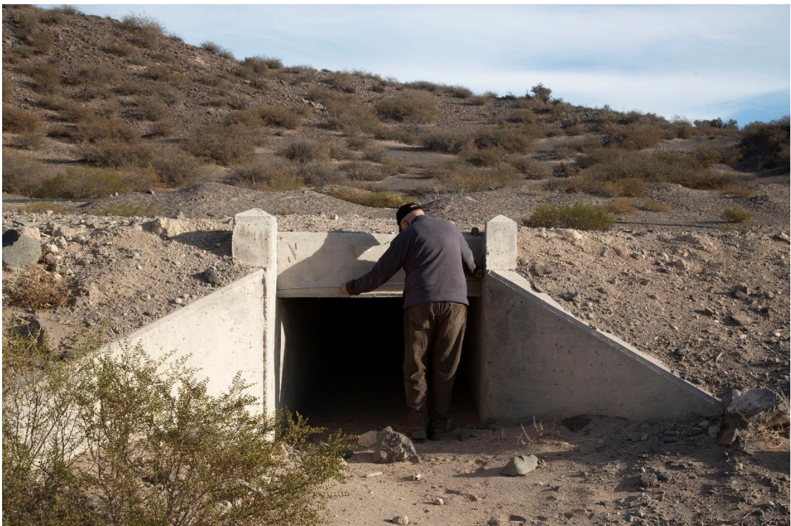
Fotografía 12 - Progresiva 21+300 – Alcantarilla construida según el Proyecto Ejecutivo
