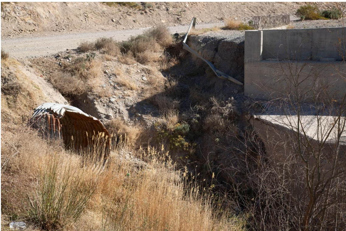
Fotografía 41 – Progresiva 68+800 – El puente a medio construir reemplazará a la alcantarilla en mal estado que se observa en la fotografía.
