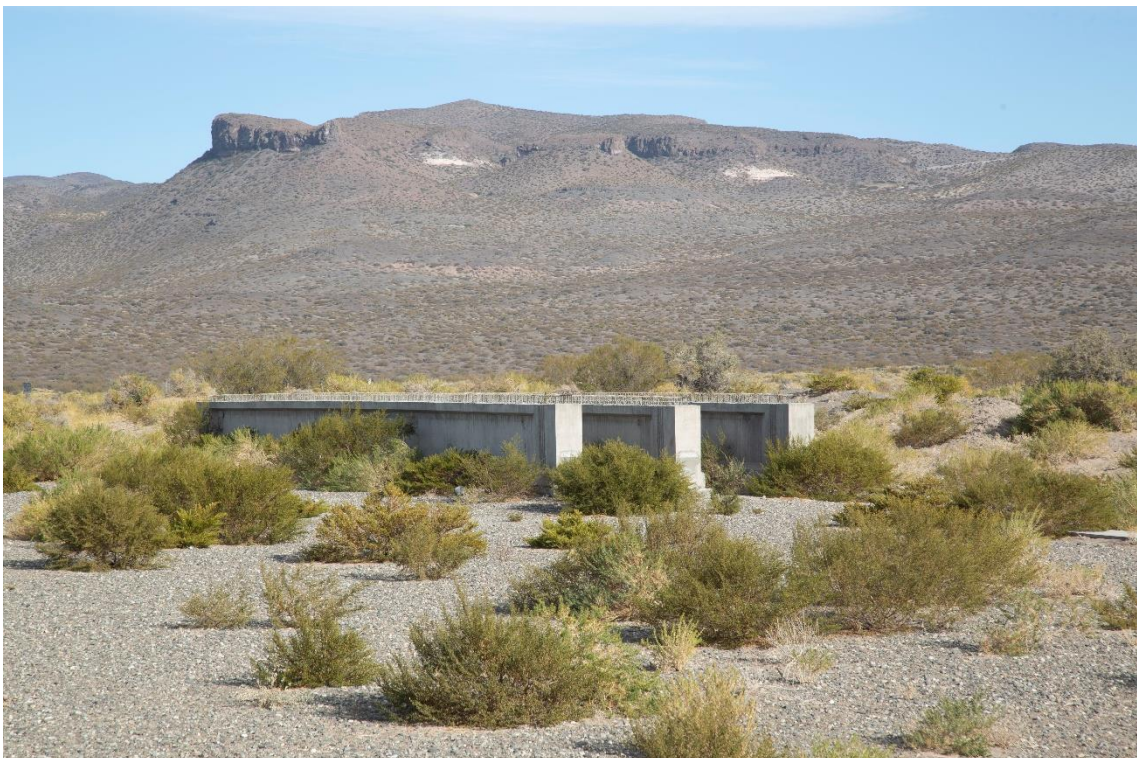
Fotografía 19 – Progresiva 24+000 – Vista de 3 vigas construida para el puente sobre el canal de riego. Obra paralizada,
