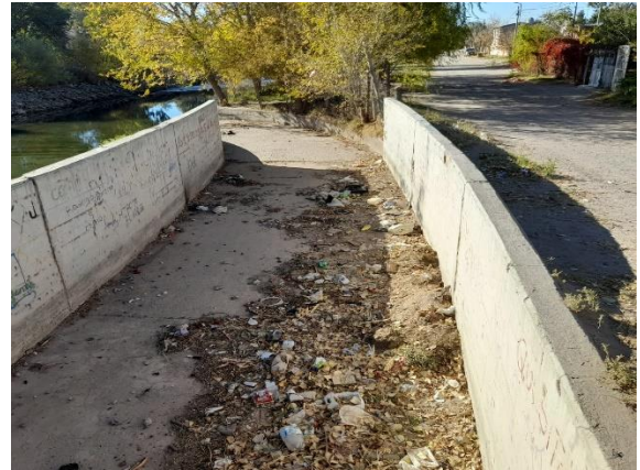
Fotografía N° 12: Vistas del vertedero lateral (bypass) ubicado sobre la margen Sur del salto hidráulico. Inicio (Izq.) y fin del mismo (Der.) (ambas fotos tienen orientación Este).
