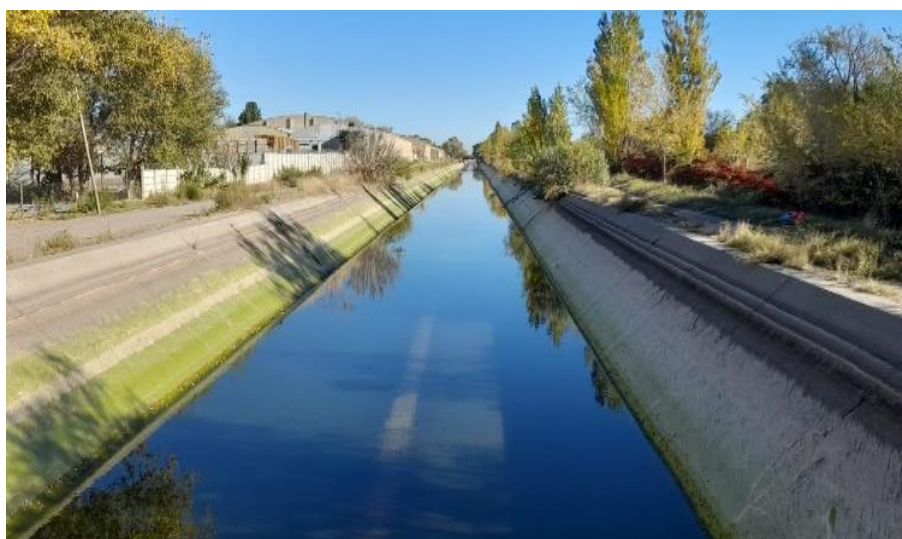
Fotografía N° 24: Canal Principal de Riego a la altura de la ciudad de Allen.
