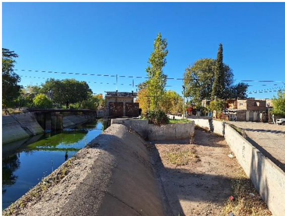
Fotografía N° 10: Vistas del vertedero lateral (bypass) ubicado sobre la margen Sur del salto hidráulico. Inicio (Izq.) y fin del mismo (Der.) (ambas fotos tienen orientación Este).
