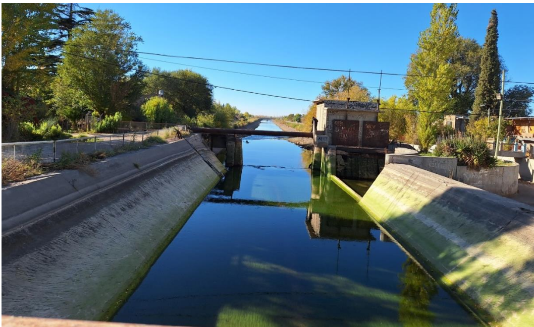
Fotografía N° 8: Vista al Este del Canal Principal de Riego (progresiva km 47,867).
