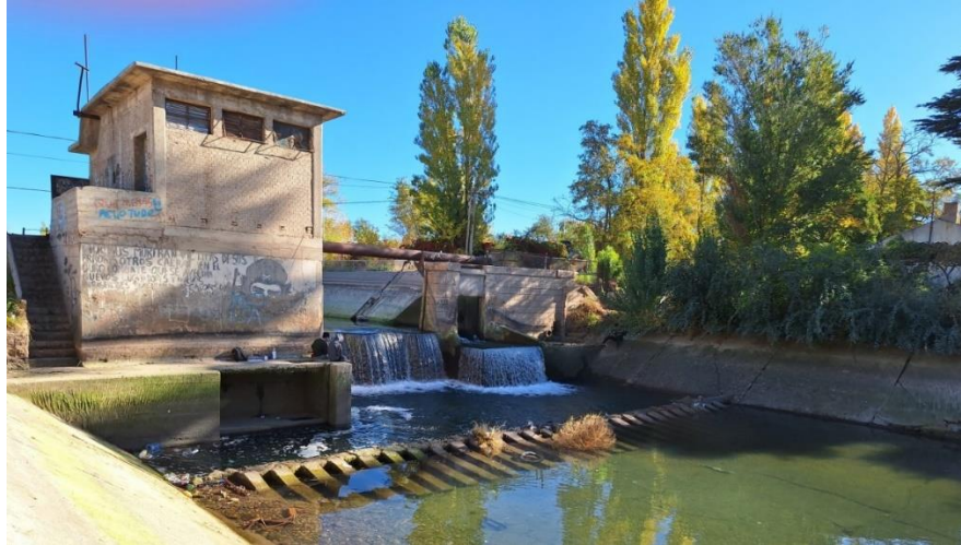
Fotografía N° 9: Vista al Oeste Canal Principal de Riego (progresiva km 47,867).
