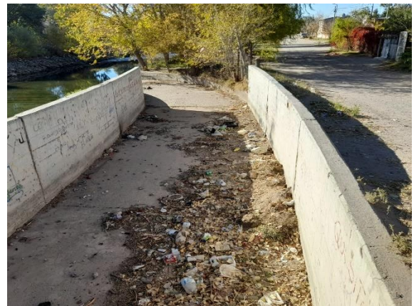
Fotografía N° 10: Vistas del vertedero lateral (bypass) ubicado sobre la margen Sur del salto hidráulico. Inicio (Izq.) y fin del mismo (Der.) (ambas fotos tienen orientación Este).
