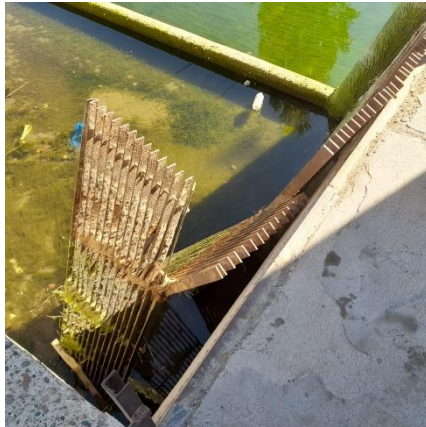
Fotografía N° 13: Rejas ubicada sobre la margen Sur del salto hidráulico. Inicio (Izq.) y caño que atraviesa el canal (Der.) (orientación Norte).
