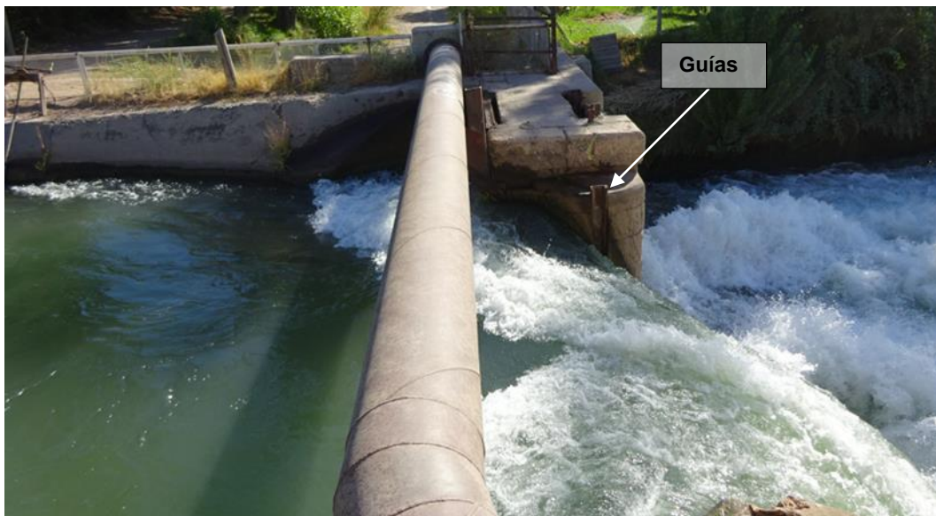
Fotografía N° 23: Vista del salto con guías para la colocación de almenas.
