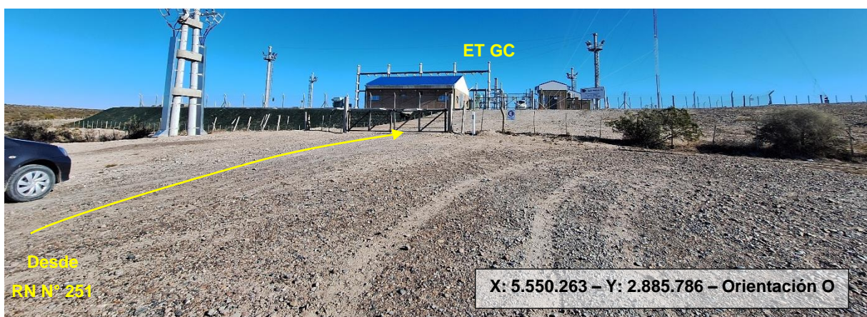
Fotografía N° 2: Camino de acceso a la ET GC.
