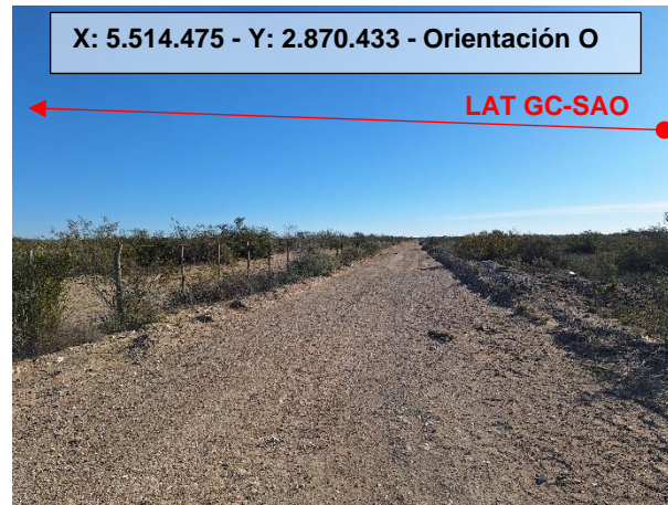
Fotografía N° 14: Punto 7 – Interferencia con camino rural (Progresiva 38,939 km).
