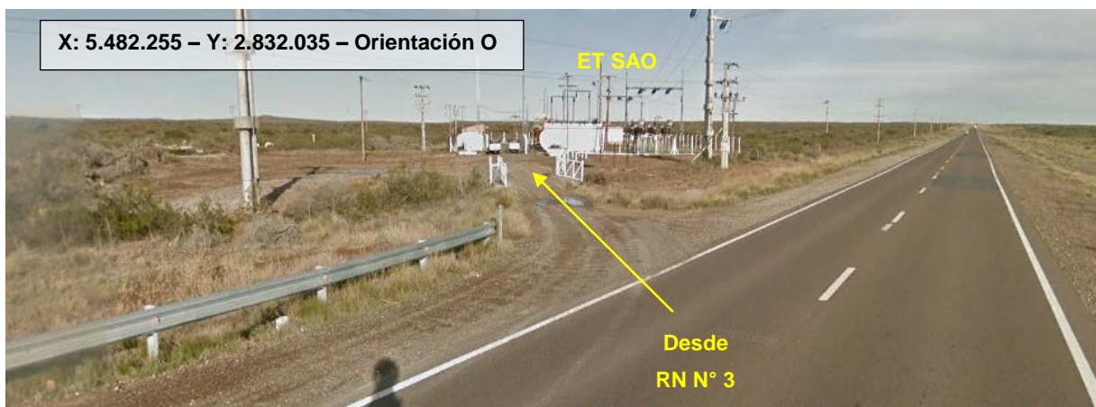
Fotografía N° 4: Camino de acceso a la ET SAO.
