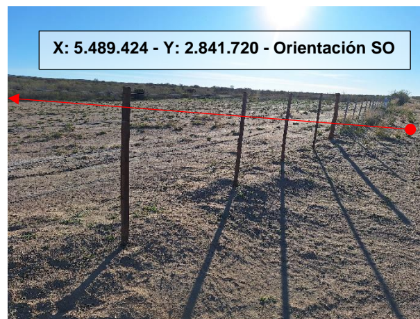
Fotografía N° 24: Punto 12 – Interferencia con alambrado rural (Progresiva 78,861 km).
