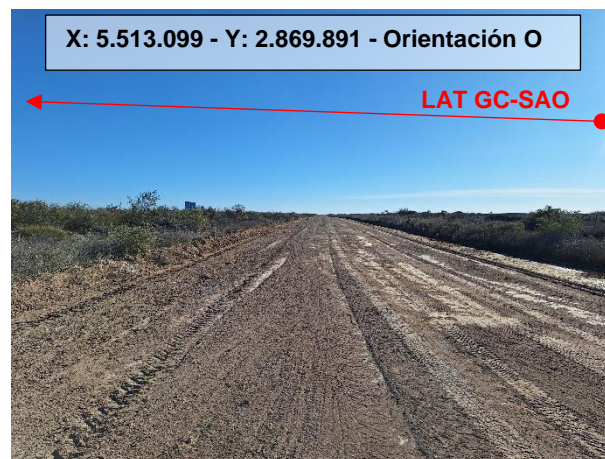
Fotografía N° 15: Punto 8 – Interferencia con camino rural (Progresiva 40,437 km).
