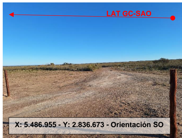
Fotografía N° 28: Punto 15 – Interferencia con camino rural (Progresiva 84,499 km).
