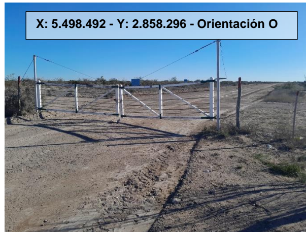
Fotografía N° 20: Punto 10 – Interferencia con camino de acceso a establecimiento rural (Progresiva 59,935).
