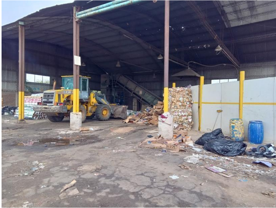
Figura 21 Vista parcial de la zona de prensado y enfardado.
