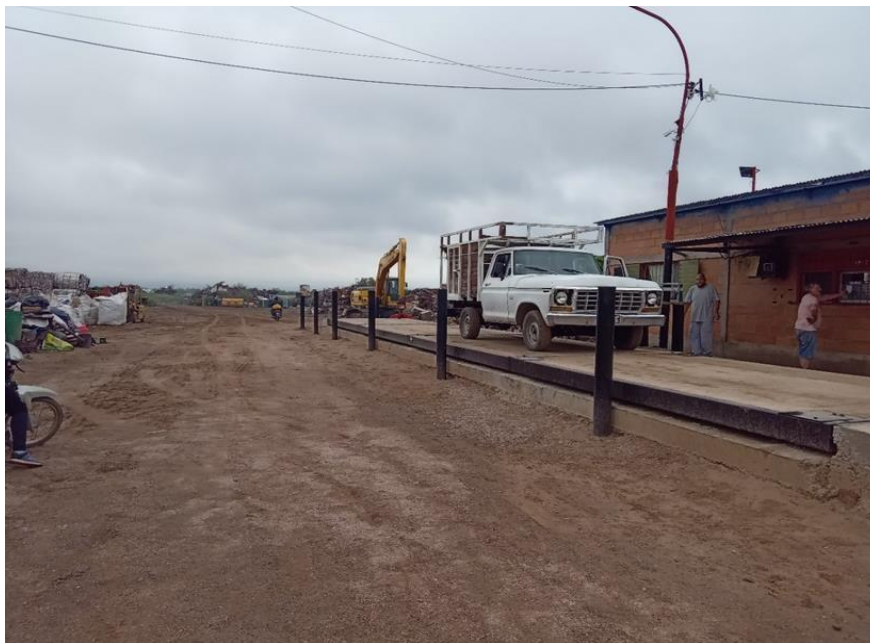
Figura 2.10: Vista del área de pesado de materiales Recuperadora SRL. Fuente: Elaboración propia.
