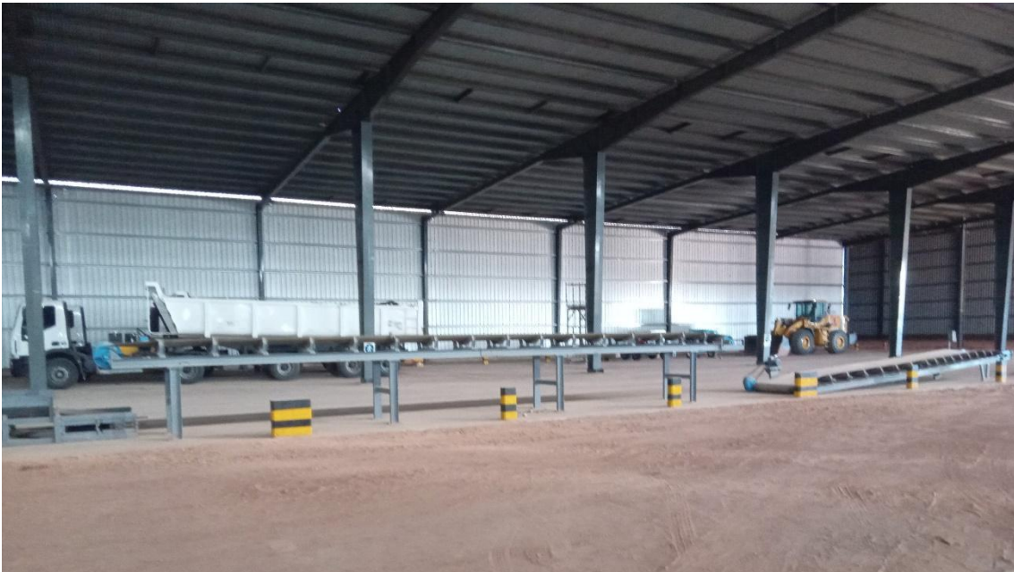
Figura 59 Vista general de un sector de la planta en proceso de montaje.
