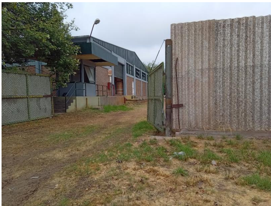
Figura 17 Vista de Acceso Servycom
