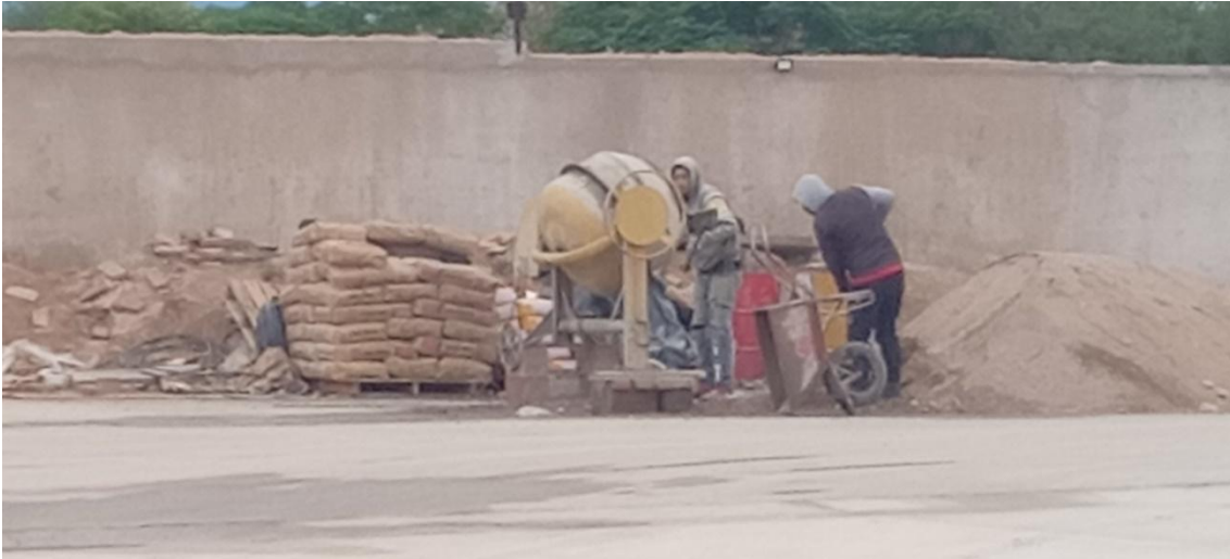
Figura 56 Construcción del nuevo lavadero Ecológico para las Unidades.
