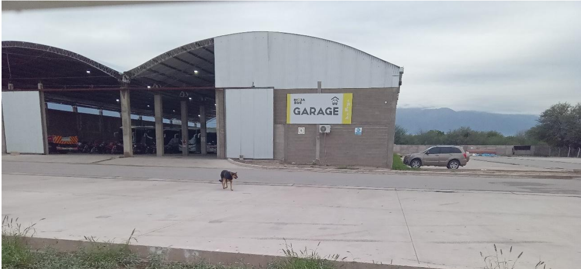
Figura 53 Vista de los garajes de las unidades.
