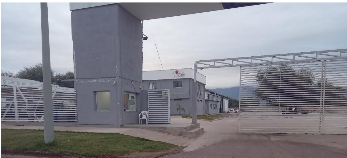
Figura 52 Vista general de entrada al predio.
