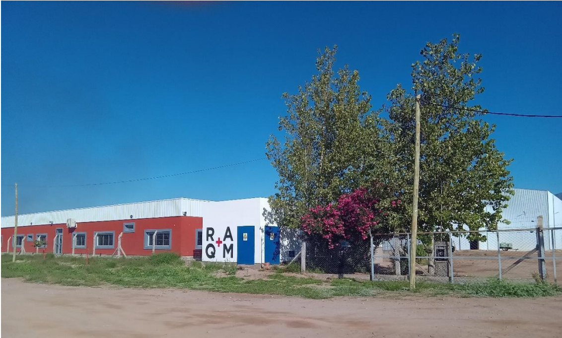
Figura 57 Vista externa de la planta.
