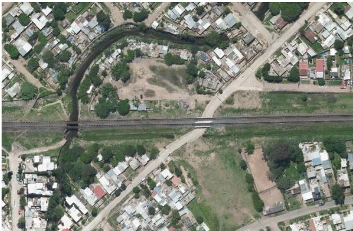
Bajo nivel calle Rawson localidad de Adolfo Sourdeaux
