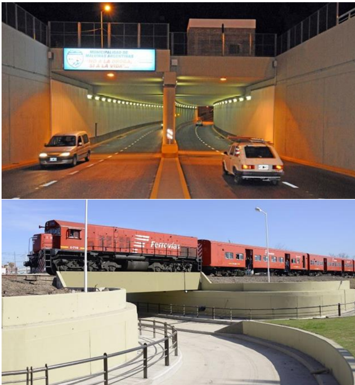
Figura 76: Fotografías del Bajo nivel Av. Sesquicentenario (Ex ruta 197) Bajo nivel calle Rawson Bajo nivel Gral. Juan G. Lemos (Ex ruta 202) Bajo nivel Grand Bourg
