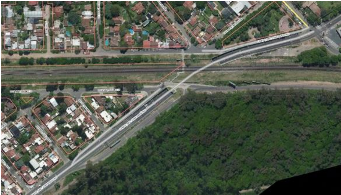
Bajo nivel Ruta Provincial N.º 24
