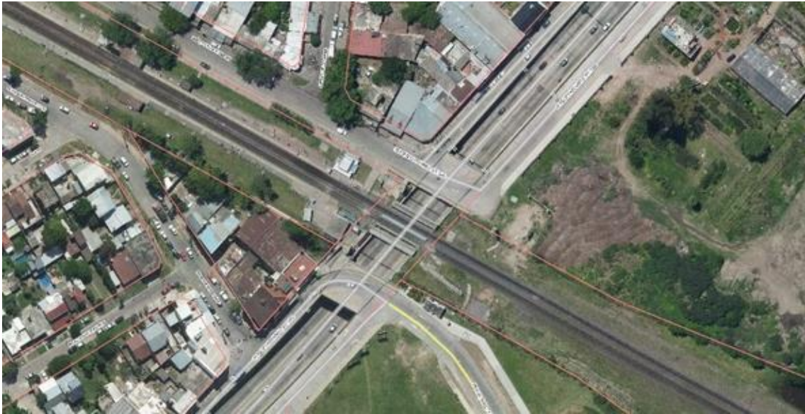
Bajo nivel Avda. Del Sesquicentenario (Ruta Provincial N°24)
