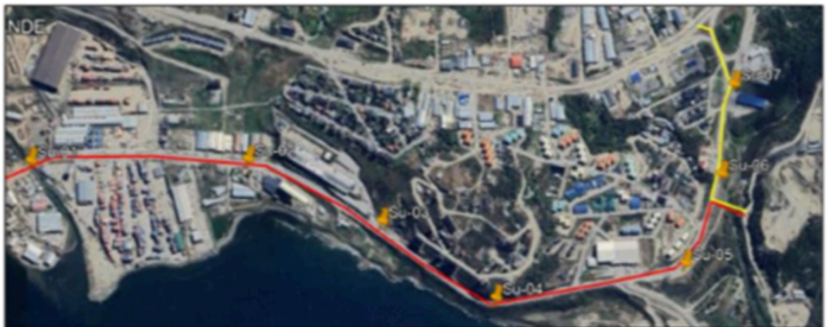
Imagen 16 - Ensayos de calidad del suelo puntos de muestreo para las trazas de electricidad y gasoducto (Fuente: Estudio de calidad del suelo. ANEXO 10)
