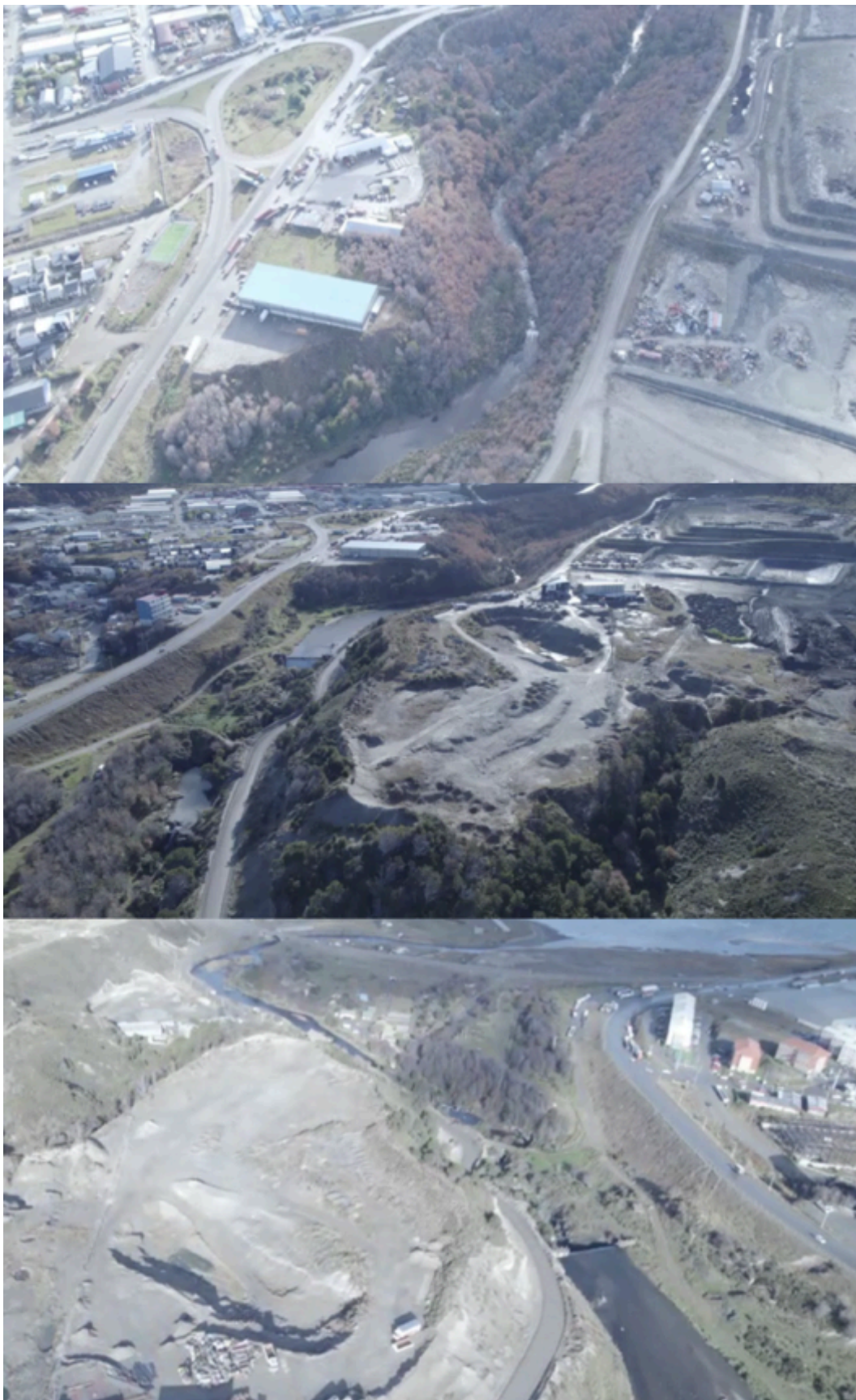
Imagen 6 - Secuencia de imágenes aéreas de la traza del gasoducto desde la Rotonda Ruta 3, hasta el sitio principal.
