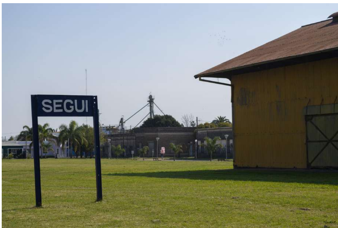
Antigua Estación de Ferrocarril de Seguí
