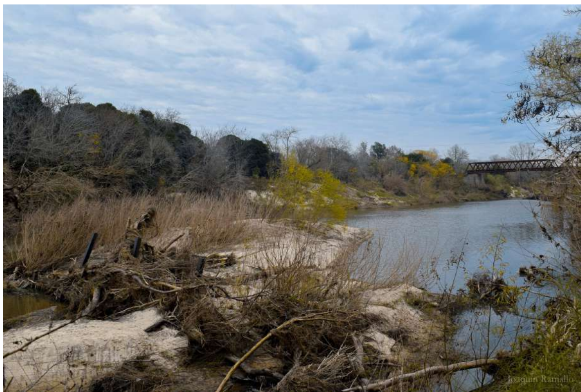
Puente Ferroviario sobre el arroyo Las Conchas, La Picada
