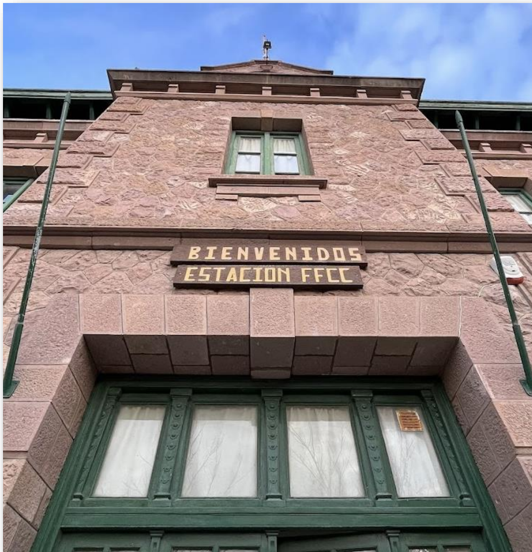
Imagen N.º 11: Frente del Museo Ferroviario, Puerto Deseado
