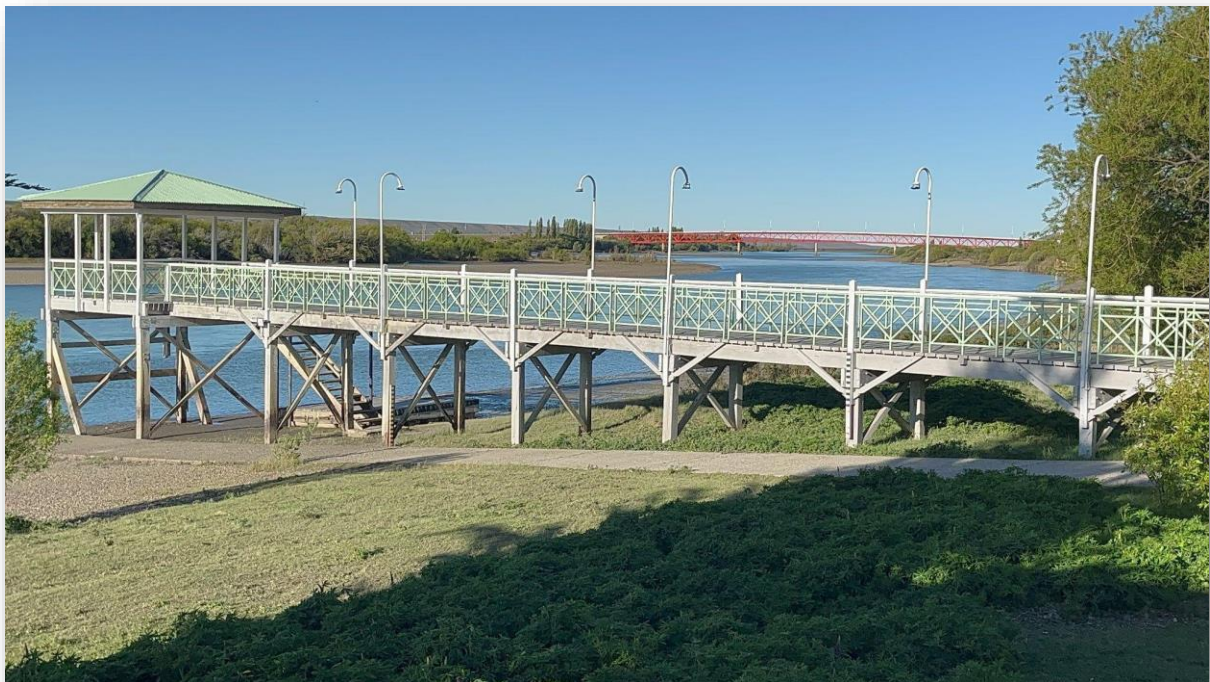
Imagen N.º 8: Muelle sobre el río Santa Cruz en la isla Pavón
