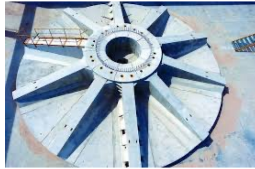
Figura 15. Ejemplo cimiento turbina eólica
