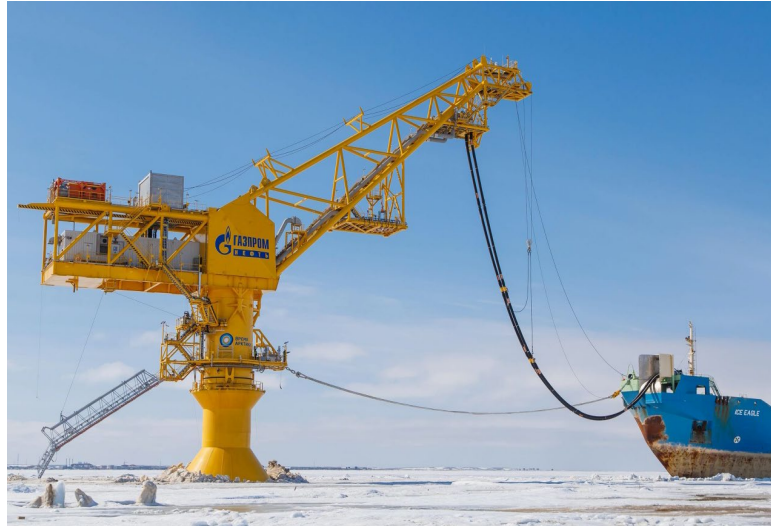
Figura 6. Sistema de carga y descarga tipo spm fixed
