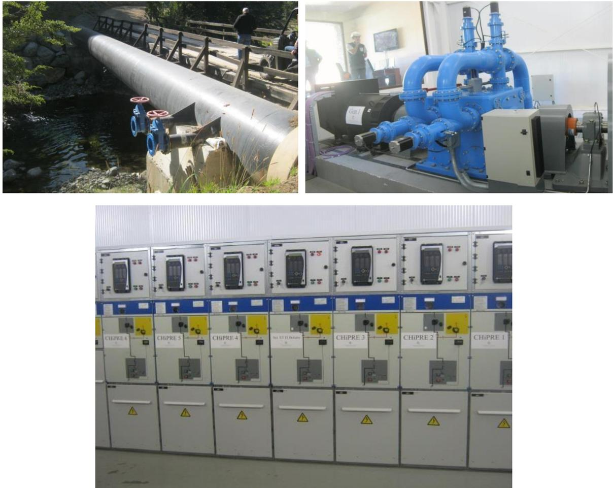
Figura 4.23. Cruce de cañería sobre el río Escondido, generadores y celdas de CH Río Escondido. Fuente: Secretaría de Energía de Río Negro.
