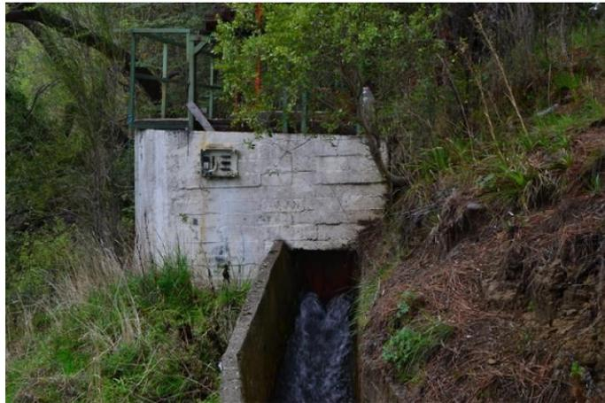
Figura 4.46. Cámara de carga con salida de limpieza. Fuente: Secretaría de Energía de Río Negro e INVAP Ingeniería S.A.
