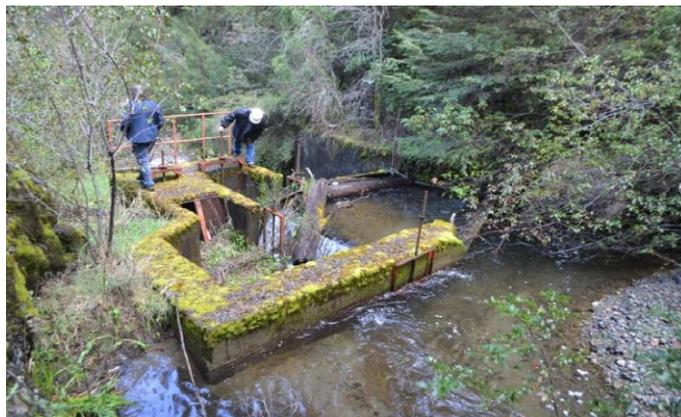
Figura 4.39. Obra de captación, desarenador y cámara de carga. Fuente: Secretaría de Energía de Río Negro e INVAP Ingeniería S.A.
