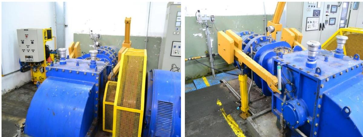
Figura 4.51. Mini turbina con volante y generador (izquierda) y Central Hidroeléctrica N°1: mini-turbina de flujo cruzado con sus accionamientos (derecha). Fuente: Secretaría de Energía de Río Negro e INVAP Ingeniería S.A.
