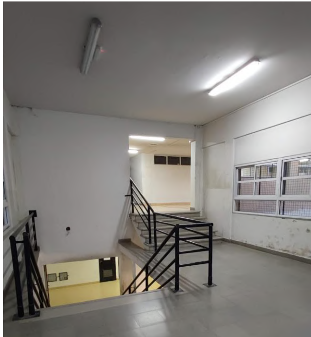
Figura 115: Vista de iluminación de espacios comunes (Pasillos y Escaleras) - CET N°6
