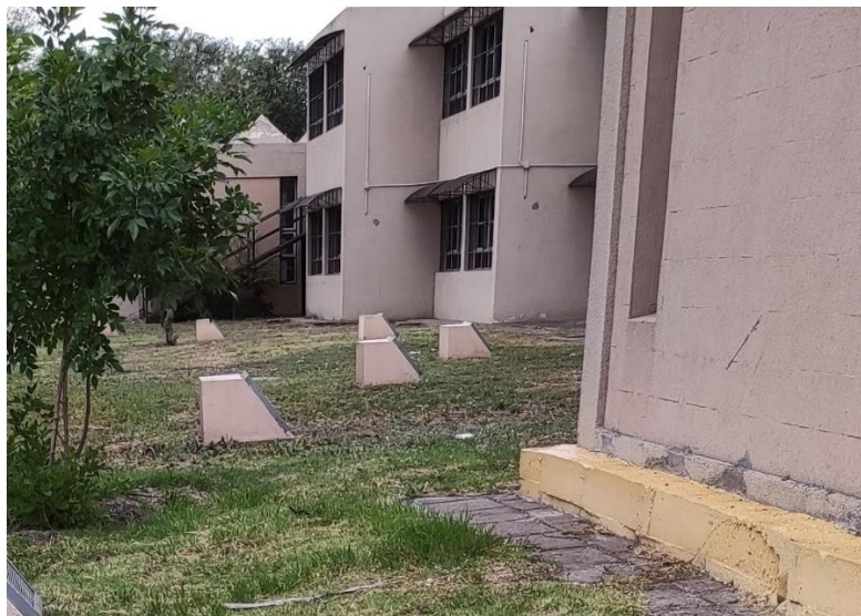
Figura 114: Parasoles de las aulas - CET N°6
