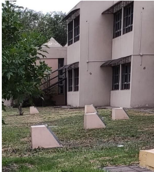
Figura 123 - Parasoles exteriores sector aulas – CET N°6
