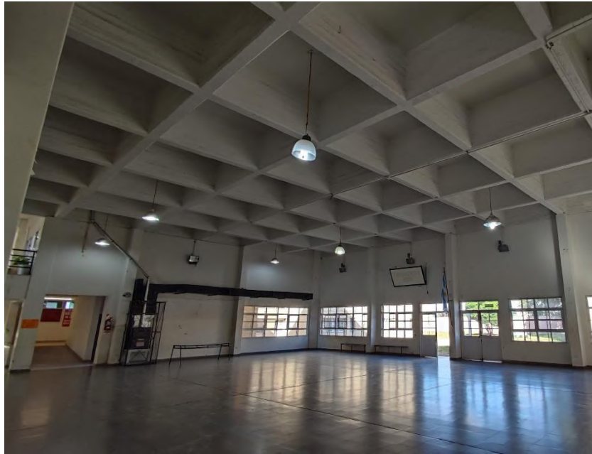
Figura 116: Iluminación en espacios comunes (SUM) - CET N°6
