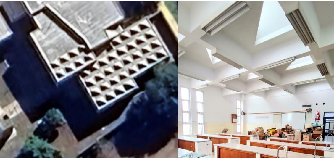
Figura 130 - Lucernarios del tipo dientes de sierra existentes en la escuela – CET N°6
