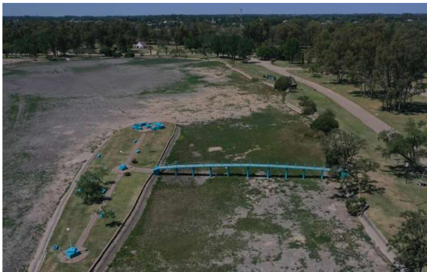
Figura N° 35. Puente de acceso a la isla
