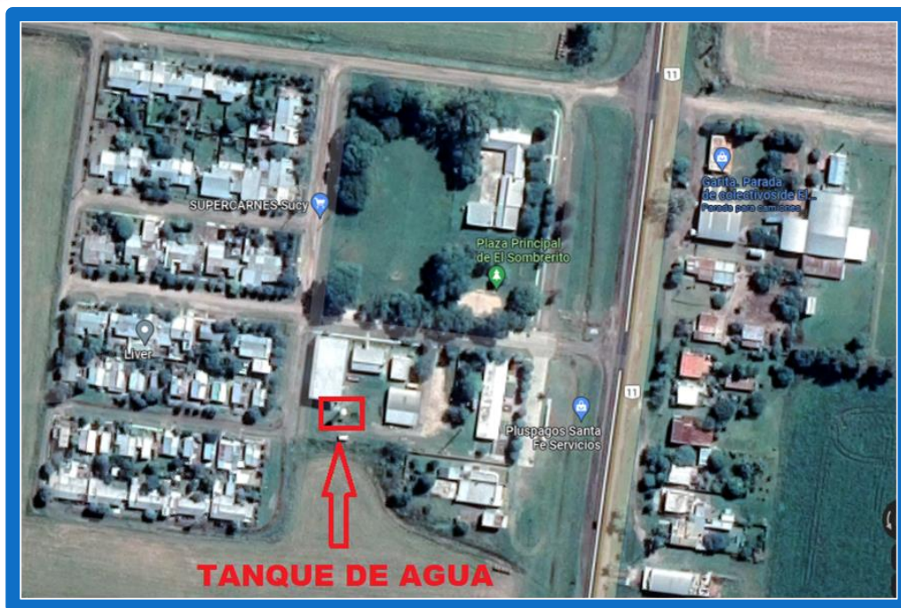
17: Ubicación del tanque de agua el entramado urbano – El Sombrerito. Fuente: Comuna El Sombrerito
