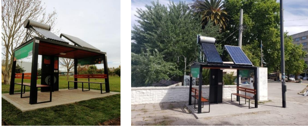
Figura 9: Ejemplos de "puntos solares" instalados en municipios de Río Negro
