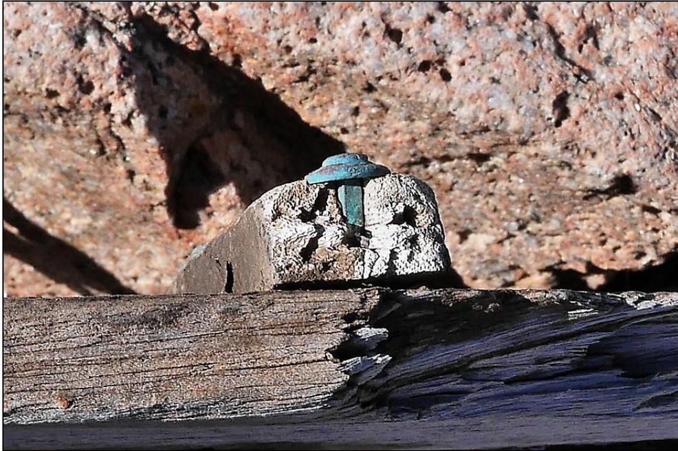
Figura 66: Detalle de un clavo remachado sobre arandela
