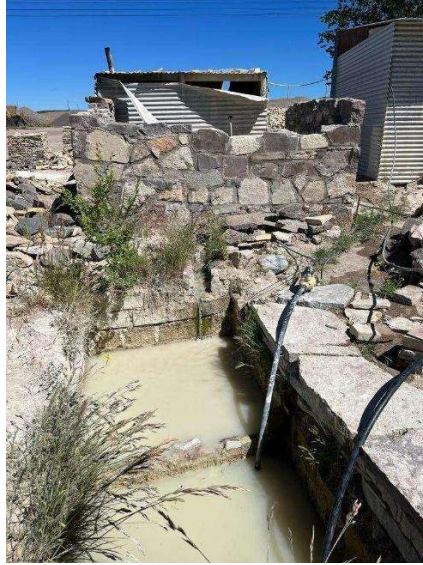
Imagen 18: Bombas y piletas en industria lajera.
