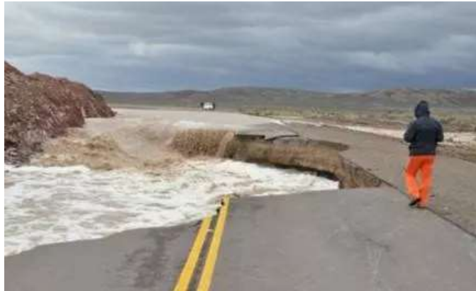
Figura 29: Ruta 23 afectada entre Los Menuços y Maquinchao (Foto gentileza Digital 23).
