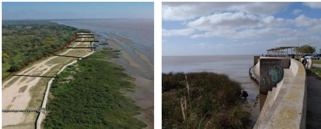
Figura 32: obras del paseo costero y murallón terminado, partido de Berasategui
