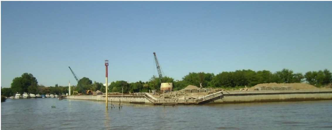
Figura 26: barrio cerrado en construcción, río Luján - San Fernando
