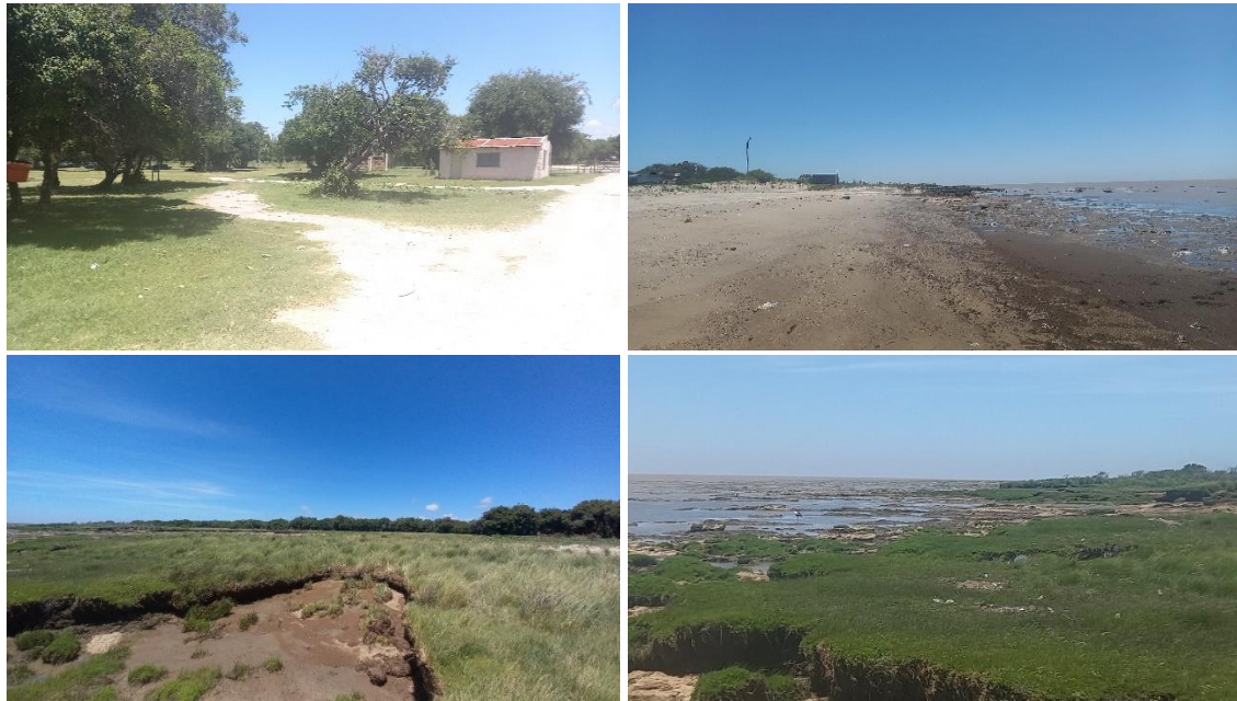
Figura 38: Punta Piedras, partido de Punta Indio: acceso al faro de Punta Piedras (arriba) y perfil de costa con presencia de rasgos erosivos sector camping El Descanso (debajo)
