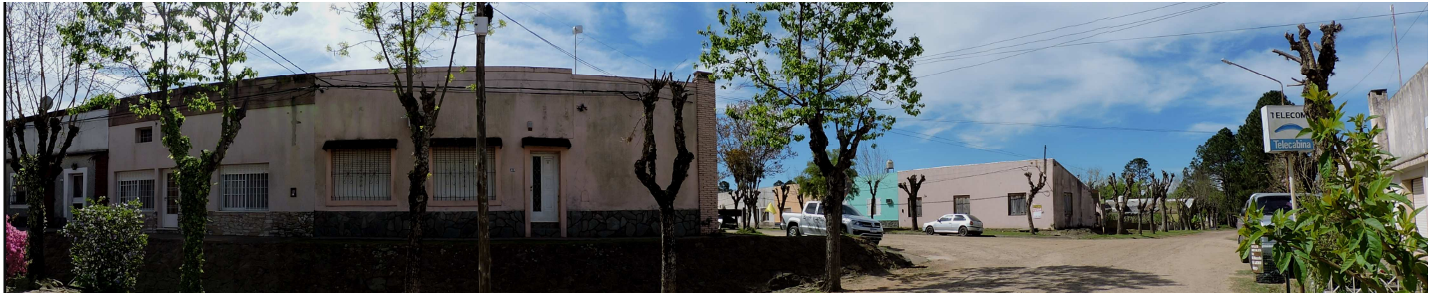
Corralon grande – manzana 129 – calle JD Peron esquina San Martin – CANALETA – manzana 130 (1er escuela)
