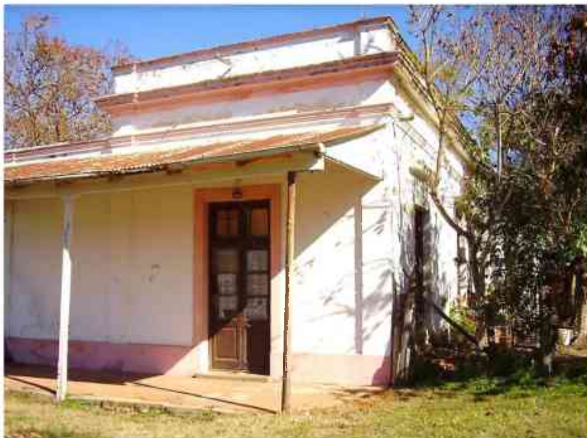
Correo con vivienda en "los chalets"
