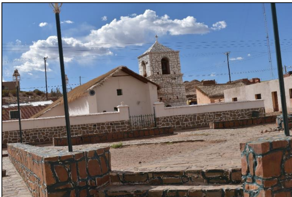
Iglesia de Huancar visitada durante los relevamientos.
