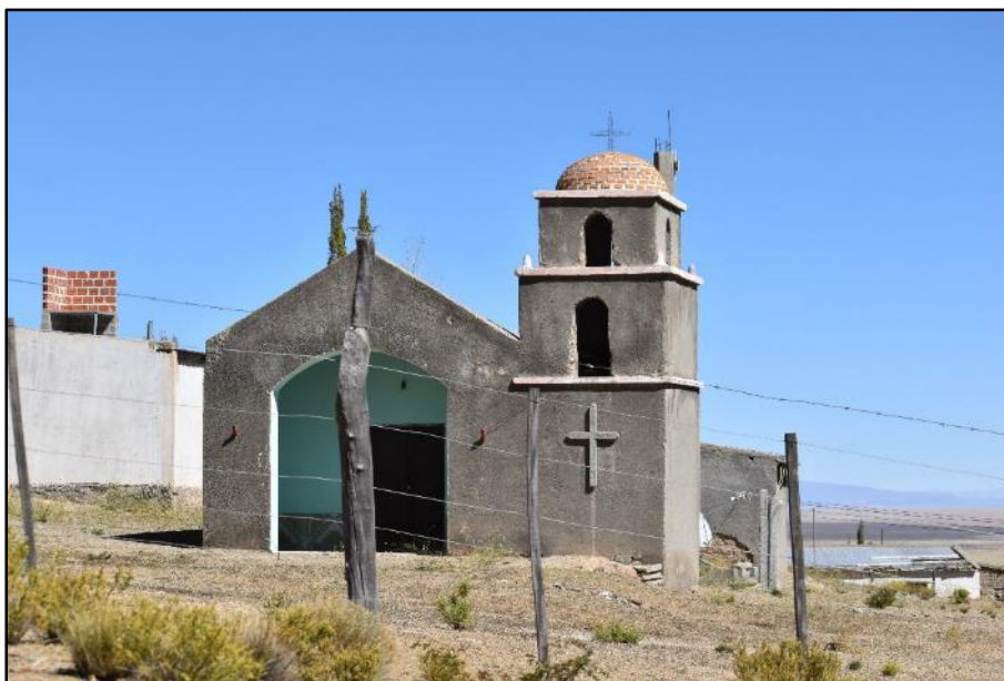
Figura 21: Capilla en la localidad de Quebraleña.
