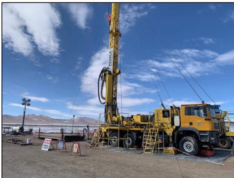
Figura 38: Detalle de los equipos de perforación.
