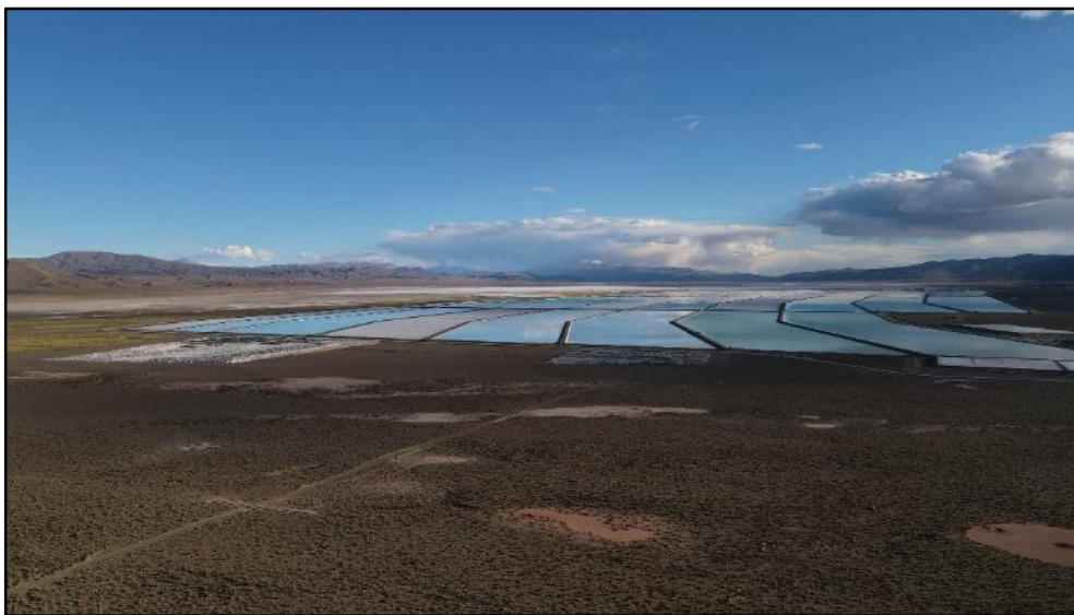
Figura 39: Vista general de piletas de evaporacion de EXAR.
