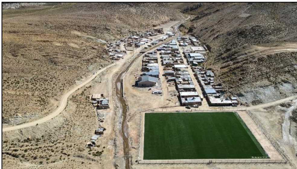
Figura 34: Vista general de la localidad de El Toro.
