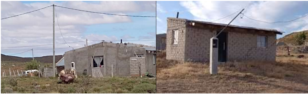
Figura n°4. Cableado aéreo de una UCE.
