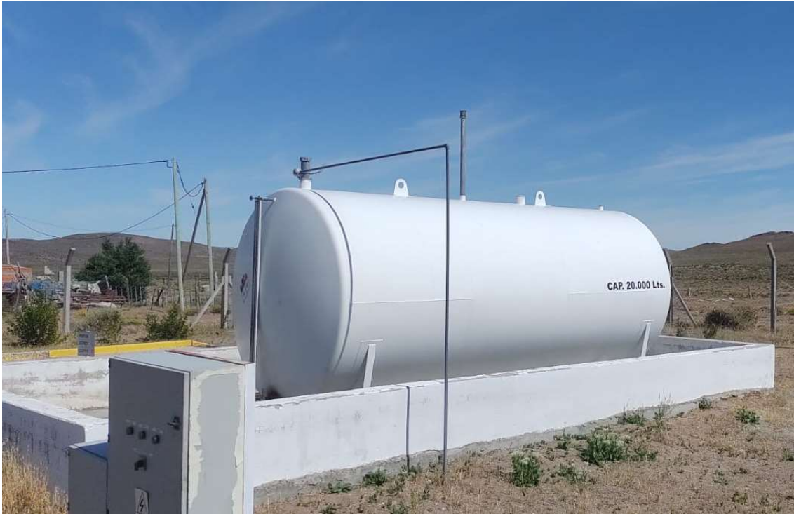
Figura n°11. Tanque de almacenamiento de combustible de 15.000 lts.
