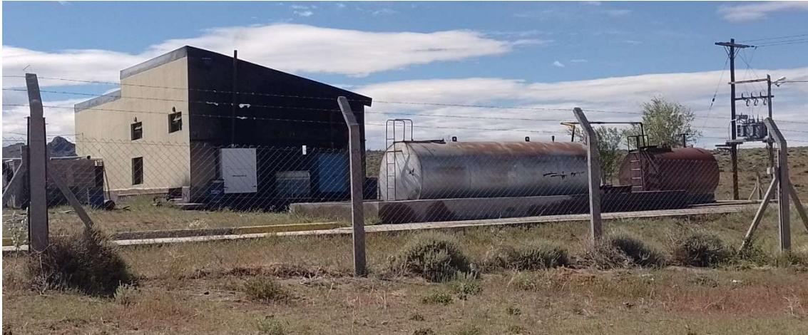
Figura n°12. Instalaciones edilicias para la generación.
