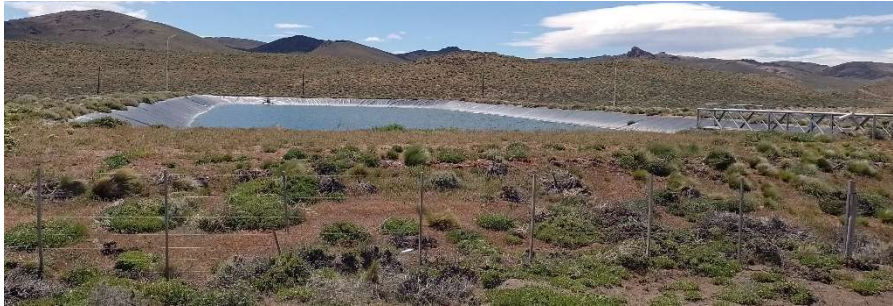
Figura 35. Piletones de tratamiento de efluentes líquidos cloacales a cielo abierto de Lagunita Salada, provincia del Chubut. Fuente: Imagen relevada in situ por el responsable técnico del proyecto, año 2022.
