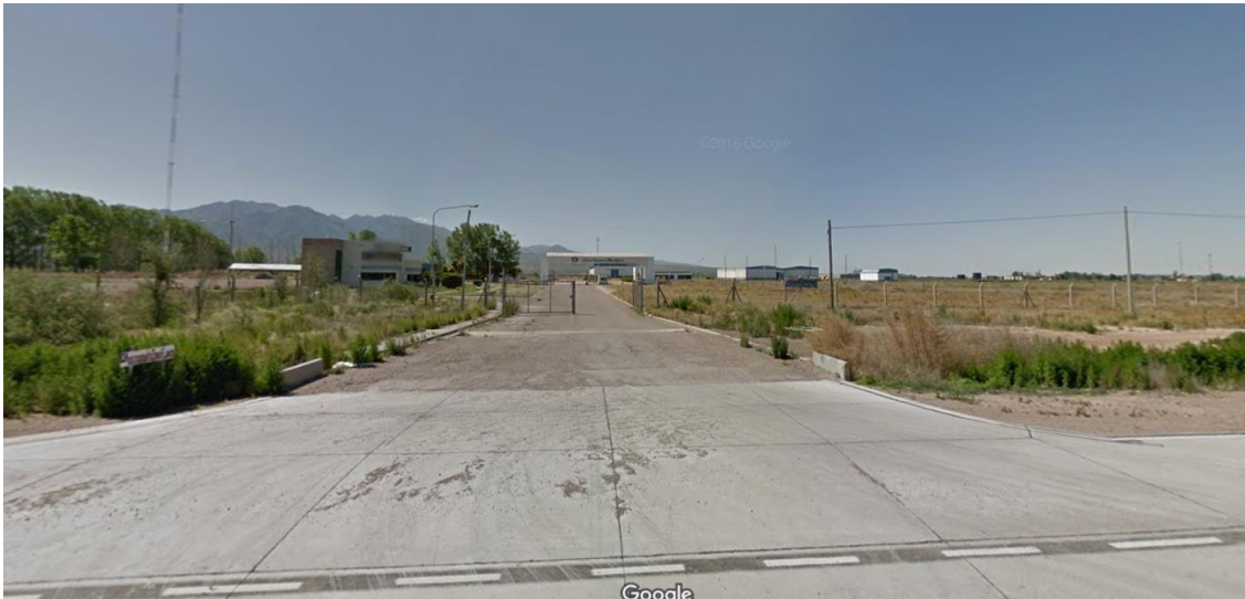
Figura 29: Acceso a Zona Franca Mendoza
