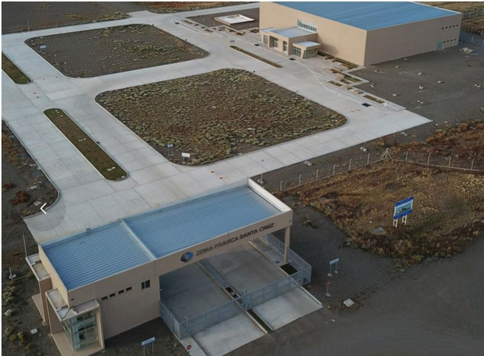
Figura 41: Edificio de venta minorista Zona Franca Santa Cruz
