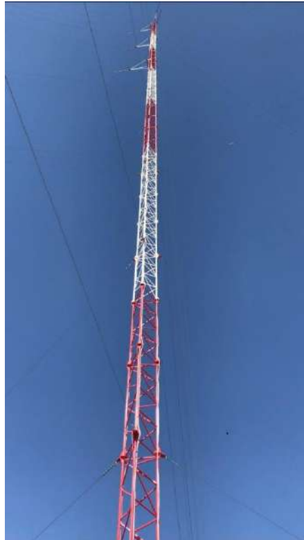
Ilustración 50 – Torre de medición de vientos
