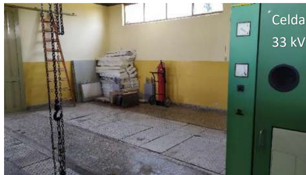
Ilustración 67 – Espacio físico disponible para ampliación en ET Realicó
