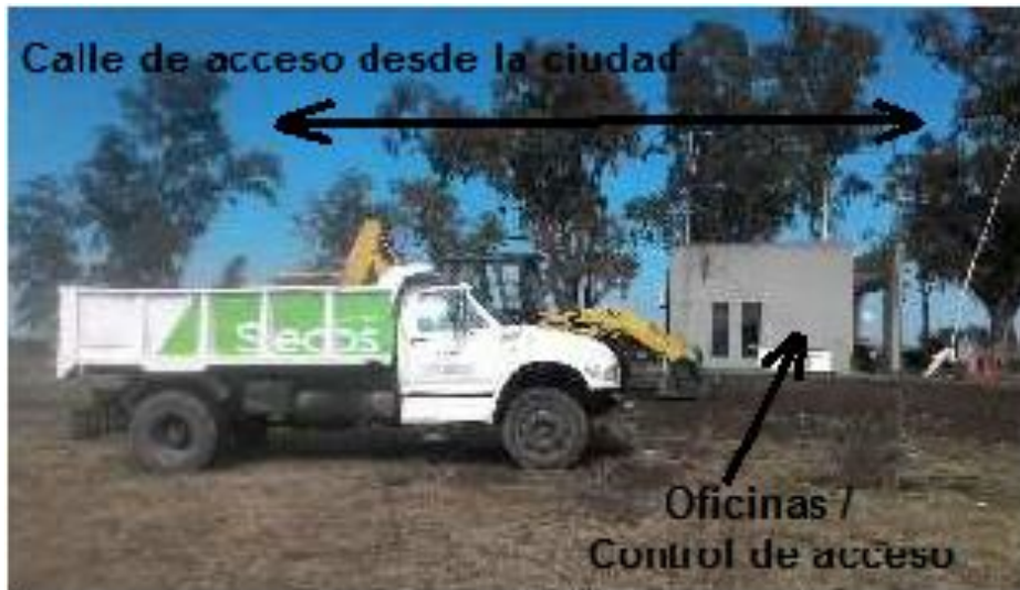
Foto n° 1: Vista de oficinas en acceso al predio de disposición final de RSU. Al fondo, arboleda ubicada sobre la calle de acceso por la que se llega desde la ciudad
