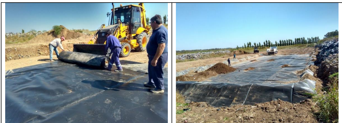
Imagen de construcción celda sanitaria: colocación de membrana (fotos municipio)
