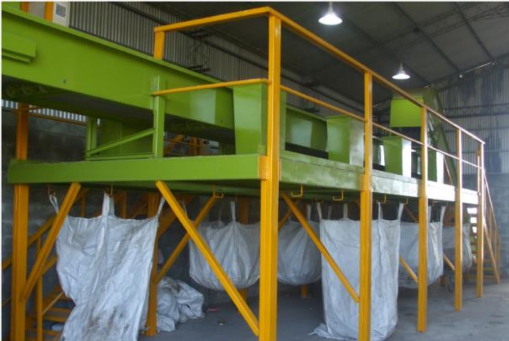
Foto nº 21: Vista interior, sector de separación propiamente dicho
