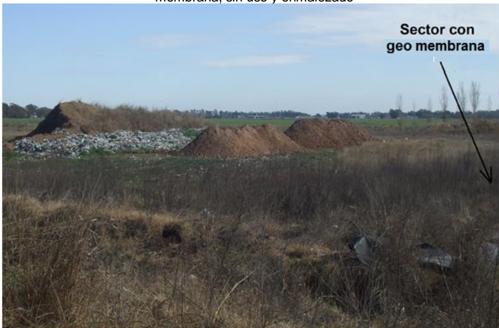
Foto nº 10: Vista de sector menor preparado para enterramiento de RSU
