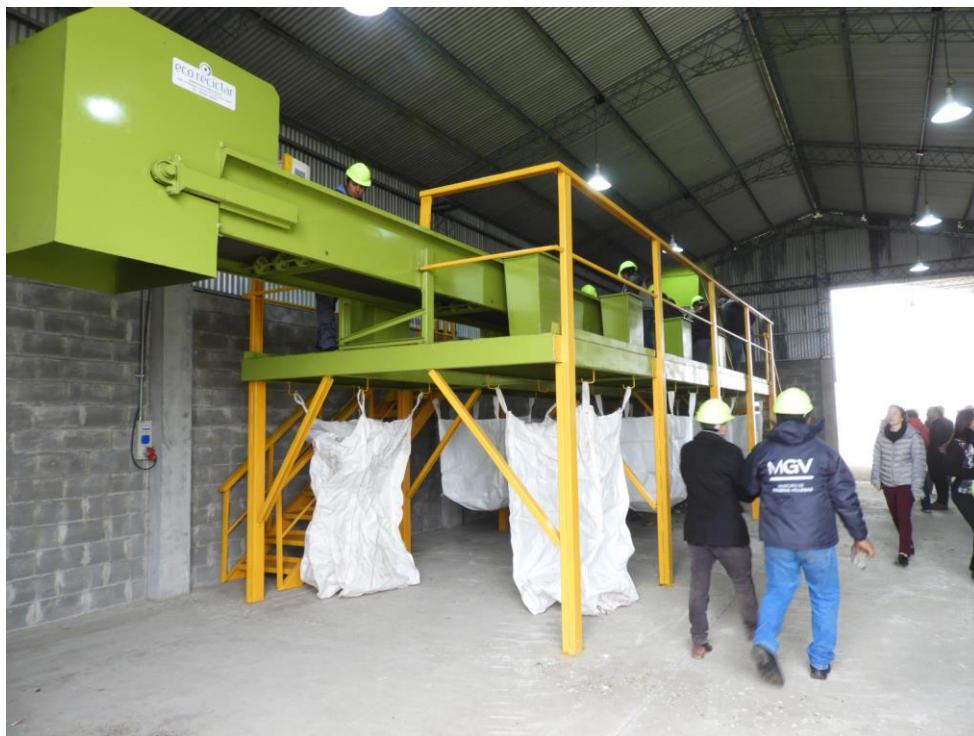
Imagen inauguración planta de separación
