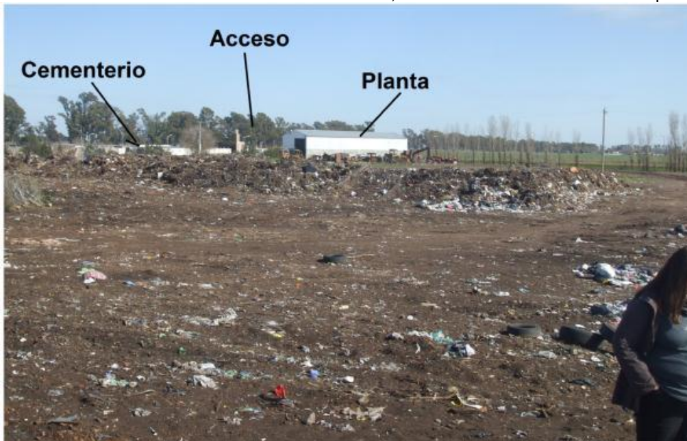
Foto n 4: Vista hacia el acceso desde el sector de disposición / quema de restos de poda y descarga de contenedores
