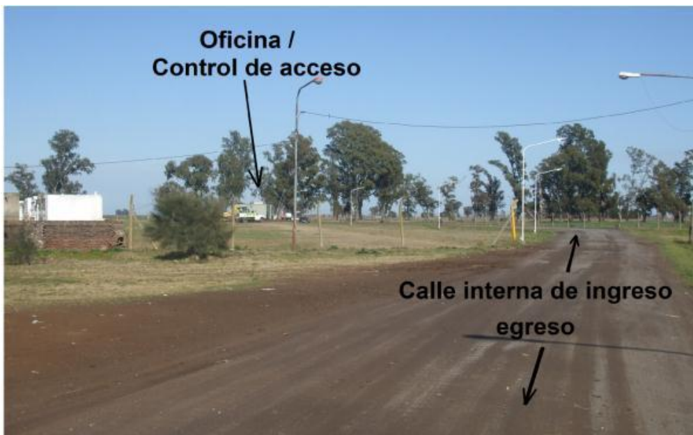
Foto n° 2: Vista desde el interior del predio hacia la calle vecinal de acceso, y sector de oficinas
