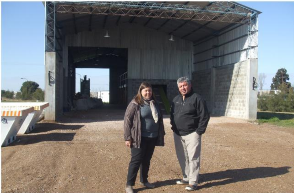
Foto nº 16: Vista exterior, del frente, de la Planta de Separación de Residuos
