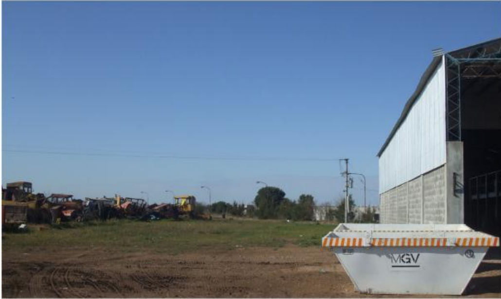
Foto nº 15: Vista, lateral posterior, de la Planta de Clasificación, con maquinaria en desuso
