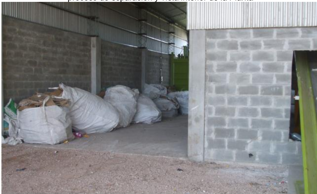
Foto nº 19: Vista hacia el interior de la Planta, sector de almacenaje de productos separados para su comercialización
