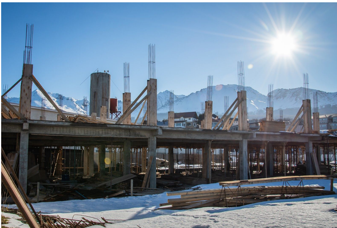
Imagen 2. Construcción de viviendas en Río Pipo.
