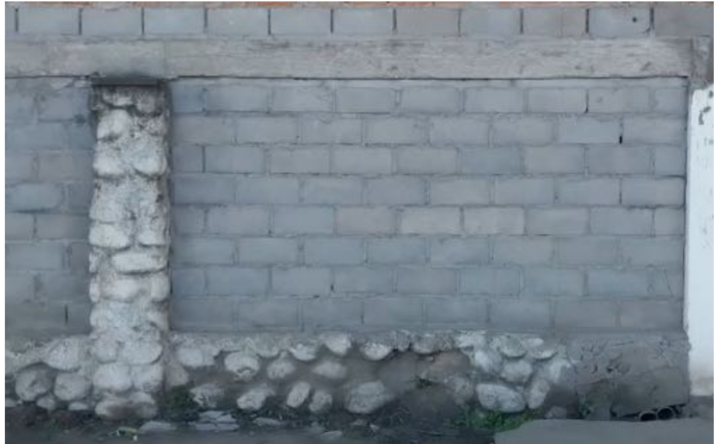
Figura 62: MURO DEL PENAL REALIZADO CON BLOQUES DE TALLER BLOQUERA
