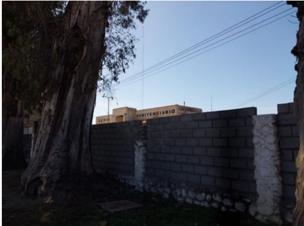
Figura 45: VISTA EXTERIOR SERVICIO PENITENCIARIO UNIDAD 3 - CONCEPCIÓN -
