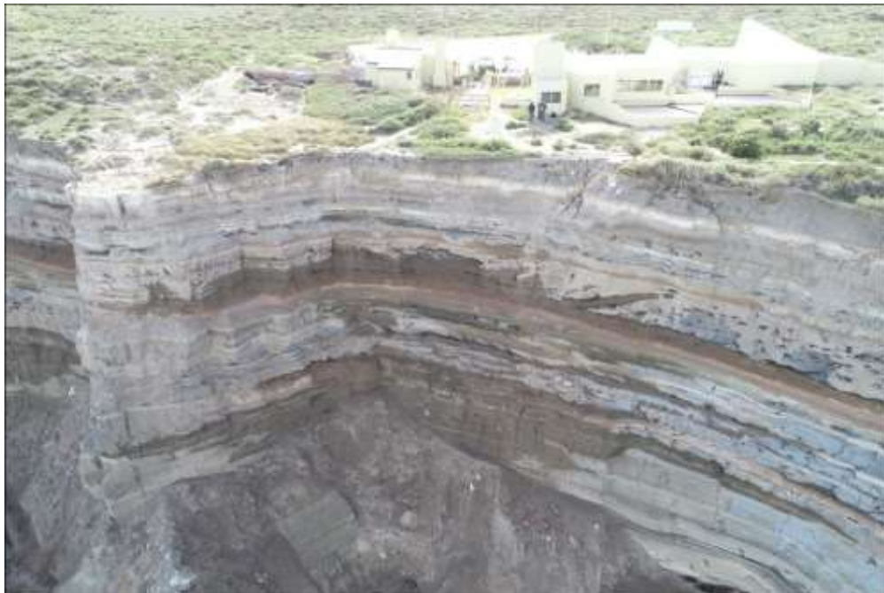
Figura 5.7: Areniscas del Miembro superior donde se observa que en el techo de los estratos arcillosos escurre agua proveniente de la infiltración de aguas superficiales, humedeciendo la pared del acantilado
