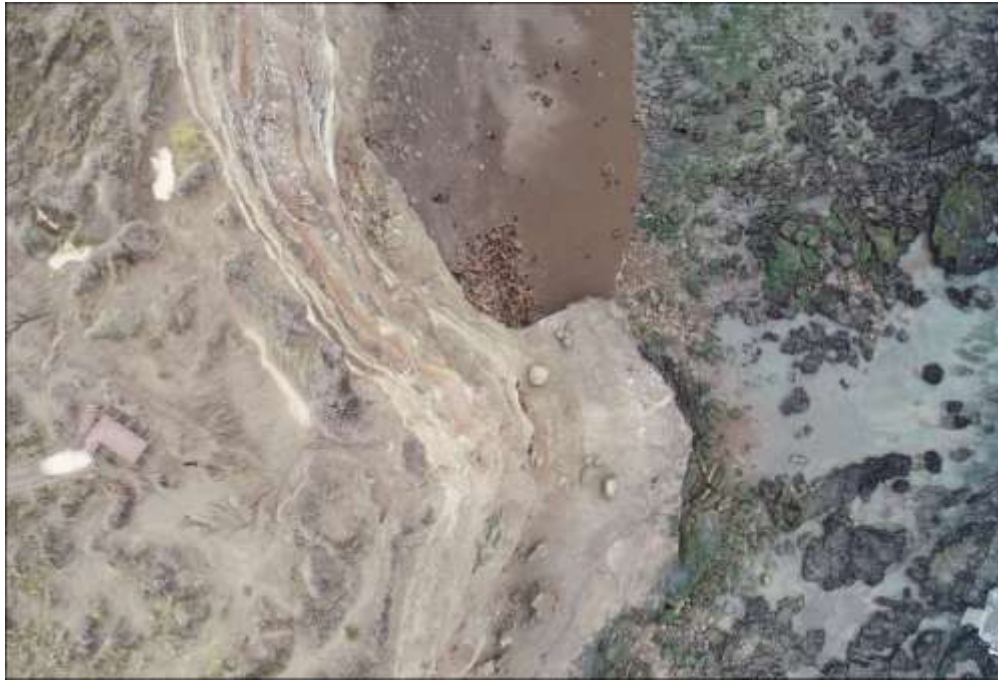
Figura 5.8: Escurrimientos superficiales con carcavamiento del sustrato en zonas de pasarelas y miradores.
