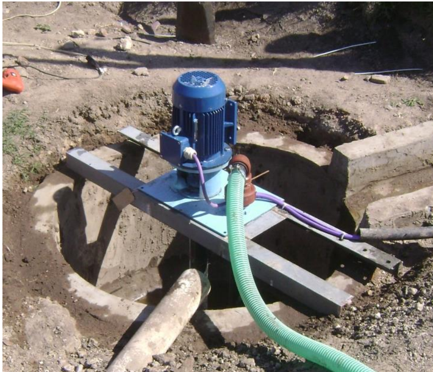
Figura 8: Cámara de Bombeo
