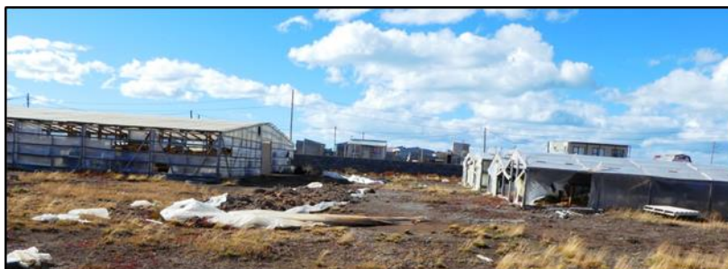
Figura 6. Capacidad instalada (Invernaderos para el secado de las fibras) en Río Grande.
