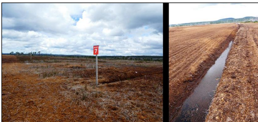
Figura 17. Drenaje limpio y en buenas condiciones.
