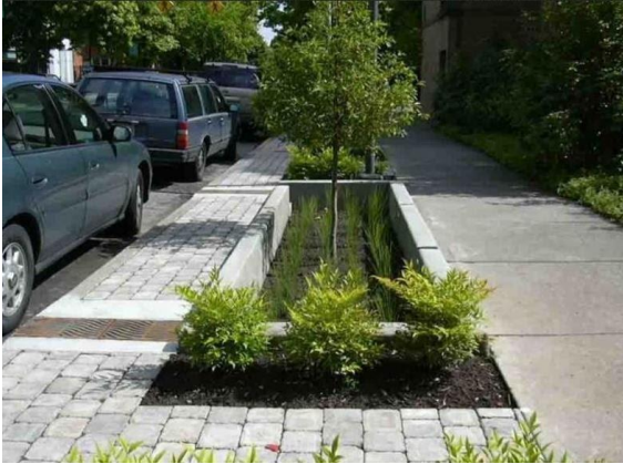
Distintos tipos de veredas con superficie de infiltración
