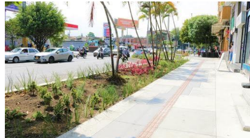
Distintos tipos de veredas con superficie de infiltración
