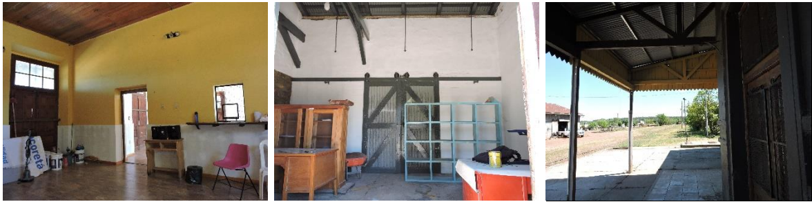
Fotos: Tareas de mejoramiento y puesta en valor en el interior de la ex estación ferroviaria. Fuente: Propia – Noviembre 2020
