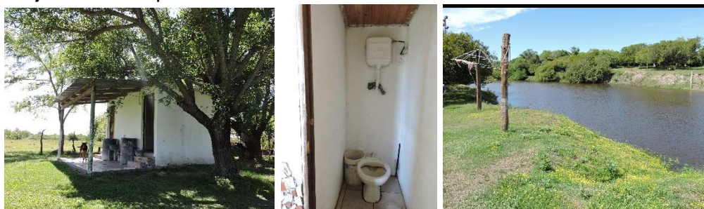
Fotos: Estado de las instalaciones sanitarias y quinchos deteriorados por la crecienta en el balneario. Fuente: Propia – Octubre 2020
