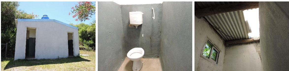
Fotos: Reserva en zona del camping municipal y bloque sanitario a mejorar Fuente: Propia – Noviembre 2020
