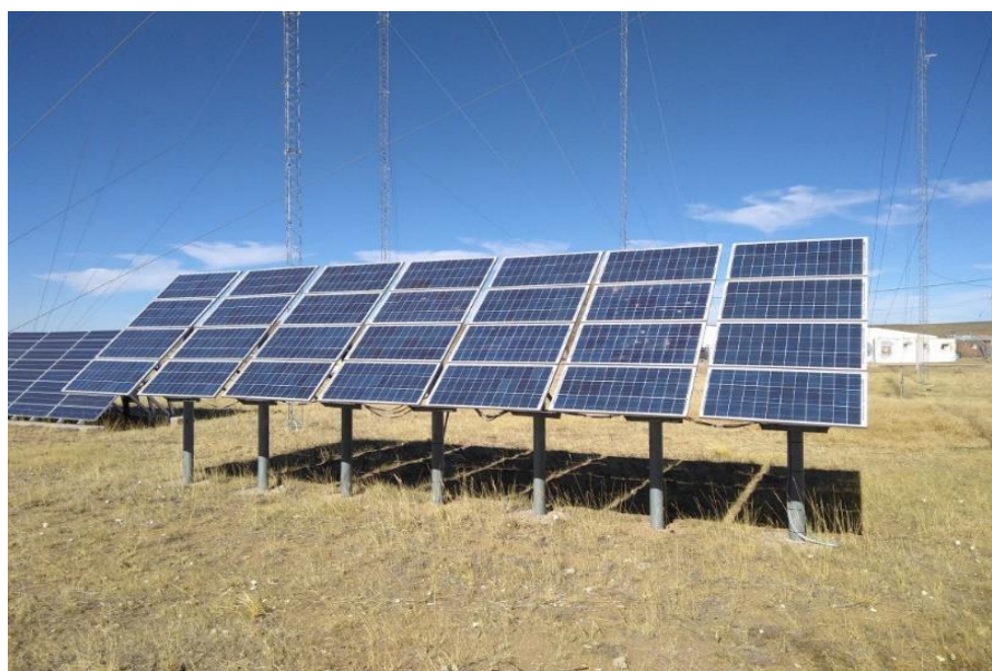
Fotografía N° 1: Equipo fotovoltaico en Laguna Blanca
