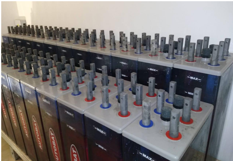
Fotografía Nº 3: Banco de baterías
