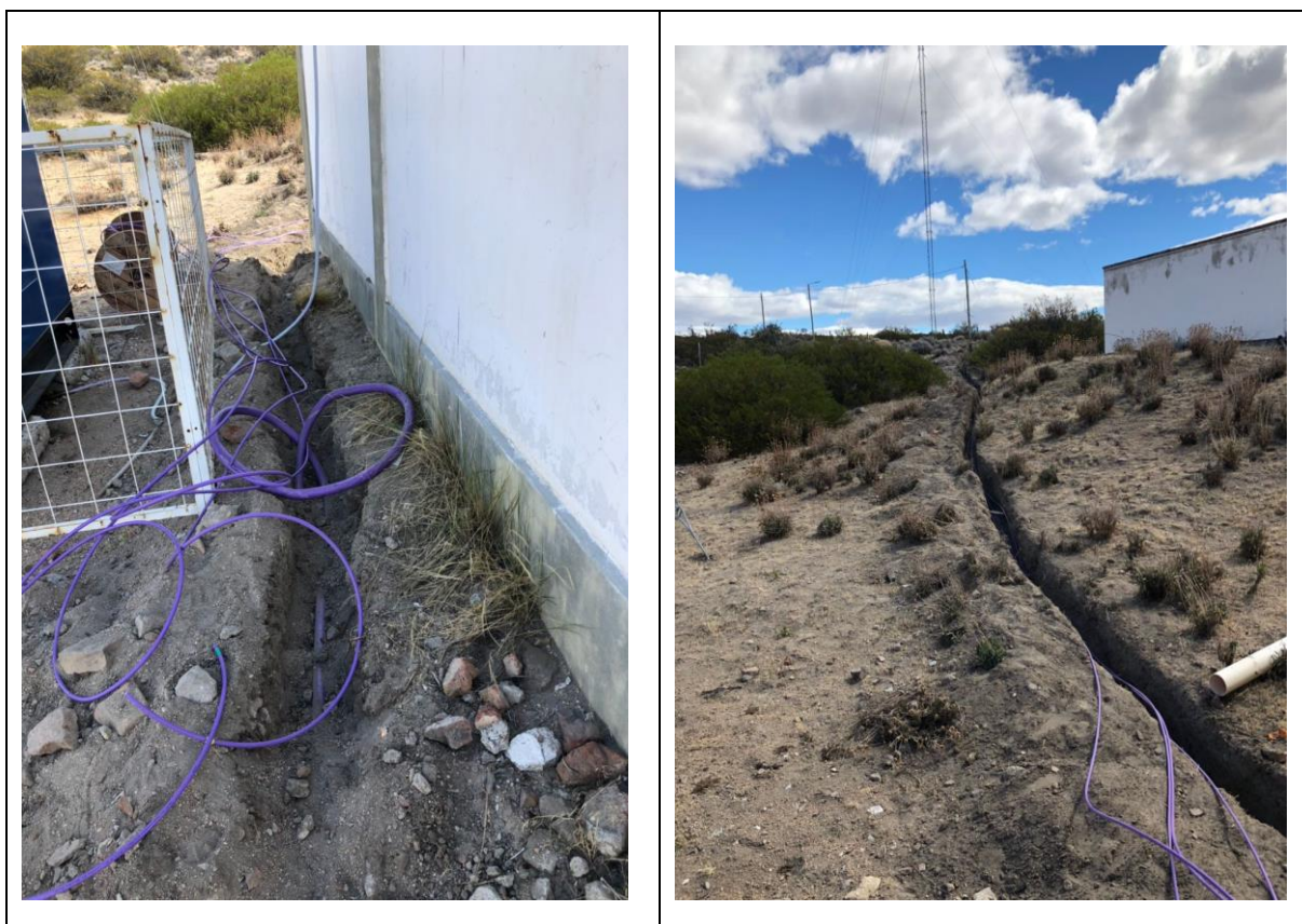
Fotografía N° 15: Zanjeo en el predio en etapa de construcción
